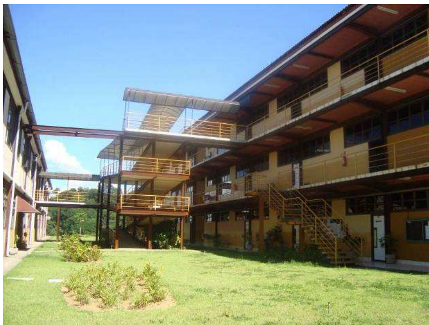
Figura 3.12 - Prédio de salas de aulas do UnilesteMG.
