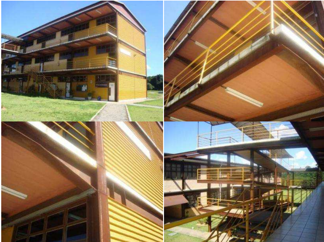
Figura 3.13 - Blocos de salas de aulas do UnilesteMG.
