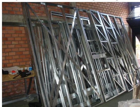
Figura A.4 - 2ª Semana: Montagem dos painéis
