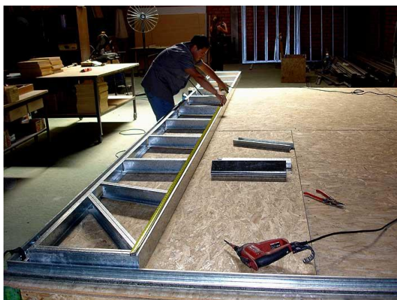
Figura A.3 - 2ª Semana: Montagem dos painéis
