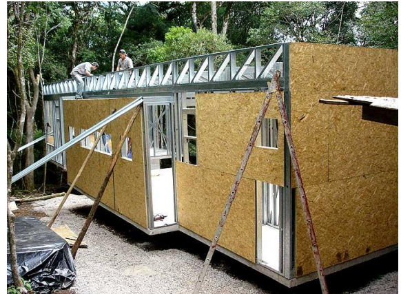
Figura A.10 - 5ª Semana: Instalação dos painéis
