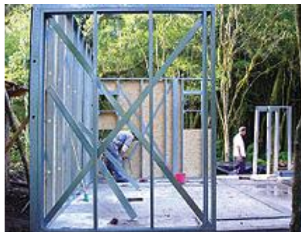
Figura 2.21 - Refúgio São Chico em construção
