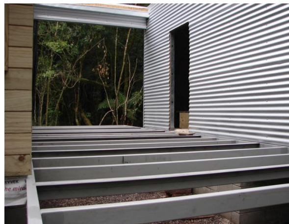
Figura 2.23 - Instalação da estrutura metálica para o deck com piso em madeira
