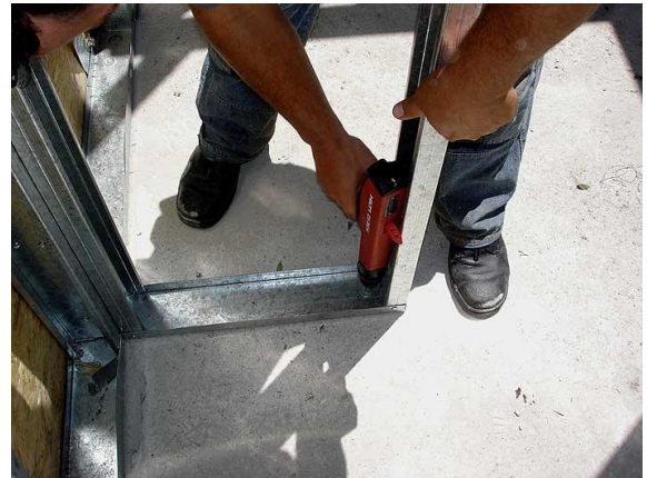
Figura A.8 - 4ª Semana: Instalação dos painéis
