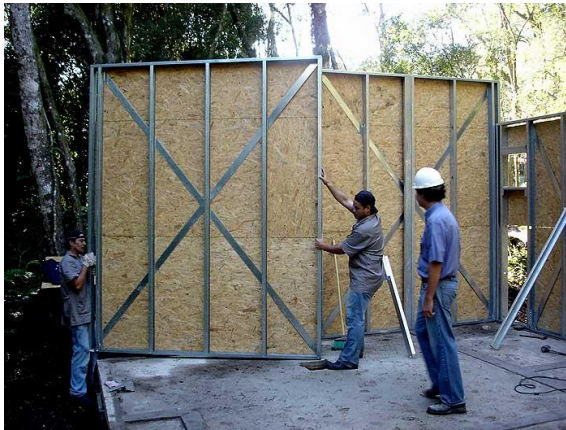
Figura A.7 - 4ª Semana: Instalação dos painéis
