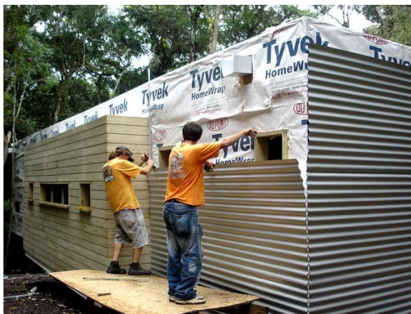
Figura 2.22 - Instalação do revestimento externo
