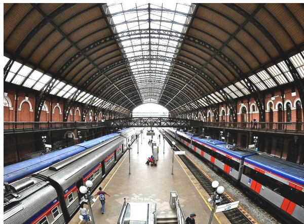
Figura 2.2 - Interior da Estação da Luz, São Paulo
