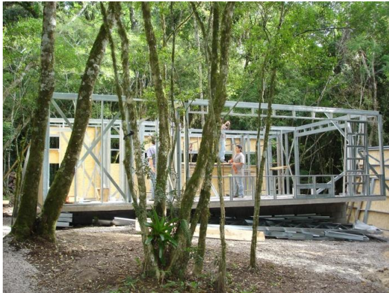
Figura A.9 - 5ª Semana: Instalação dos painéis
