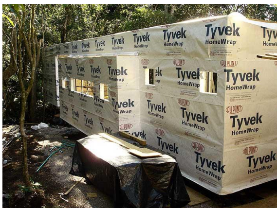
Figura A.11 - 6ª Semana: Impermeabilização dos painéis
