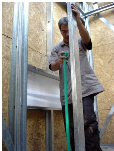
Figura A.12 - 6ª Semana: Instalação hidráulica
