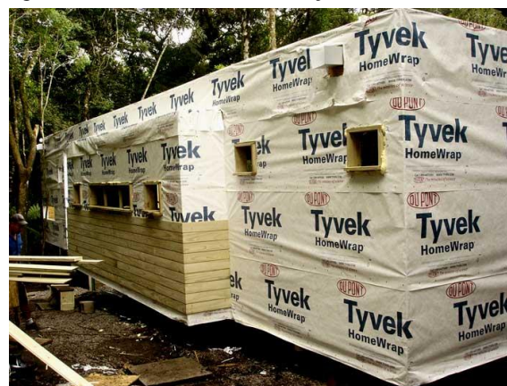
Figura A.14 - 7ª Semana: Instalação dos revestimentos
