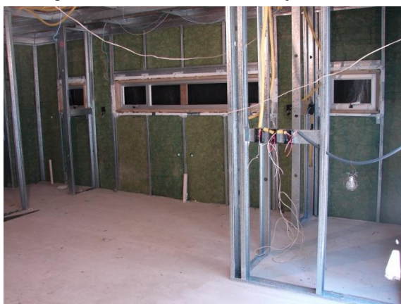
Figura A.13 - 6ª Semana: Instalação elétrica
