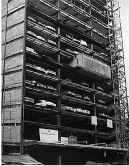
Figura 2.5 - Edifício Garagem América, São Paulo-SP
