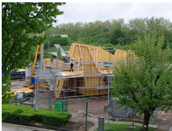
Figura 2.16 - Construção da residência The Villa
