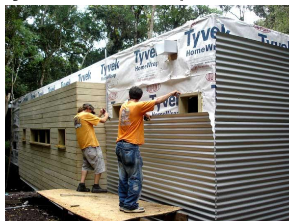
Figura A.16 - 8ª Semana: Instalação dos revestimentos
