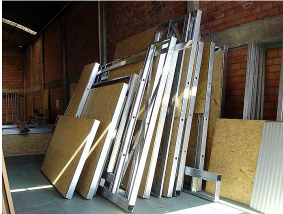
Figura A.5 - 3ª Semana: Montagem e transporte dos painéis
