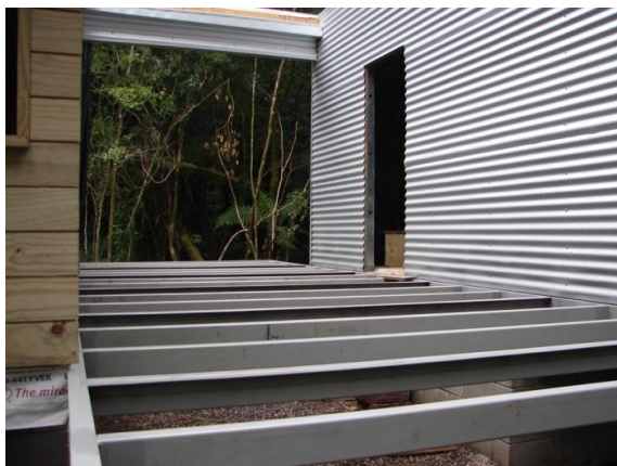
Figura A.17 - 9ª Semana: Instalação da estrutura metálica para deck com piso em madeira
