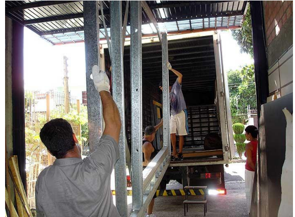
Figura A.6 - 3ª Semana: Montagem e transporte dos painéis
