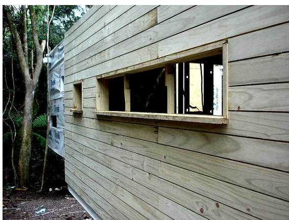
Figura A.15 - 7ª Semana: Instalação dos revestimentos
