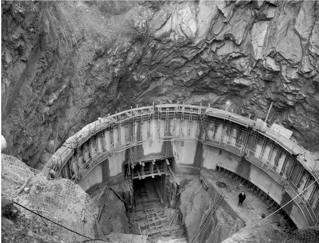
Figura 1.2 Estrutura cilíndrica usada como parede de contenção de uma mina (Eller, 2009)
