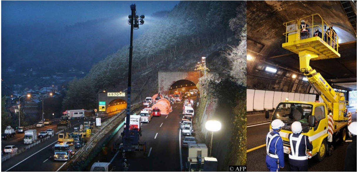
Figura 1.4 Entrada do túnel Sasago no Japão e reparo da sua estrutura de ventilação
