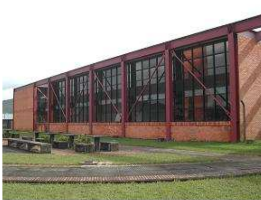
Figura 4.7 – Edificação em estrutura metálica e sistema de fechamento em alvenaria e vidro Fonte: RIBAS, 2006
