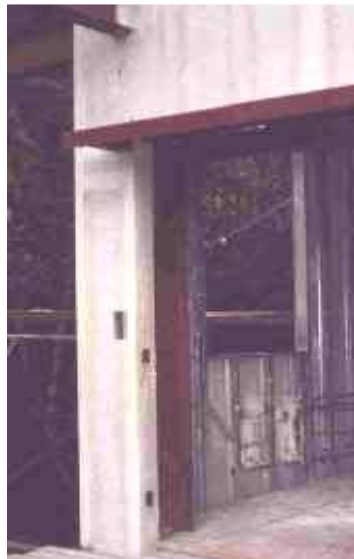
Figura 4.1 – Montagem de fechamento vertical em placa cimentícia Fonte: SALES, 2001
