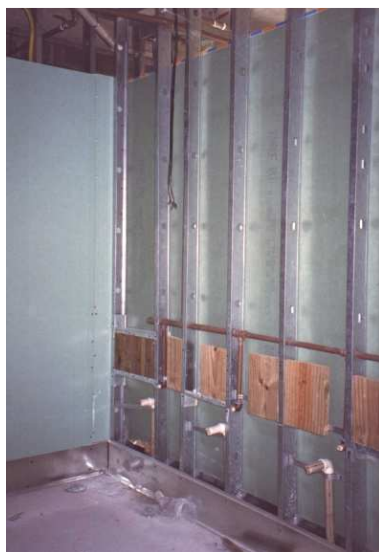
Figura 4.2 – Montagem do sistema de fechamento vertical em gesso acartonado Fonte: SALES, 2001
