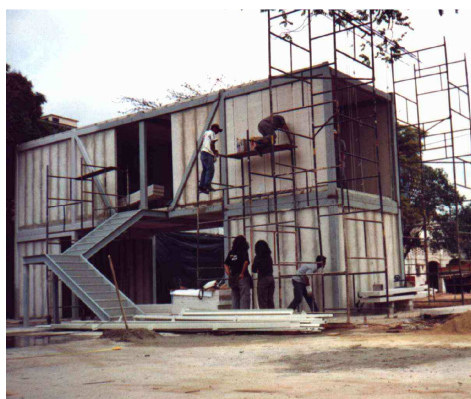
Figura 4.5 – Montagem de fechamento horizontal em painéis de concreto celular autoclavado Fonte: SALES, 2001
