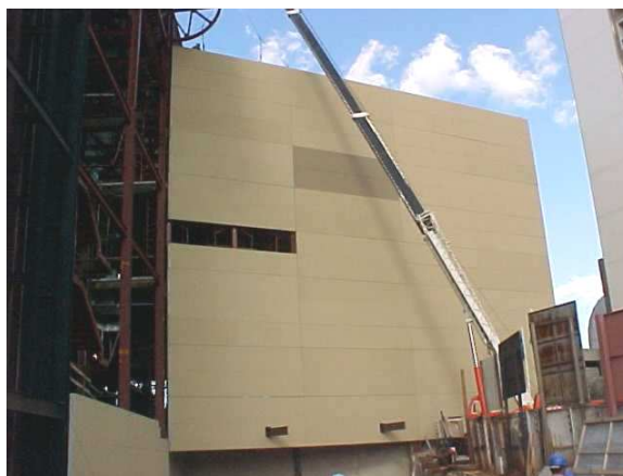
Figura 4.3 – Colocação de painéis de pré-moldado de concreto em fachada Fonte: SALES, 2001
