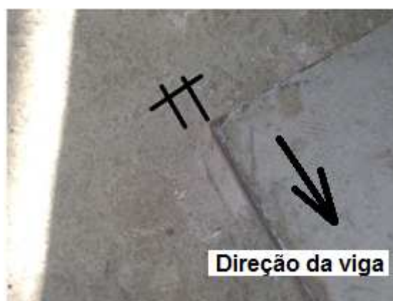
Figura 4.83 – Deslocamento da base do pórtico de reação principal no ensaio MIE2b
