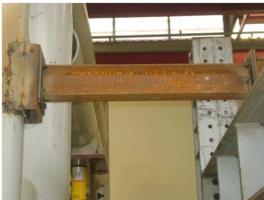
Figura 4.19 – Sistema de estabilização do pórtico PR1
