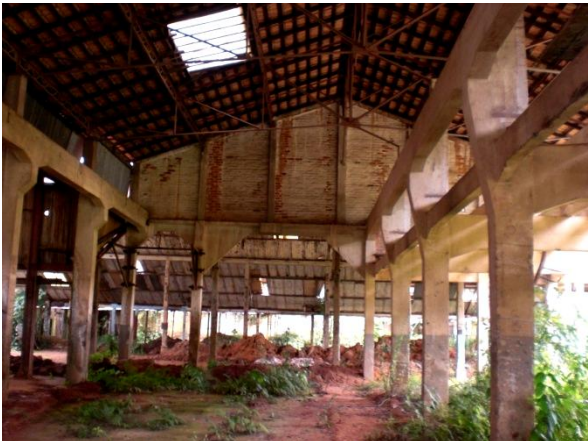
Figura 3. 43: Vista interna - galpão A2 – Oficina Mecânica e Ferraria.
