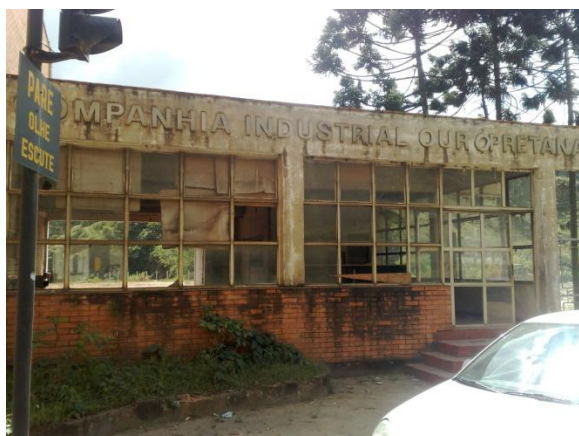
Figura 4. 9: Fachada frontal da construção em concreto armado. Fonte: Acervo pessoal (07/02/2011)
