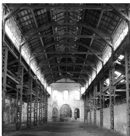
Figura 5. 20: Estrutura híbrida em madeira e metal na Oficina Mecânica - Belgo Mineira Fonte: Acervo Pessoal (15/06/12)
