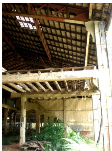
Figura 3. 42: Estrutura em madeira - galpão A1 – Oficina Mecânica e Ferraria. Fonte: Arquivo Pessoal – (março/11)
