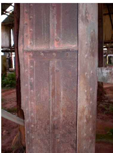
Figura 3. 37: Detalhe pilar em perfis compostos - galpão A1 – Oficina Mecânica e Ferraria.
