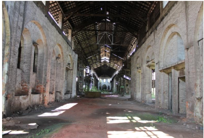
Figura 2. 47: Vista das aberturas em arco da antiga Fundação. Fonte: Arquivo Pessoal (15/06/12)
