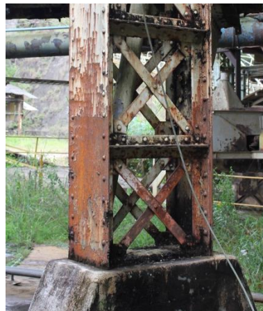
Figura 3. 127: Pilar da cobertura da Boca da Mina.
