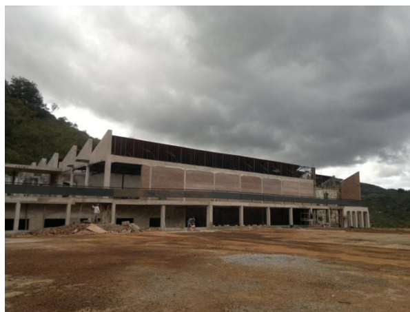
Figura 4. 13: Vista atual da fachada dos antigos galpões. Fonte: Acervo pessoal (14/08/2012)
