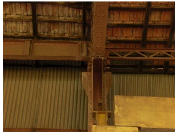
Figura 3. 40: Detalhe ligação entre os trechos do galpão A1 e A2 – Oficina Mecânica e Ferraria. Fonte: Arquivo Pessoal – (março/11)
