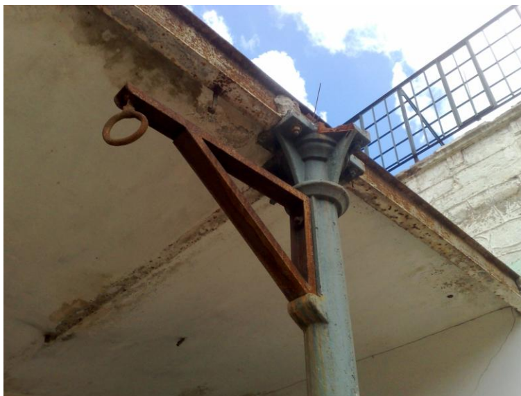
Figura 4. 5: Encaixe e suporte das polias que movimentavam as máquinas. Fonte: Acervo Pessoal (07/02/11)
