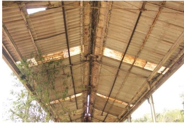
Figura 3. 60: Vista interna do galpão D – Oficina de montagem.
