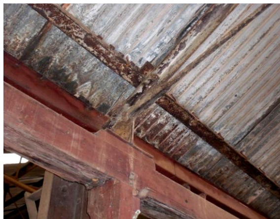
Figura 3. 58: Ligação da tesoura e estrutura de madeira na lateral do galpão C da Oficina Mecânica e Ferraria. Fonte: Arquivo Pessoal – (março/11)
