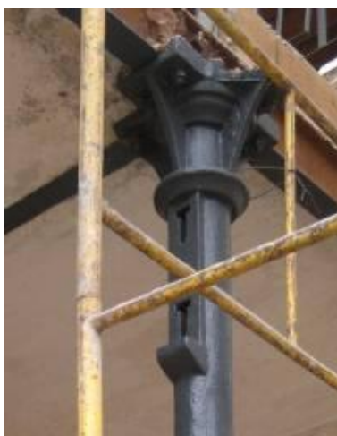
Figura 4. 59: Coluna de borda do subsolo coberta por pintura. Fonte: Acervo pessoal (14/08/12)
