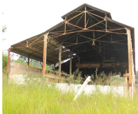
Figura 3. 99: Fachada Posterior - Fundação Ferro e Bronze.
