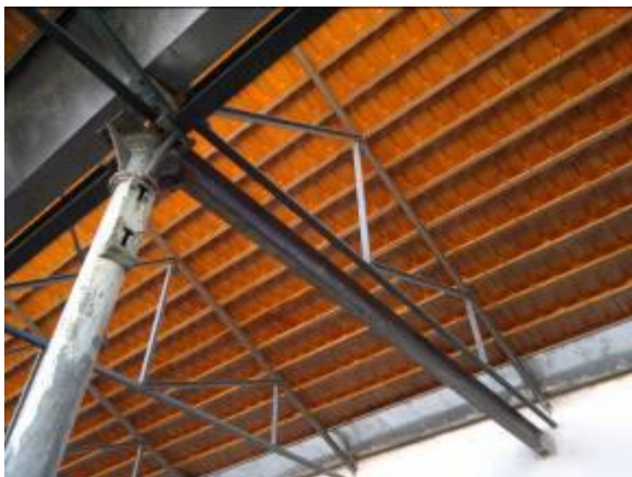
Figura 4. 17: Vista da viga transversal inserida como reforço estrutural. Fonte: Acervo pessoal (14/08/2012)
