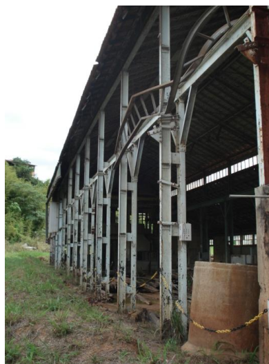
Figura 3. 171: Vista dos pilares da fachada lateral esquerda - Elétrica Fonte: Arquivo Pessoal (21/10/11)
