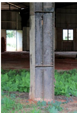
Figura 3. 150: Pilares centrais do galpão B Almojarifado.
