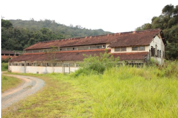
Figura 3. 168: Fachada lateral direita vista pela fachada posterior - Elétrica Fonte: Arquivo Pessoal – (15/06/12)
