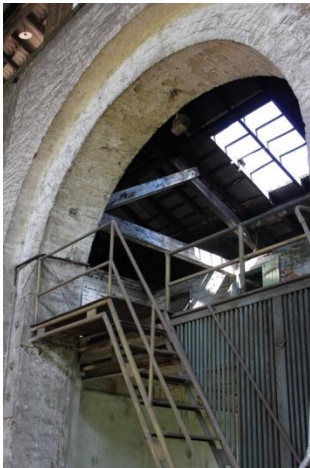
Figura 2. 46: Vista de um dos acessos ao segundo pavimento da Fundação. Fonte: Arquivo Pessoal (15/06/12)
