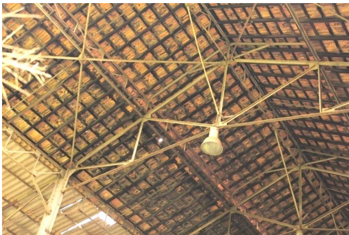
Figura 3. 107: Tesoura em treliça plana - Fundição Ferro e Bronze. Fonte: Arquivo Pessoal – (15/06/12)
