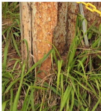
Figura 3. 80: Base Pilar 06 – Galpão A1 Oficina Mecânica.
