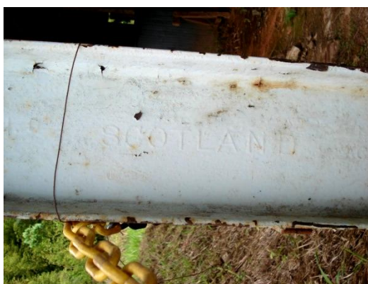
Figura 3. 189: Inscrição "SCOTLAND" em pilar do galpão da Elétrica Fonte: Arquivo Pessoal – (11/06/11)
