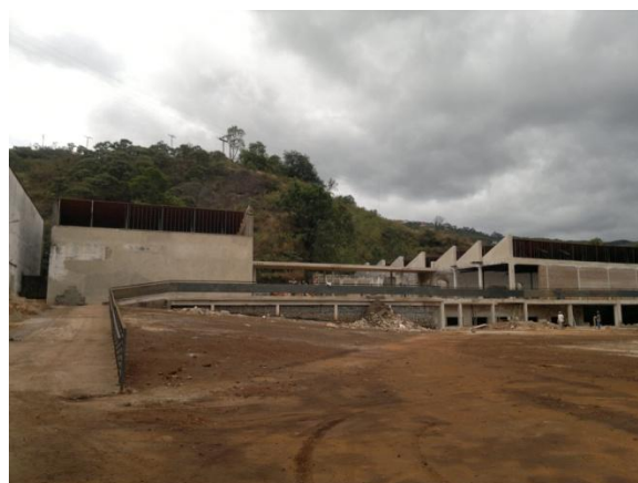
Figura 4. 10: À esquerda galpão 03 metálico mantido. Fonte: Acervo pessoal (14/08/2012)
