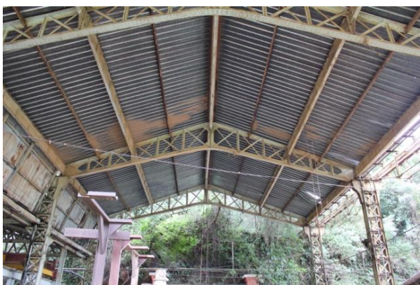
Figura 3. 122: Tesoura treliçada - Boca da Mina. Fonte: Arquivo Pessoal – (15/06/12)
