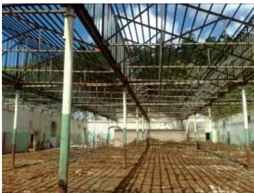
Figura 4. 22: Vista interna galpão 01 em 2011. Fonte: Acervo pessoal.
