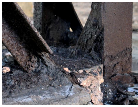
Figura 2. 105: Detalhe da cantoneira do Pilar 04 – Vão Ponte Rolante. Fonte: Arquivo Pessoal (15/06/12)
