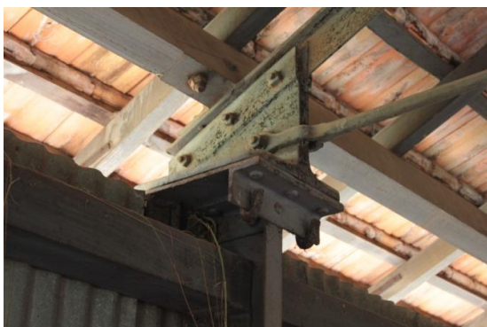
Figura 3. 208: Ligação pilar tesoura - Modelagem Fonte: Arquivo Pessoal – (15/06/12)
