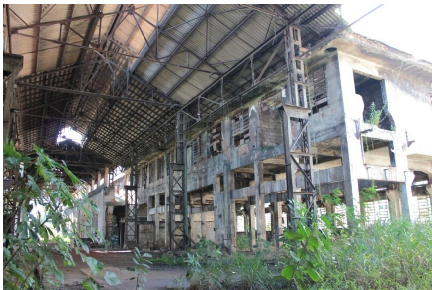
Figura 2. 53: Vista da Fundação a partir do vão da ponte. Fonte: Arquivo Pessoal – (15/06/12)
