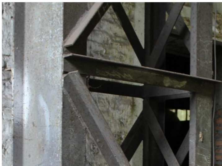
Figura 2. 62: Detalhe ligação com solda – Pilar 07. Fonte: Arquivo Pessoal – (15/06/12)
