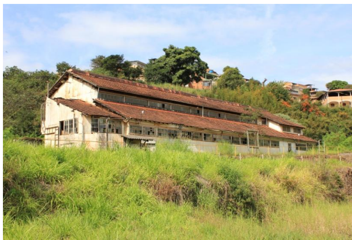
Figura 3. 167: Fachada lateral direita - Elétrica Fonte: Arquivo Pessoal – (15/06/12)
