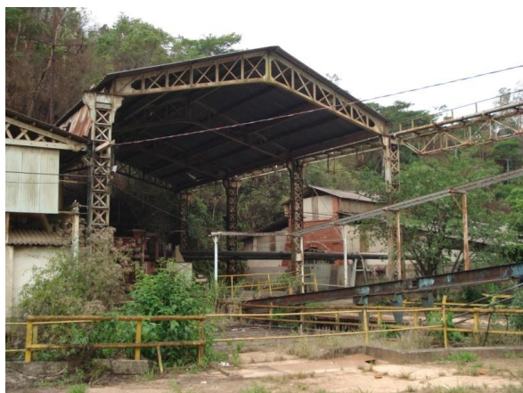
Figura 3. 120: Estrutura do galpão principal de cobertura da Boca da Mina. Fonte: Arquivo Pessoal – (15/06/12)
