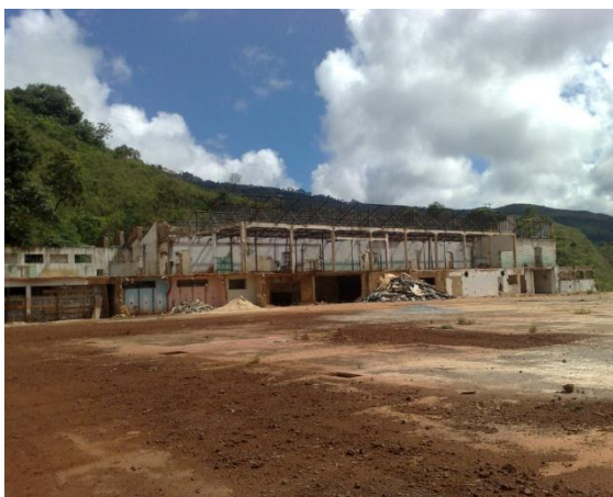
Figura 4. 12: Galpões após as demolições em 2011. Fonte: Acervo pessoal.
