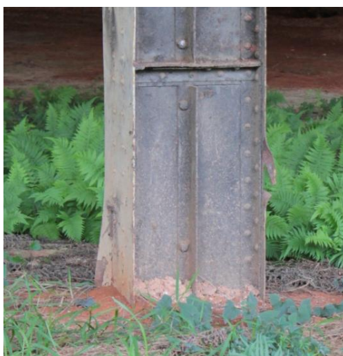
Figura 3. 159: Pilar do galpão B - Almojarifado e Antiga Fábrica de Cadinhos. Fonte: Arquivo Pessoal – (21/10/11)
