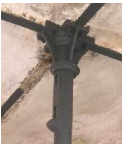
Figura 4. 58: Colunas internas do subsolo cobertas por pintura. Fonte: Acervo pessoal (14/08/12)
