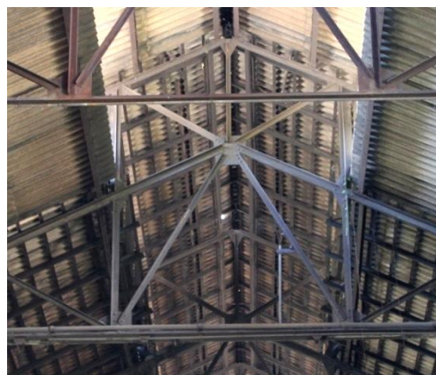
Figura 2. 55: Detalhe tesouras metálicas – vão ponte rolante. Fonte: Arquivo Pessoal – (15/06/12)
