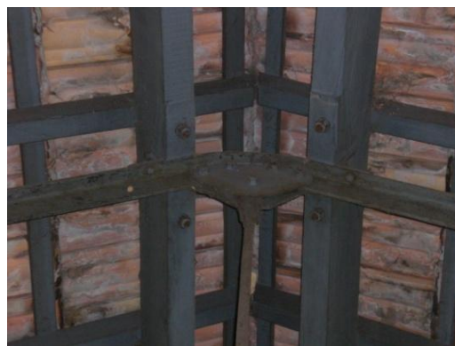
Figura 3. 207: Ligação da tesoura em local da cumeeira - Modelagem Fonte: Arquivo Pessoal – (15/06/12)
