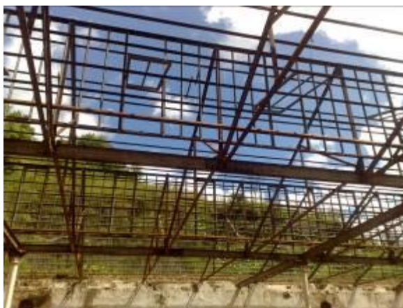
Figura 4. 30: Aberturas na cobertura de shed em bscula. Fonte: Acervo pessoal (07/02/2011)
