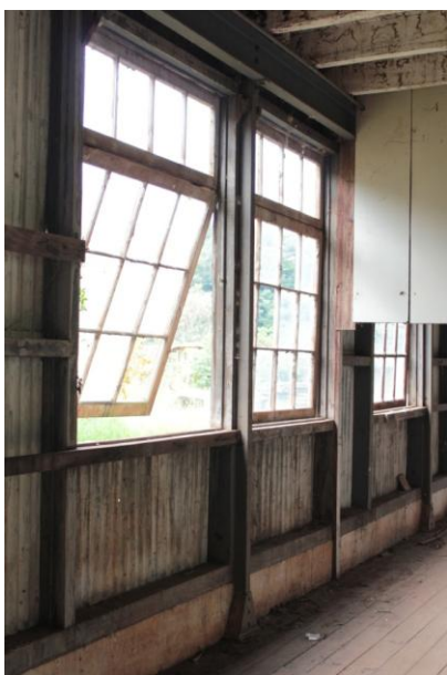
Figura 3. 198: Fixação da chapa corrugada - Modelagem
