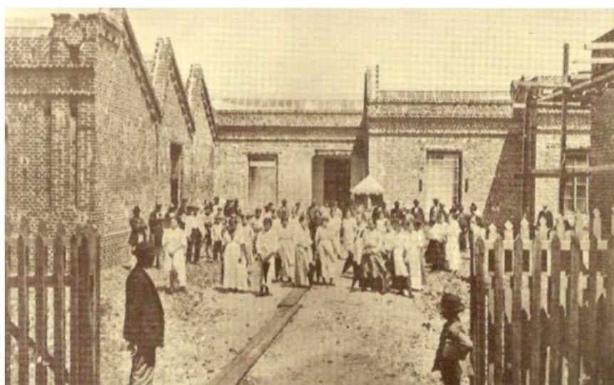
Figura 5. 47: Vista externa da Fábrica de Fiação e Tecidos Progresso da Fronteira Uruguaiana - 1916.
