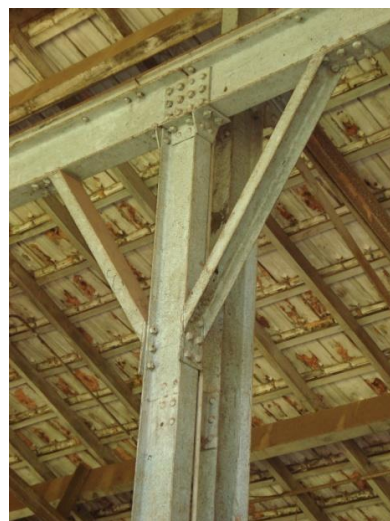
Figura 3. 175: Estrutura ponte rolante - Elétrica
