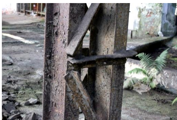
Figura 2. 125: Cantoneiras apresentam deformação e fratura no Pilar 16 – Antiga Oficina Mecânica.
