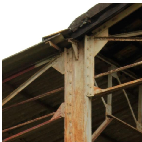
Figura 3. 104: Ligação pilar e tesoura principal e viga vagão Fundição Ferro e Bronze. Fonte: Arquivo Pessoal – (15/06/12)
