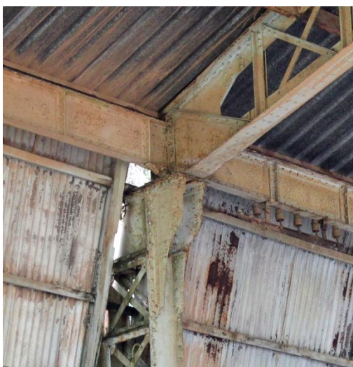
Figura 3. 124: Ligação pilar, viga e tesoura - Boca da Mina. Fonte: Arquivo Pessoal – (15/06/12)
