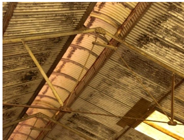
Figura 3. 56: Detalhe lanternin galpão C – Oficina Mecânica e Ferraria. Fonte: Arquivo Pessoal – (março/11)
