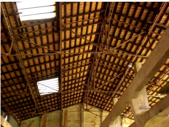
Figura 3. 45: Ligação tesoura - galpão A2 – Oficina Mecânica e Ferraria.
