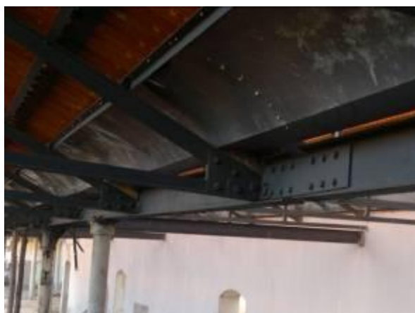
Figura 4. 19: Estrutura da cobertura galpão 02. Fonte: Acervo pessoal (25/07/2012)
