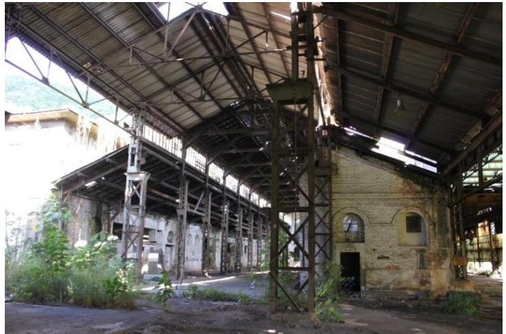
Figura 2. 64: Vista da antiga Oficina Mecânica.
