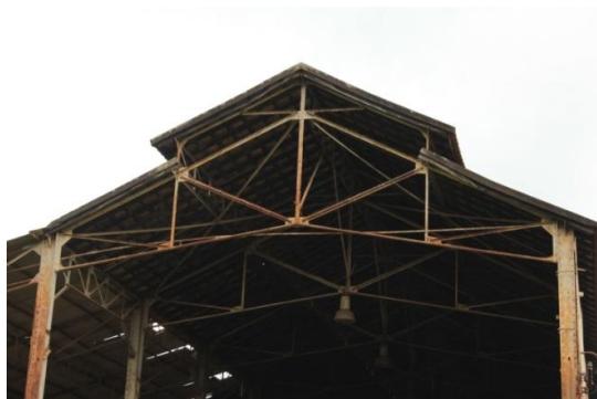
Figura 3. 100: Treliça plana - Fundição Ferro e Bronze. Fonte: Arquivo Pessoal – (15/06/12)
