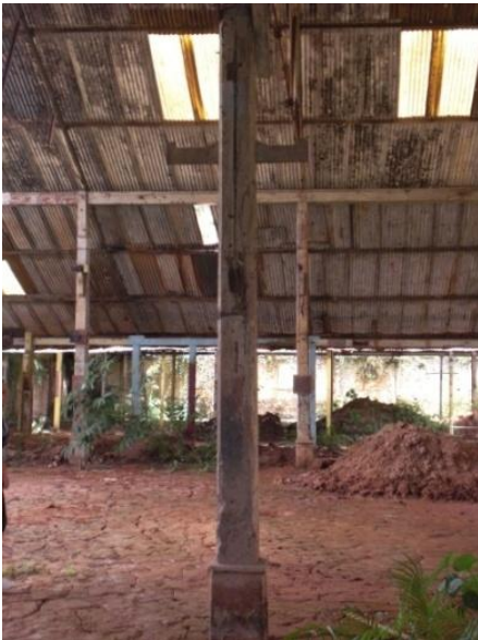
Figura 3. 53: Estrutura de madeira galpão C – Oficina Mecânica e Ferraria.
