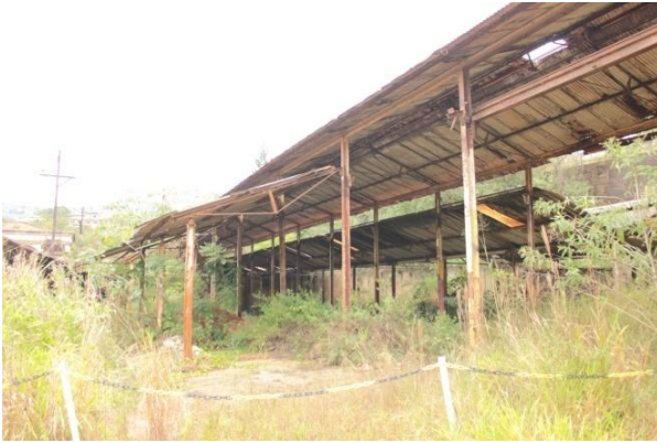
Figura 3. 59: Vista externa do galpão D – Oficina de montagem.
