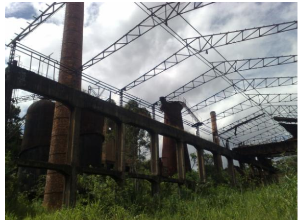
Figura 1.2: Instalações da empresa Lafersa, em Contagem.
