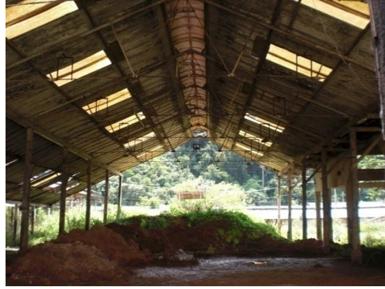
Figura 3. 52: Vista interna galpão C – Oficina Mecânica e Ferraria.
