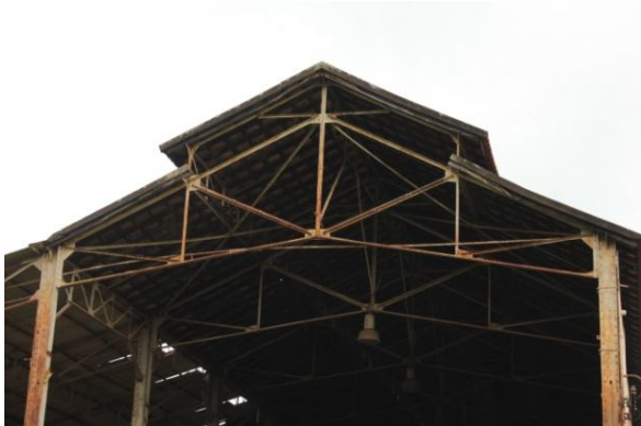
Figura 5. 68: Tesoura do galpão da Fundação Ferro e Bronze Fonte: Acervo Pessoal - (15/06/12)
