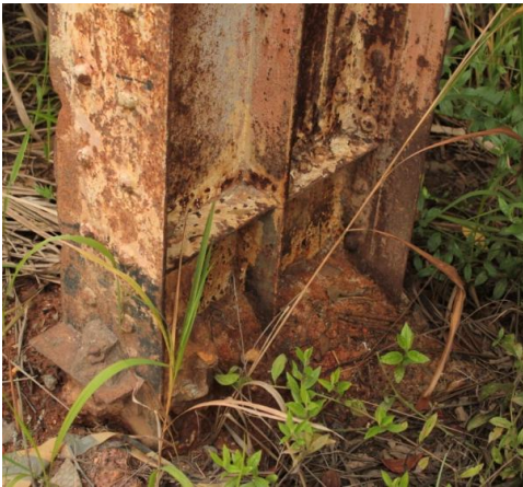
Figura 3. 77: Pilar 04 – Galpão A1 Oficina Mecânica.
