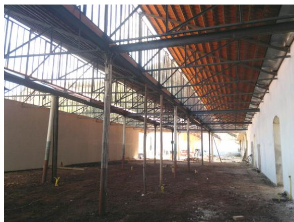
Figura 4. 15: Vista interna galpão 02 em agosto de 2012.
