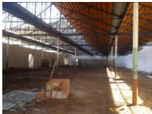
Figura 4. 23: Vista interna galpão 01 em 2012. Fonte: Acervo pessoal.
