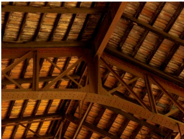
Figura 3. 39: Detalhe ligação entre os trechos do galpão A1 e A2 – Oficina Mecânica e Ferraria. Fonte: Arquivo Pessoal – (março/11)
