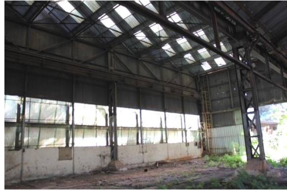
Figura 2. 91: Vista interna do galpão metálico na lateral do vão da ponte rolante. Fonte: Arquivo Pessoal – (15/06/12)
