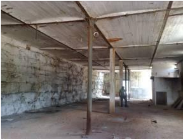
Figura 4. 43: Vista interna do subsolo antes da demolição das paredes. Fonte: Acervo pessoal (07/02/2011)
