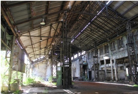
Figura 2. 92: Cobertura metálica na lateral do vão da ponte rolante. Fonte: Arquivo Pessoal – (15/06/12)
