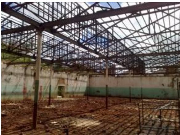
Figura 4. 26: Vista interna da parte posterior do galpão 01 em 2011.
