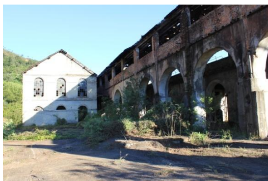
Figura 5. 32: Detalhe das aberturas em arco da fachada lateral esquerda da Fundição. Fonte: Acervo Pessoal (15/06/12)
