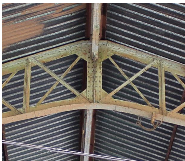
Figura 3. 125: Tesoura da cobertura da Boca da Mina. Fonte: Arquivo Pessoal – (15/06/12)
