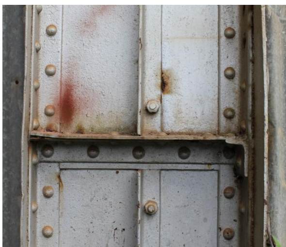
Figura 3. 38: Detalhe pilar em perfis compostos - galpão A1 – Oficina Mecânica e Ferraria.
