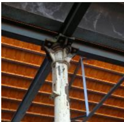
Figura 4. 20: Detalhe apoio da viga - galpão 01. Fonte: Acervo pessoal (25/07/2012)
