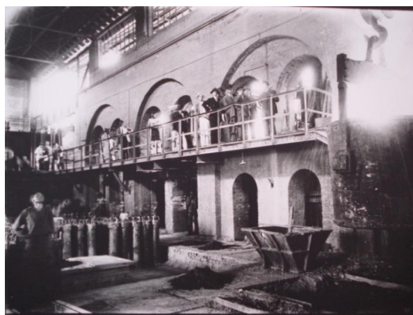
Figura 2. 22: Vista interna da Aciaria durante visita de autoridades Forno Siemens Martin 1 Fonte: Acervo Programa Memória ArcelorMittal.
