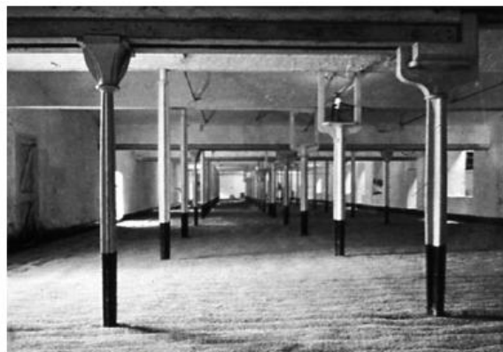
Figura 5. 3: Vista interna da Fábrica de Fiação em Ditherington, Shrewsbury, Inglaterra, 1796/1797. Fonte: GUEDES (2010)
