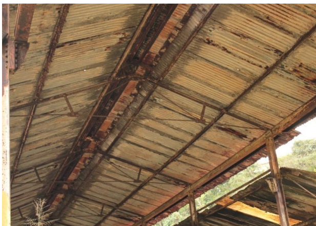
Figura 3. 63: Estrutura da cobertura principal galpão D – Oficina de montagem.
