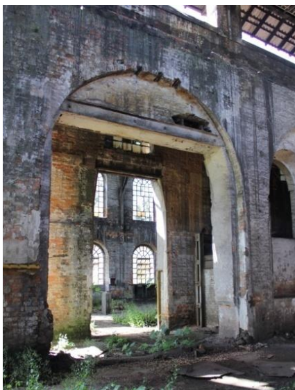
Figura 2.80: Vista da Modelagem a partir da Fundação. Fonte: Arquivo Pessoal – (15/06/12)
