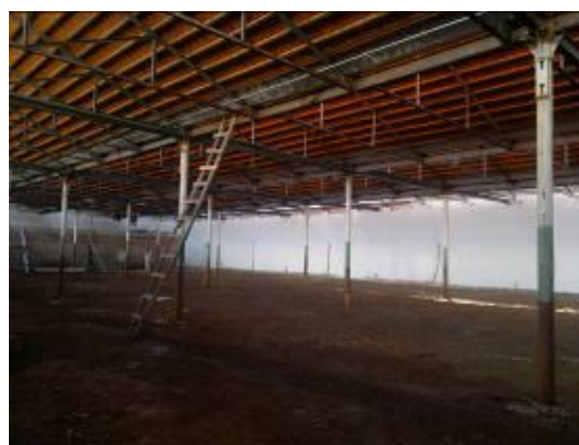
Figura 4. 25: Vista interna da parte frontal do galpão 01 em 2012. Fonte: Acervo pessoal.
