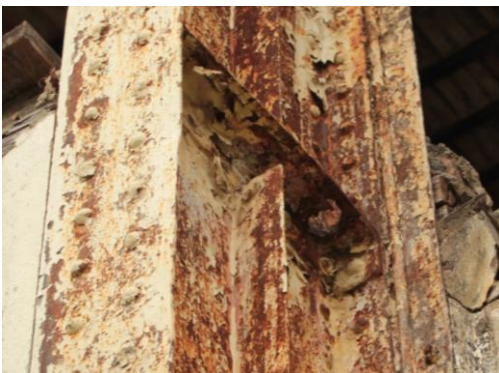
Figura 3. 79: Pilar 06 – Galpão A1 Oficina Mecânica.
