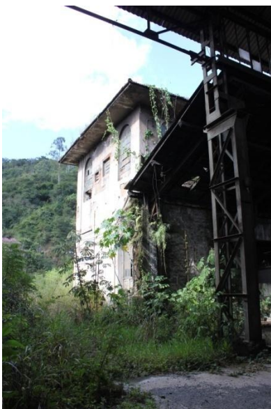
Figura 2. 86: Vista prédio em concreto construído na lateral da Oficina. Fonte: Arquivo Pessoal – (15/06/12)
