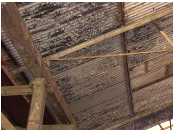
Figura 3. 55: Ligação tesoura e estrutura de madeira galpão C – Oficina Mecânica e Ferraria. Fonte: Arquivo Pessoal – (março/11)
