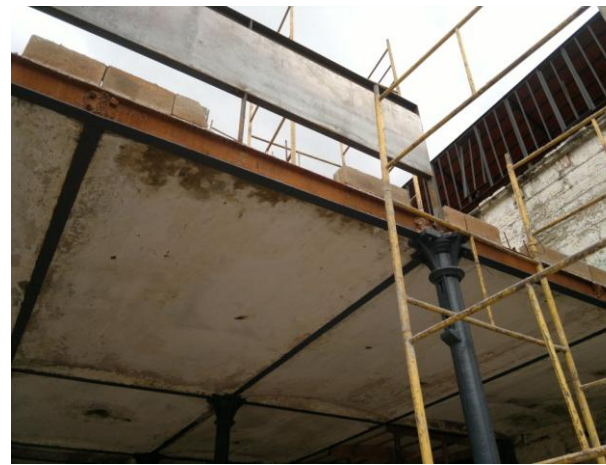
Figura 4. 46: Viga de borda do subsolo. Fonte: Acervo pessoal (14/08/2012)
