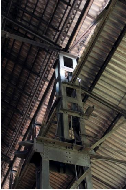
Figura 2. 56: Ligação tesoura, viga e pilar mais antiga.
