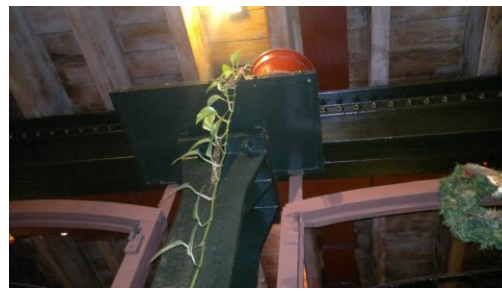
Figura 1.9: Estrutura metálica interna em um dos galpões de "Puerto Madero" em Buenos Aires.
