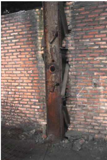
Figura 2. 112: Pilar 11 da Oficina inserido na parede.
