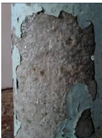
Figura 4. 72: Aspecto da superfície granulada do ferro fundido. Fonte: Acervo pessoal (25/07/2012)
