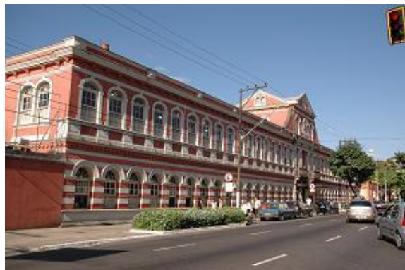
Figura 1.5: Fachada Frontal do Centro Cultural Bernardo Mascarenhas, construído em 1888. Fonte: BUREAU Convention & Visitors. Juiz de Fora e região (2007).
