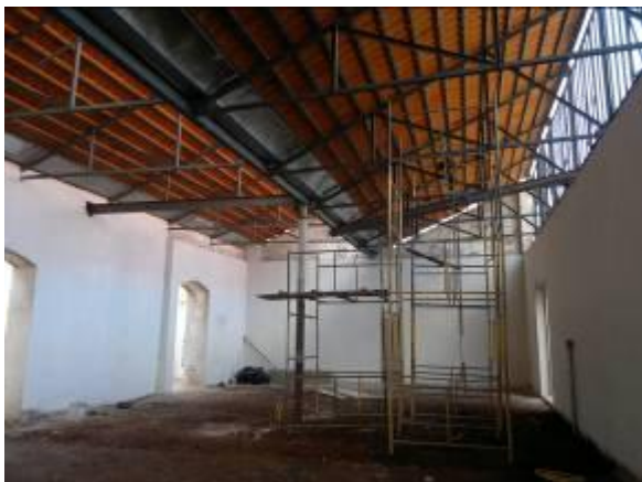
Figura 4. 16: Reforço estrutural sendo executado. Fonte: Acervo pessoal (14/08/2012)
