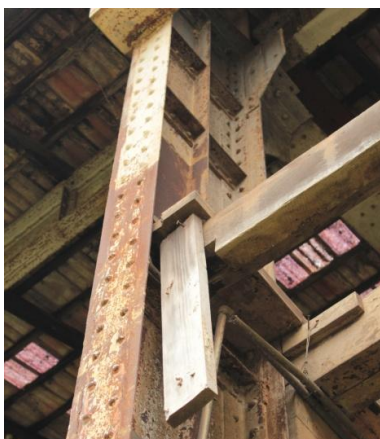
Figura 3. 75: Estrutura de madeira apoiada no Pilar 04 – Galpão A1 Oficina Mecânica. Fonte: Arquivo Pessoal – (15/06/12)
