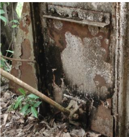
Figura 3. 142: Base original do Pilar 08 - Galpão principal, Boca da Mina. Fonte: Arquivo Pessoal – (21/10/11)
