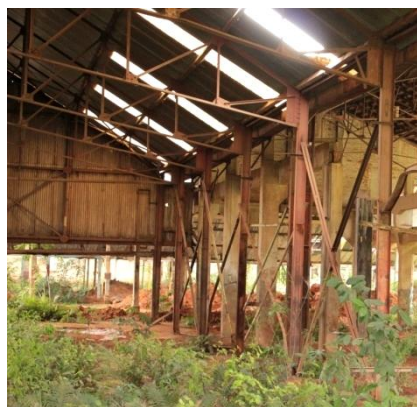
Figura 3. 50: Contravento pilares galpão B – Oficina Mecânica e Ferraria. Fonte: Arquivo Pessoal – (15/06/12)
