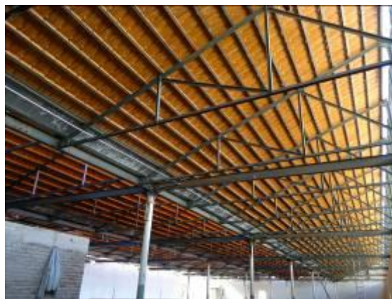
Figura 4. 29: Tesoura da cobertura após recuperação
