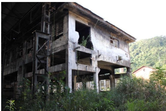
Figura 2. 83: Vista da fachada posterior do Galpo E. Fonte: Arquivo Pessoal – (15/06/12)
