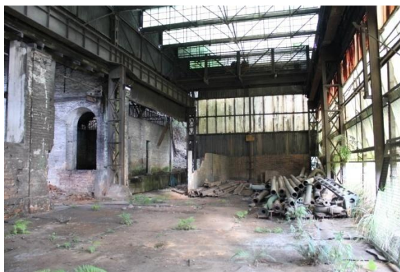
Figura 2. 89: Final da fachada da antiga Oficina Mecânica.
