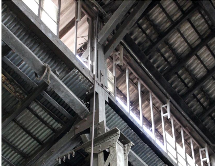
Figura 2. 70: Ligação estrutural Fonte: Arquivo Pessoal – (15/06/12)
