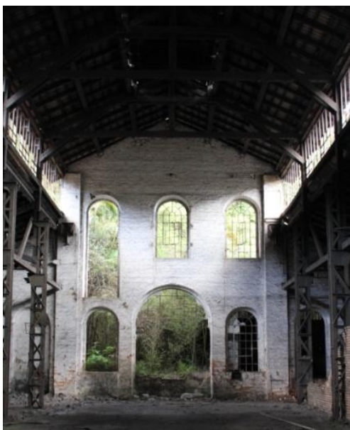
Figura 5. 36: Vista interna da parte posterior da Oficina Mecânica da Cia Belgo Mineira.
