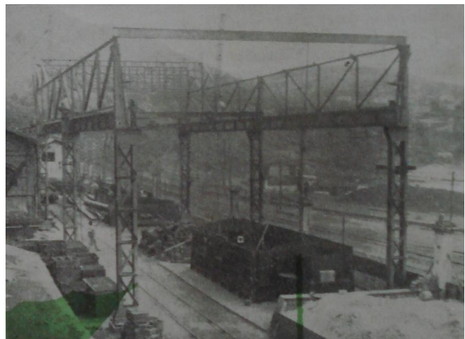
Figura 2. 32: Obras de ampliação da Fundição no final de 1959. Fonte: Jornal O Pioneiro, n° 97, dez. de 1959. Acervo Programa Memória ArcelorMittal.
