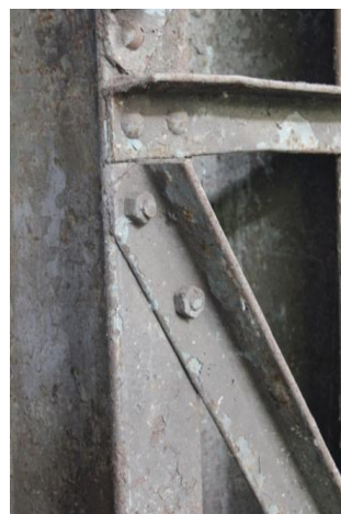
Figura 2. 121: Cantoneiras do Pilar 04 fixadas com parafusos – Antiga Oficina Mecânica. Fonte: Arquivo Pessoal (15/06/12)
