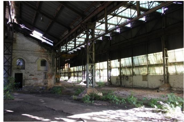
Figura 2. 93: Vista do galpão metálico na lateral da Oficina. Fonte: Arquivo Pessoal – (15/06/12)
