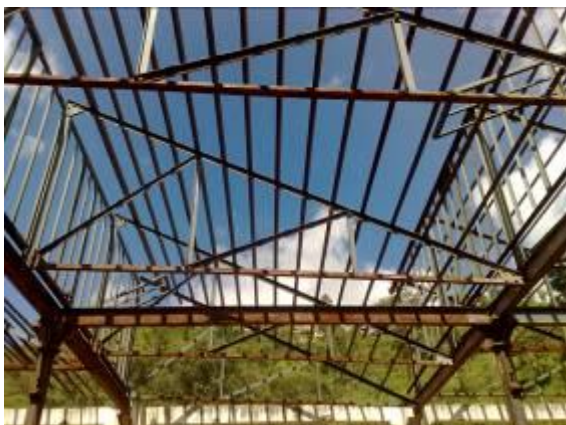
Figura 4. 28: Tesouras da cobertura durante recuperação.
