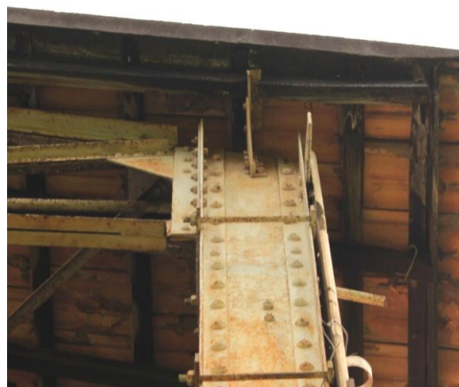
Figura 3. 105: Ligação pilar e tesoura em treliça plana - Fundição Ferro e Bronze. Fonte: Arquivo Pessoal – (15/06/12)
