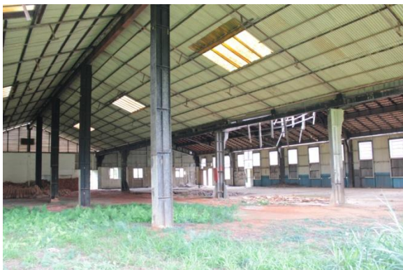
Figura 3. 146: Vista interna do Galpão B - Almojarifado e antiga Fábrica de cadinhos. Fonte: Arquivo Pessoal – (15/06/12)
