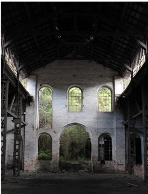
Figura 2. 71: Vista interna fachada posterior Fonte: Arquivo Pessoal – (15/06/12)
