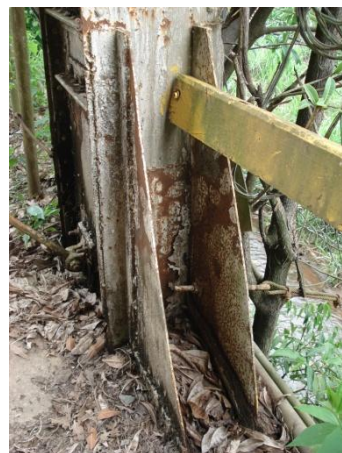
Figura 3. 143: Detalhe da base Pilar 08 - Galpão principal - Boca da Mina Fonte: Arquivo Pessoal – (21/10/11)
