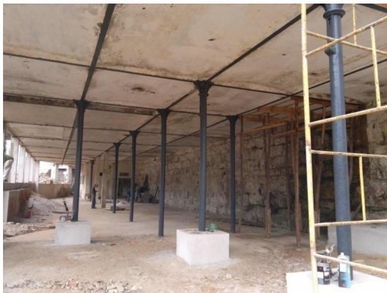
Figura 5. 59: Laje em abobadilha na Fábrica de Tecidos de Ouro Preto. Fonte: Acervo Pessoal (14/08/12)
