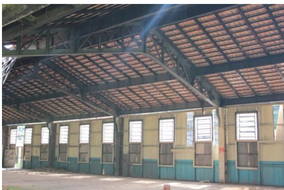
Figura 3. 148: Vista interna do Galpão A, à direita - Almojarifado e antiga Fábrica de cadinhos.
