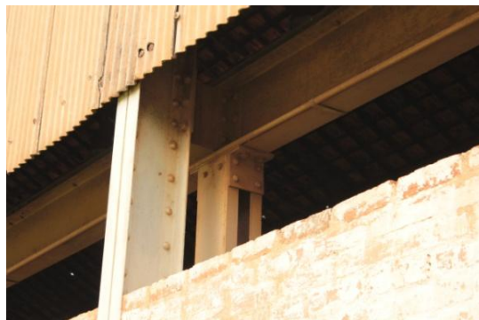
Figura 3. 101: Pilar e estrutura ponte rolante - Fundição Ferro e Bronze. Fonte: Arquivo Pessoal – (15/06/12)
