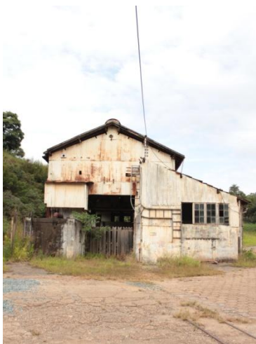
Figura 3. 166: Fachada frontal - Elétrica Fonte: Arquivo Pessoal – (15/06/12)
