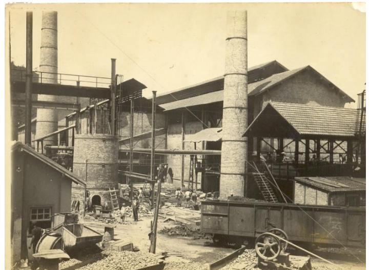
Figura 2. 15: Construção do 3º Forno SM – 1931 Fonte: Acervo Programa Memória ArcelorMittal.
