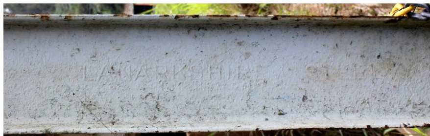
Figura 3. 188: Inscrição " LANARKSHIRE STEEL " em pilar do galpão da Elétrica Fonte: Arquivo Pessoal – (11/06/11)
