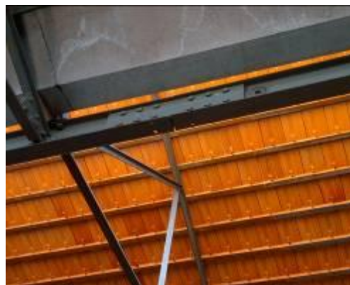
Figura 4. 21: Viga unida com chapa parafusada - galpão 01 Fonte: Acervo pessoal (25/07/2012)
