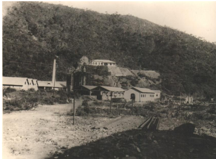
Figura 2. 2: Vista Usina de Sabará em 1920 Fonte: Acervo Programa Memória ArcelorMittal.
