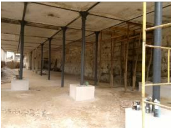
Figura 4. 60: Três colunas receberam base de concreto. Fonte: Acervo pessoal (14/08/12)
