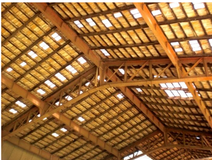
Figura 3. 33: Estrutura da cobertura galpão A1 – Oficina Mecânica e Ferraria.
