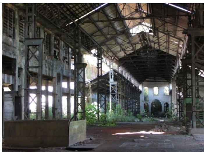
Figura 5.41: Vista da estrutura metálica treliçada do Vão da ponte rolante e da Oficina Mecânica - Antiga Cia Belgo Mineira. Fonte: Acervo Pessoal (15/06/12)
