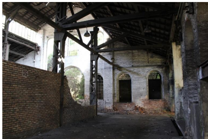
Figura 2. 72: Vista interna fachada posterior Fonte: Arquivo Pessoal – (15/06/12)
