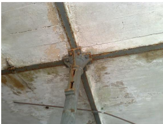
Figura 4. 56: Junção coluna, viga e laje do subsolo. Fonte: Acervo pessoal (07/02/2011)
