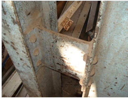
Figura 3. 184: Pilar interno em bom estado de conservação - Galpão da Elétrica
