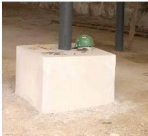
Figura 4. 61: Embasamento de concreto. Fonte: Acervo pessoal (14/08/12)
