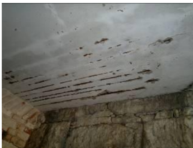
Figura 4. 71: Laje corredor que separa a construção da encosta. Fonte: Acervo pessoal (14/08/2012)
