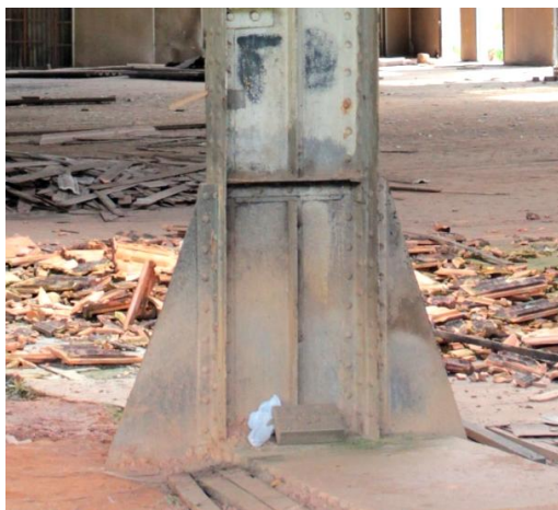
Figura 3. 153: Base do pilar de divisa entre galpões - Almojarifado e Fábrica de cadinhos. Fonte: Arquivo Pessoal – (15/06/12)
