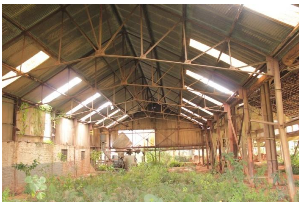
Figura 3. 47: Vista interna - galpão B – Oficina Mecânica e Ferraria. Fonte: Arquivo Pessoal – (15/06/12)
