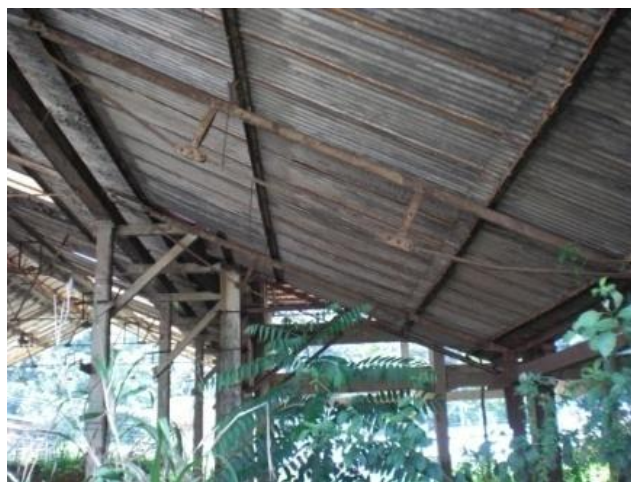
Figura 5. 71: Viga vagão em ala lateral do galpão C da Mecânica - Mina de Morro Velho. Fonte: Arquivo Pessoal - (março/2011)
