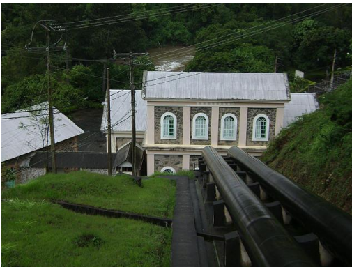
Figura 1.4: Vista Usina Marmelos de 1889, transformada em um museu. Fonte: PREFEITURA de Juiz de Fora.
