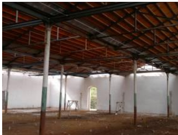
Figura 4. 27: Vista interna da parte posterior do galpão 01 em 2012.
