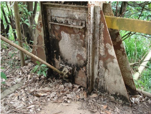
Figura 3. 126: Base do pilar 08 do galpão da Boca da Mina.
