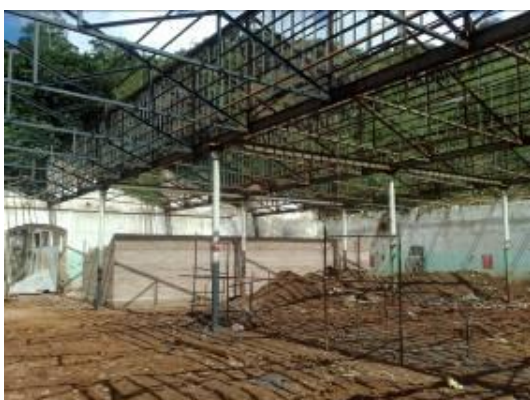
Figura 4. 24: Vista interna da parte frontal do galpão 01 em 2011. Fonte: Acervo pessoal.
