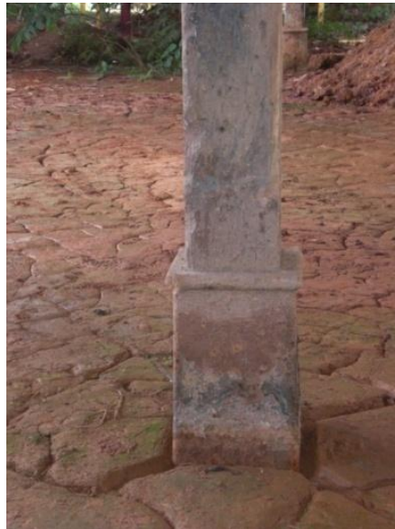
Figura 3. 54: Detalhe base pilar em madeira galpão C – Oficina Mecânica e Ferraria.
