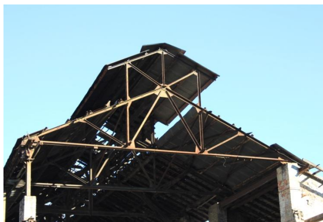
Figura 2. 51: Tesoura metálica – antiga Fundação Fonte: Arquivo Pessoal – Fotografia Mateus Lustosa (15/06/12)
