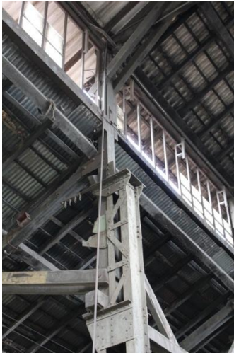
Figura 2. 67: Encontro estrutura dos telhados. Fonte: Arquivo Pessoal – (15/06/12)
