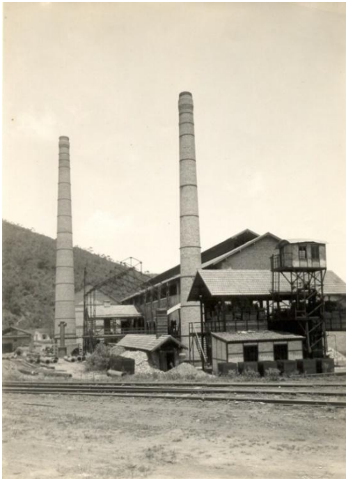
Figura 2. 14: Construção do 2º Forno SM – 1927 Fonte: Acervo Programa Memória ArcelorMittal.
