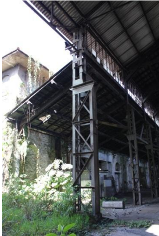
Figura 2. 63: Pilar 08 – Vão ponte rolante.
