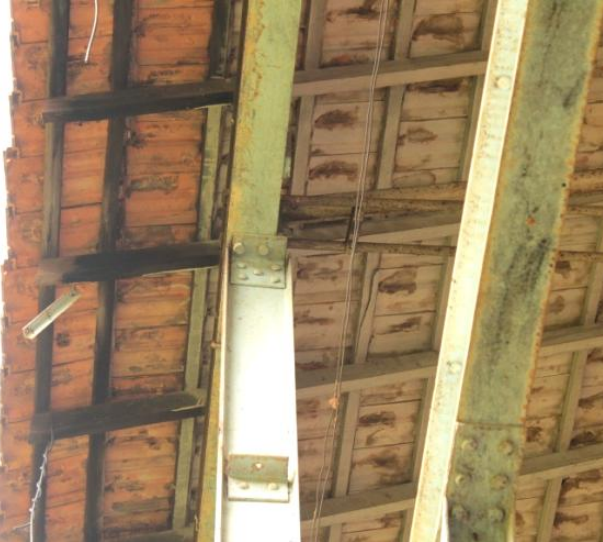
Figura 3. 176: Ligação viga e pilar - Elétrica Fonte: Arquivo Pessoal – (15/06/12)
