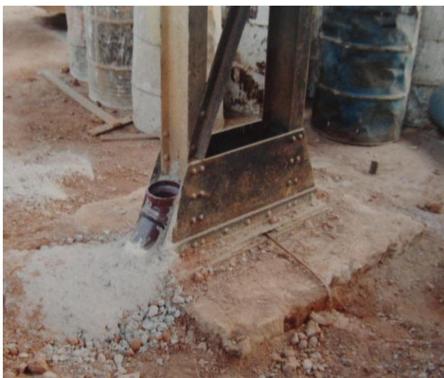
Figura 6. 1: Base do pilar metálico durante as obras na Serraria Souza Pinto/BH. Fonte: IEPHA (1997)
