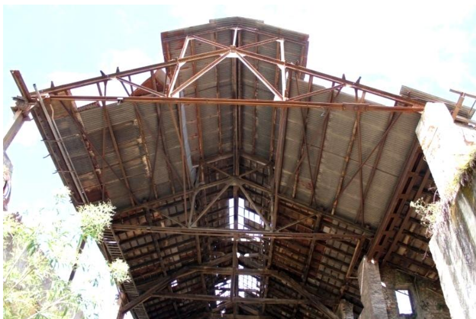
Figura 2. 49: Tesouras metálicas remanescentes na porção frontal da Fundação Fonte: Arquivo Pessoal – (15/06/12)
