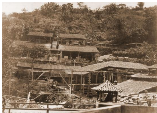
a) Vista das antigas edificações da área industrial
