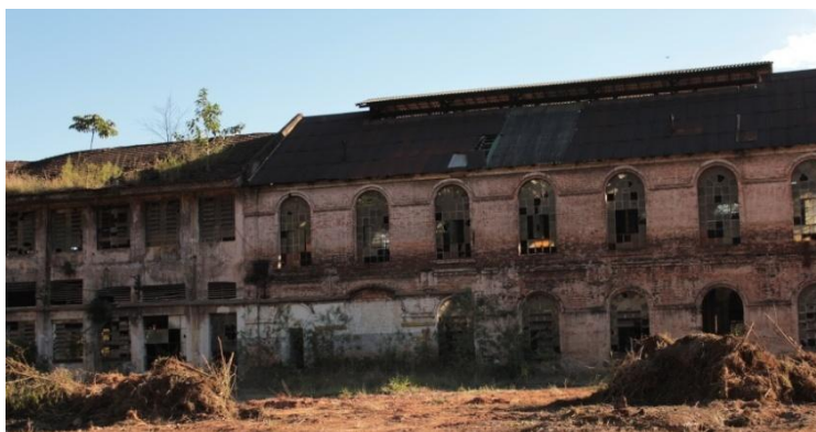
Figura 2. 82: Vista prdio em concreto construdo atrs da Modelagem. Fonte: Arquivo Pessoal – (15/06/12)
