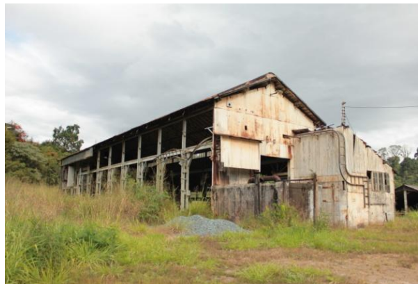
Figura 3. 169: Fachada lateral esquerda - Elétrica Fonte: Arquivo Pessoal – (15/06/12)
