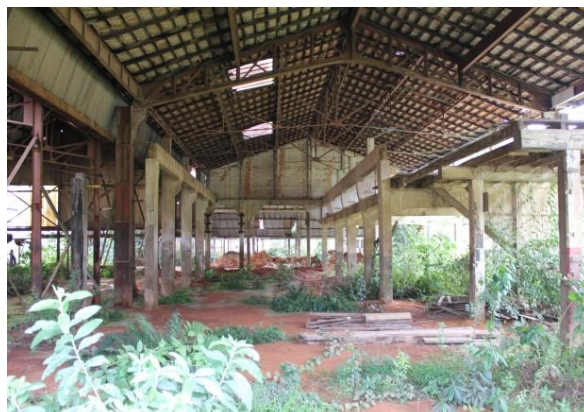
Figura 3. 32: Vista interna do galpão A1 – Oficina Mecânica e Ferraria. Fonte: Arquivo Pessoal – (15/06/12)
