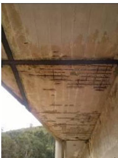
Figura 4. 70: Laje em abobadilha no subsolo. Fonte: Acervo pessoal (14/08/2012)
