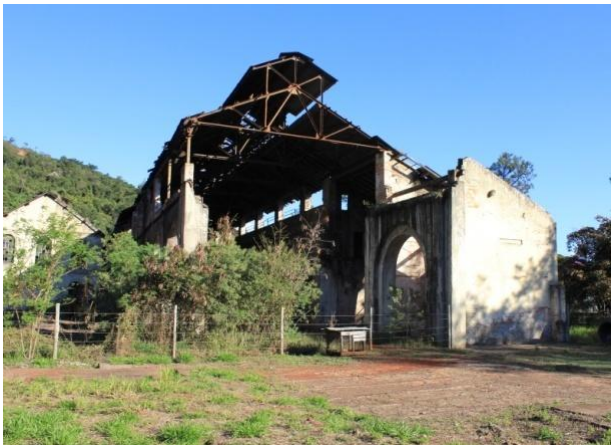
Figura 2. 42: Fachada frontal - antiga Fundição Fonte: Arquivo Pessoal – (15/06/12)
