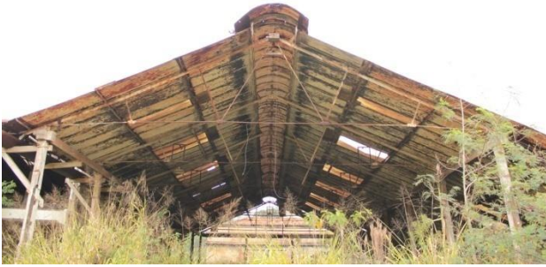
Figura 3. 51: Vista galpão C – Oficina Mecânica e Ferraria.
