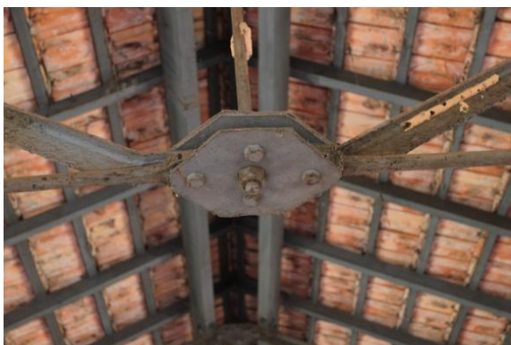
Figura 3. 206: Ligação central do banzo inferior da tesoura - Modelagem Fonte: Arquivo Pessoal – (15/06/12)
