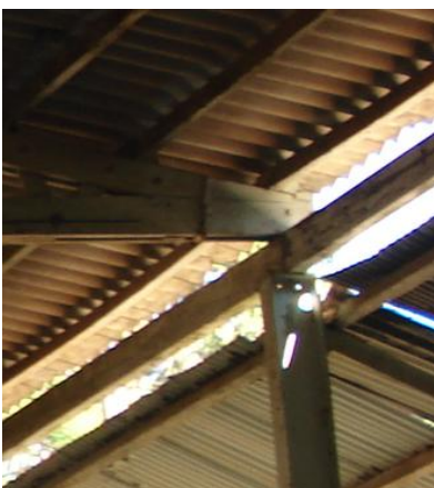
Figura 3. 128: Ligação treliça de madeira e pilar metálico Galpão secundário - Boca da Mina.
