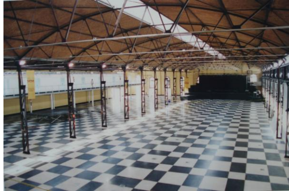
b) Vista interna da Serraria Souza Pinto após as obras de restauração.
