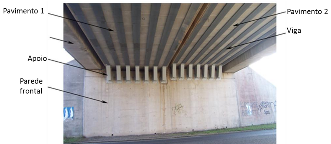
Figura 6.6 a – Vista inferior dos mancais. FONTE – CURY, 2010.
