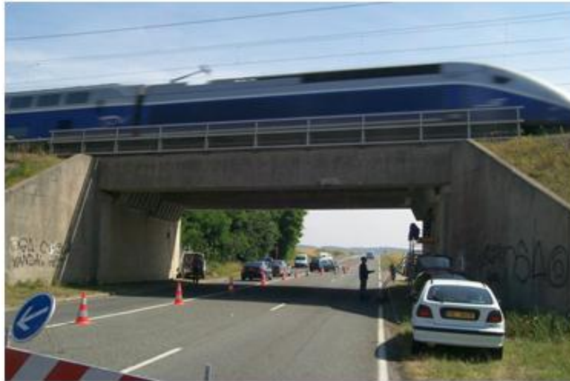
FIGURA 6.2 – Vista geral do viaduto. FONTE – CURY, 2010.
