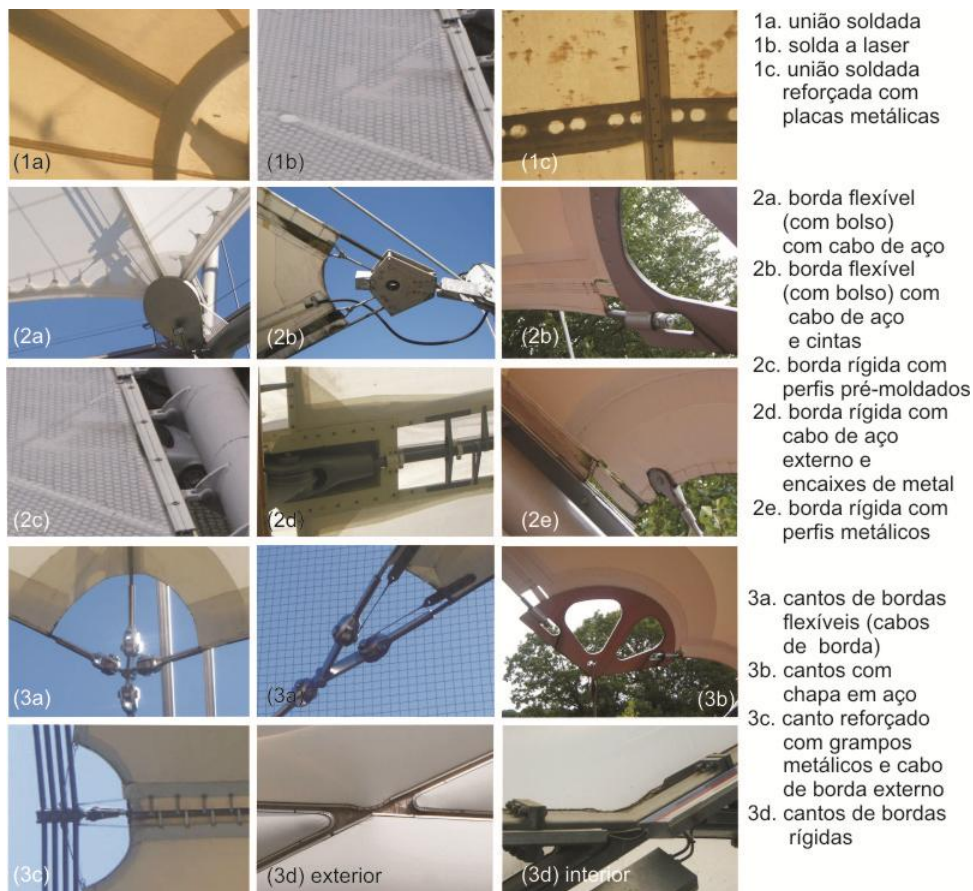
Figura 2.4-22 - União entre componentes
