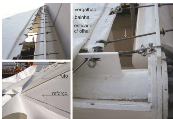
Figura 2.7-7 – Conexão de borda rígida desenvolvida pelo eng. Prof. Ruy Pauletti
