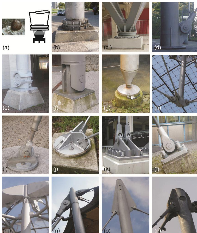
Figura 2.4-24 – Ancoragens dos componentes
