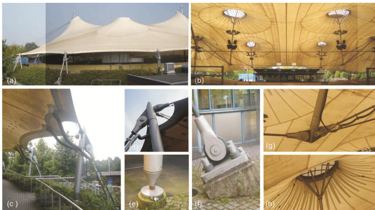
(a, b) vistas externa e interna; (c, d, e) topo e base dos pequenos mastros (f) ancoragem cabos, (g,h) topo e base do mastro flutuante; (fotos da autora).
