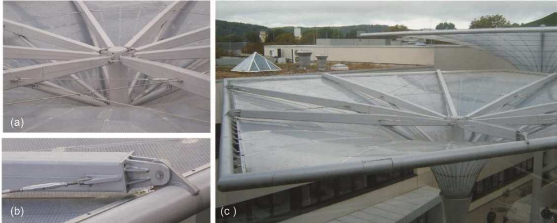
(a, b, c) detalhes da estrutura suporte da cobertura; (fotos da autora).
