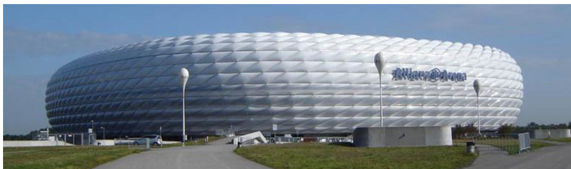
Arquitetos: Herzog&amp; De Meuron, Basel; Eng.: Arup GmbH, Berlin and Sailer Stepan und Partner, Munich; (foto da autora).
