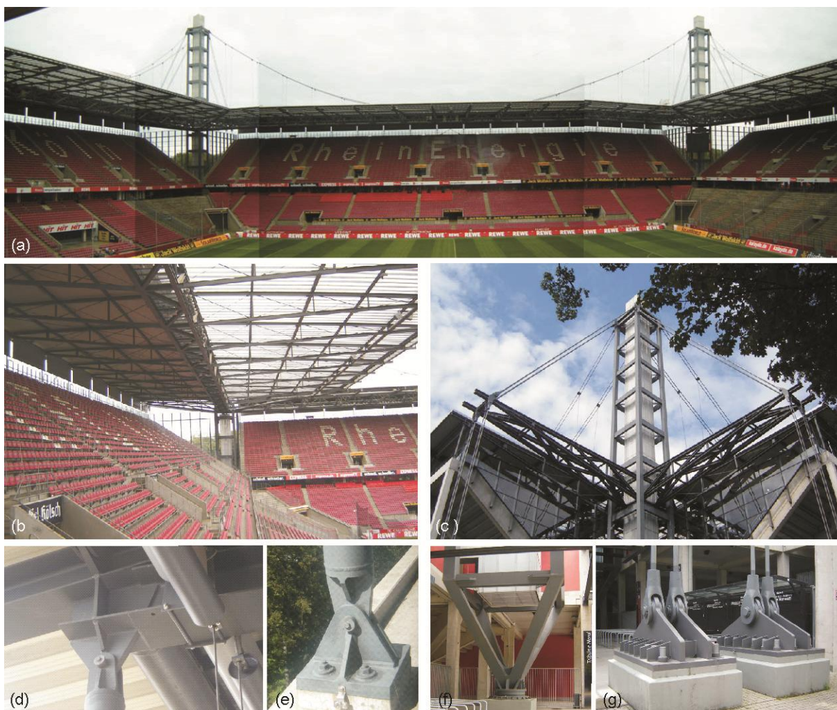
(a) vista interna; (b) cobertura arquibancadas; (c) mastro; (d,e) detalhe de ancoragem dos perfis tubulares esbeltos da cobertura; (f, g) ancoragens dos cabos e mastro; (fotos da autora).
