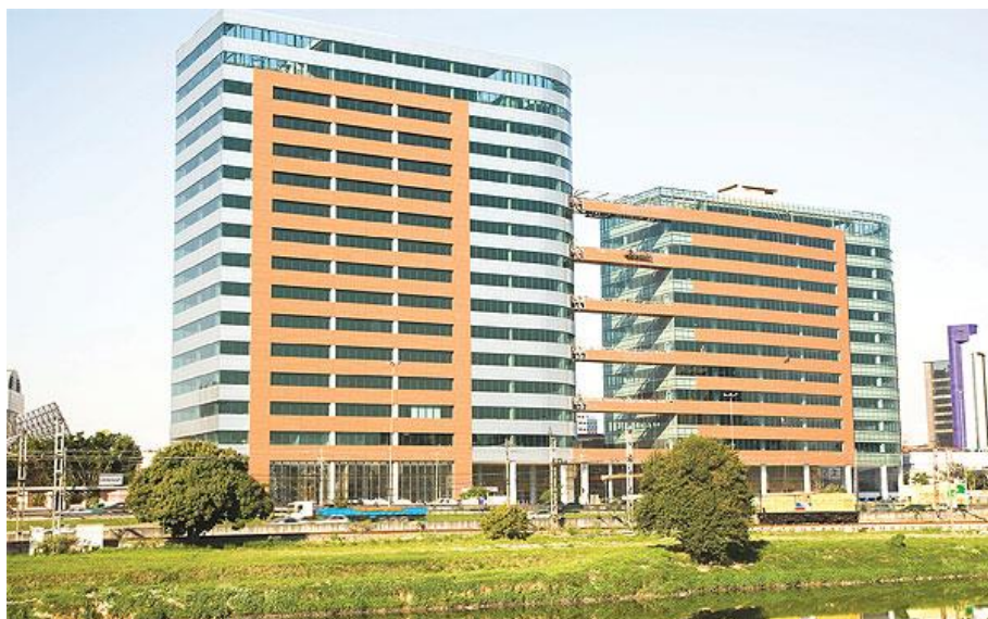
Figura 1. 7 Edifício WT Nações Unidas. Fonte: http://www.revistatechne.com.br
