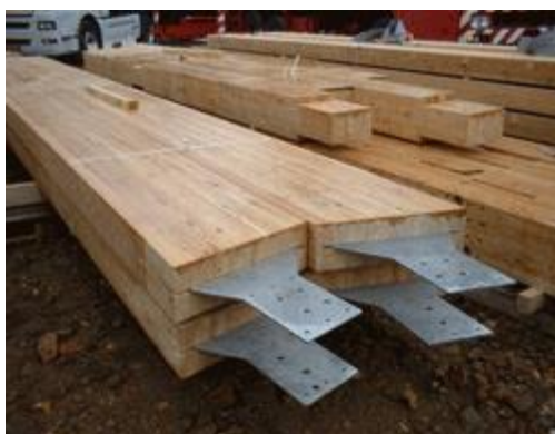
Figura 1. 2 Elemento misto de madeira-aço.
