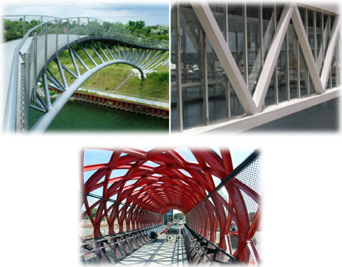
Figura 1.1 - Exemplos de passarelas metálicas FONTE - CIDECT, 2010
