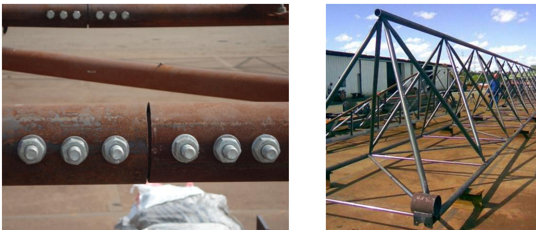
Figura 2.1 a e b - Ligação parafusada em perfis circulares conectados por parafusos passantes e possibilidade de aplicação. (Vieira, 2011 - comunicação pessoal).
