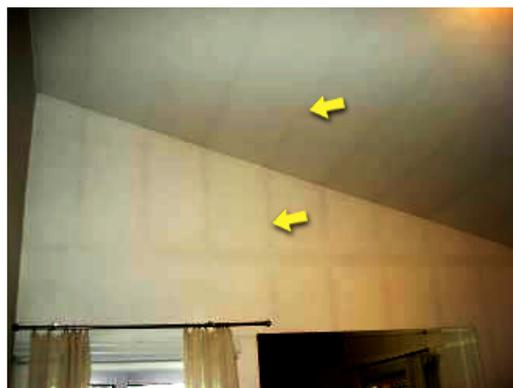
Figura 2.12 – Marcas das estruturas nos painéis internos.
