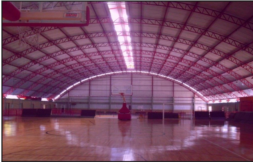
Figura 3.15: Arco parabólico da Vila Olímpica do SESI.
