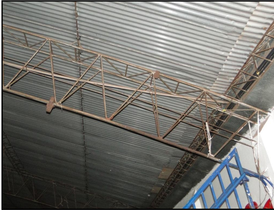
Figura 3.42: Arco circular com barras não coplanares.
