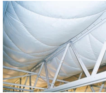
Figura 2.24 – Material isolante térmico Isoband fornecido pelo Sistema Roll on Fonte: MARKO, 2008
