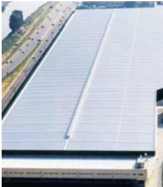
Figura 2.5 – Cobertura plana do Centro de Distribuição do Pão de Açúcar, São Paulo, SP Fonte: MARKO, 2008
