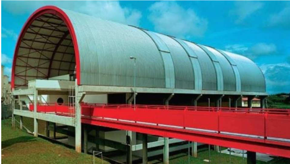
Figura 2.4 – Cobertura em arco da Escola Municipal Jardim de Ipanema , São Paulo, SP Fonte: ARCOWEB, 2011
