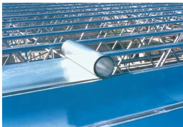
Figura 2.19 – Sistema construtivo Roll On Fonte: MARKO, 2008
