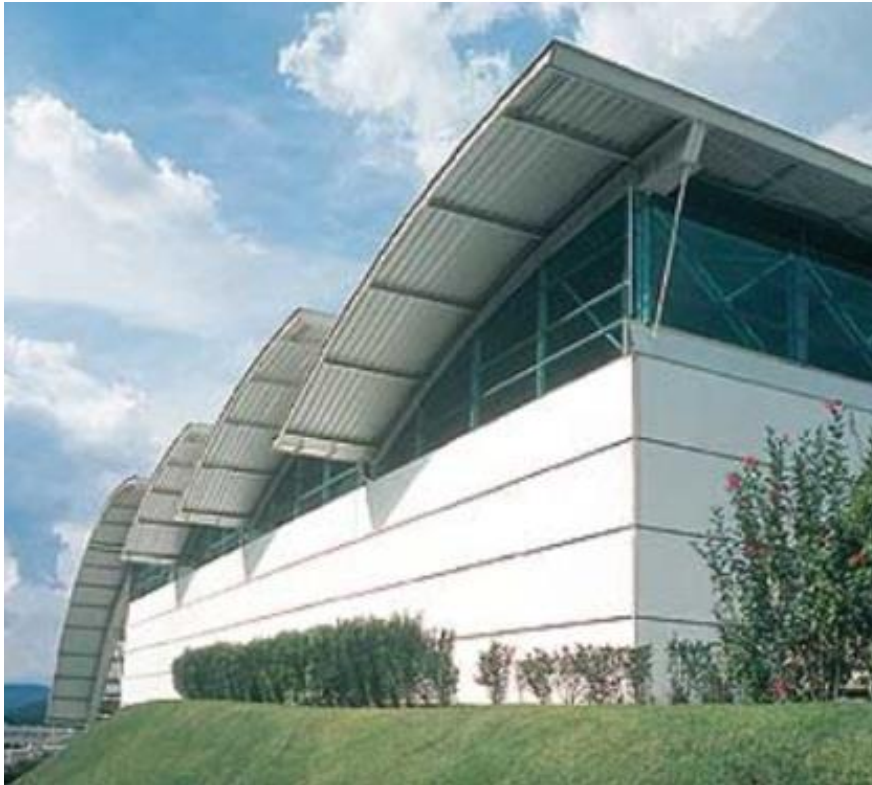
Figura 2.6 – Cobertura em Shed em arco da Fábrica Ipel, Cajamar, SP Fonte: ARCOWEB, 2011
