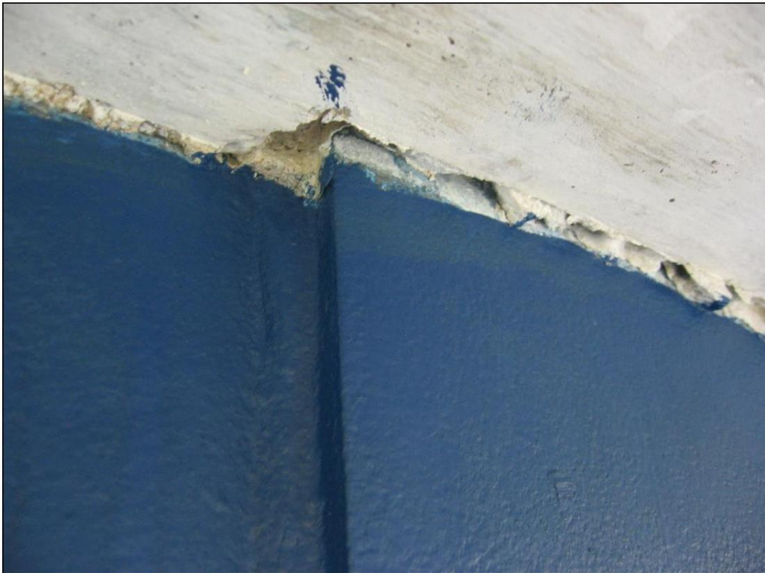
FIGURA 5.1: Descolamento entre a laje de concreto e a treliça metálica
