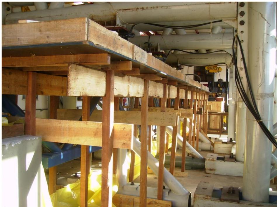
FIGURA 3.5: Estrutura de escoramento da laje de concreto
