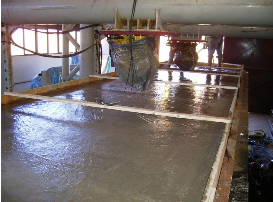
FIGURA 3.6: Concretagem da laje no laboratório de estruturas Prof. Altamiro Tibiriçá Dias
