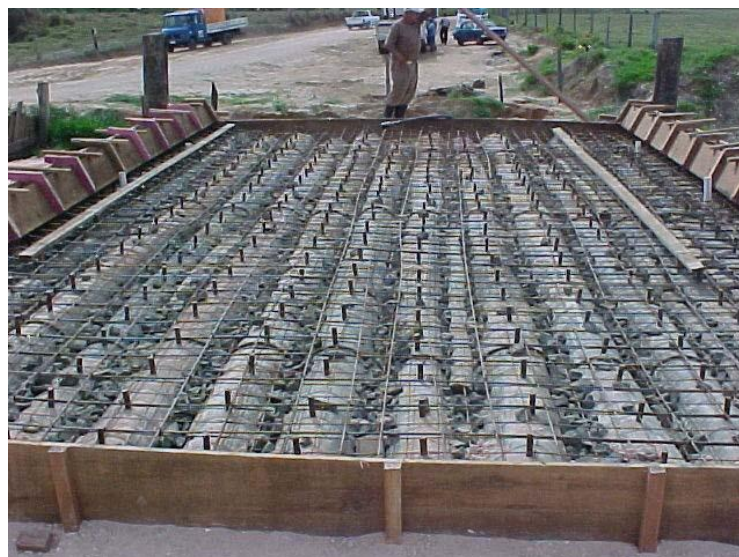
Figura 2.17 – Vista superior do tabuleiro da Ponte Capela com os conectores de cisalhamento. FONTE: JUNIOR (2006)
