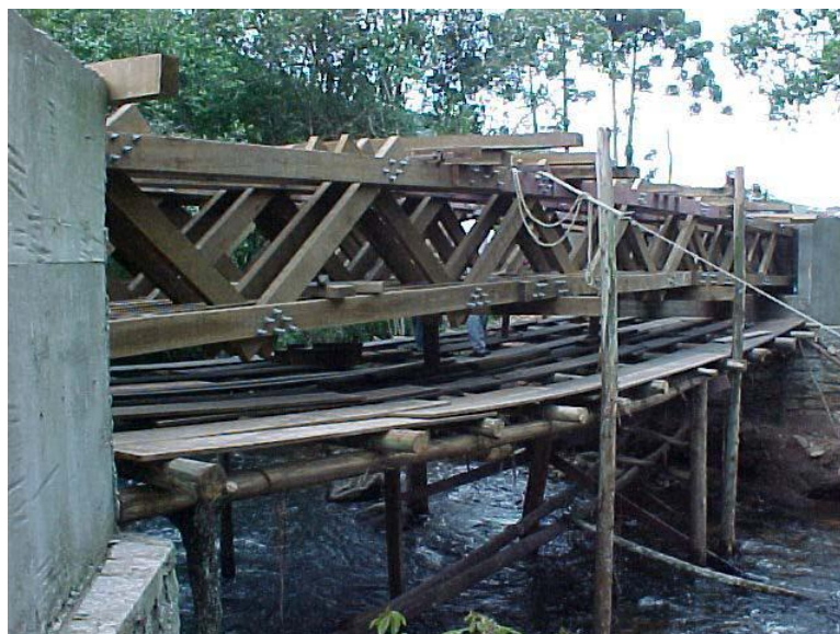
Figura 2.15 – Vista lateral da Ponte Aiuroca. FONTE: JUNIOR(2006)
