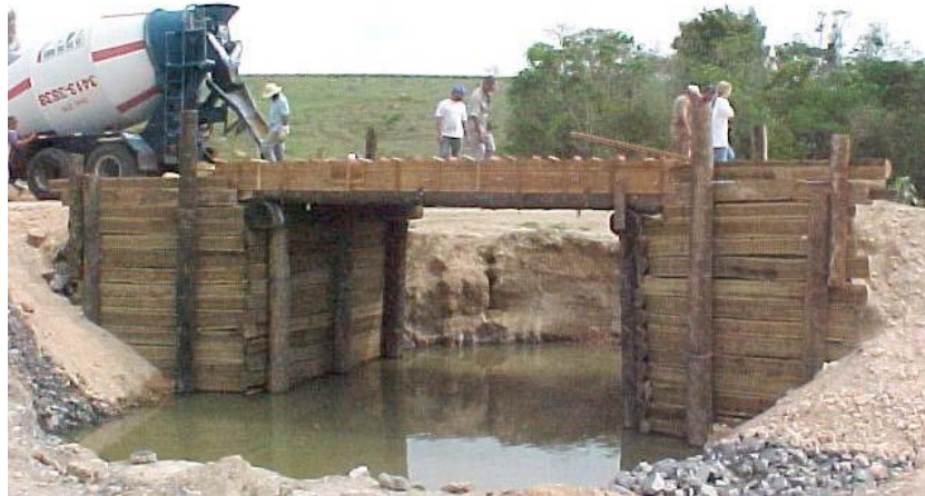
Figura 2.16 – Vista da Ponte Capela. FONTE: JUNIOR (2006)
