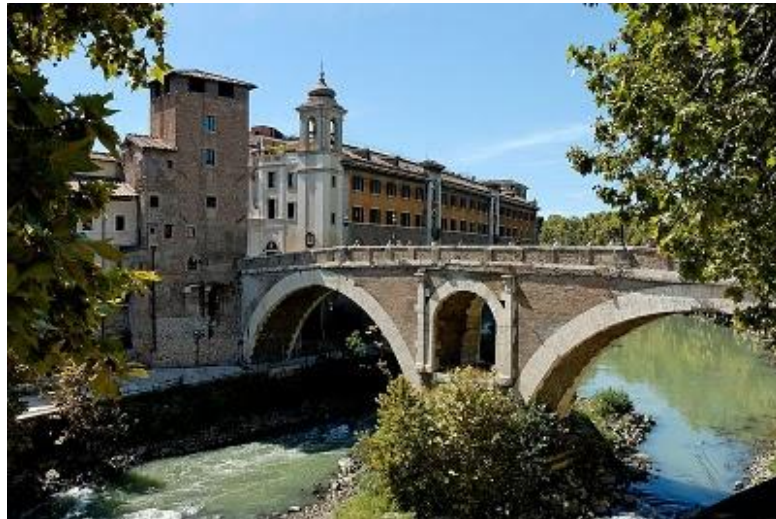
Figura 2.2 - Ponte de São Fabrício, localizada em Roma. FONTE: ( http://it.wikipedia.org/wiki/File:Ponte_Fabrizio_Roma_e_Pierleoni.jpg )
