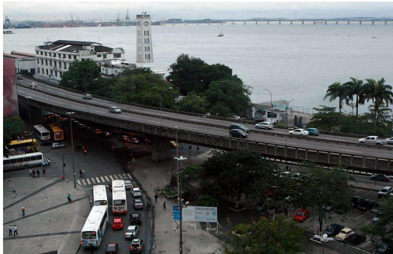
Figura 2.6 - Elevado da Perimetral. FONTE: ( http://oglobo.globo.com/rio/mat/2010/07/15/demolicao-do-elevado-da-perimetral- comeca-entre-meados-de-2012-inicio-de-2013-vai-durar-um-ano-917162870.asp )
