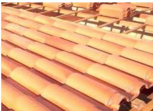
**Figura 2.11** - Telha cerâmica do tipo colonial
