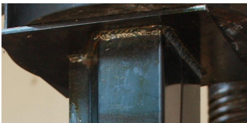
Figura 3.3: Chapas soldadas nas extremidades.
