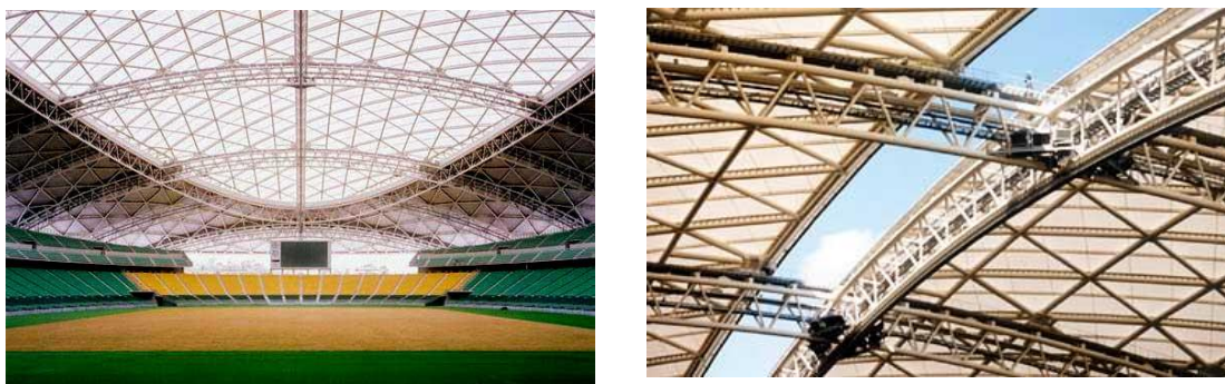
FIGURA 3.9 – Estádio de Futebol em Oita, Japão Fonte: METALICA..., 2009.
