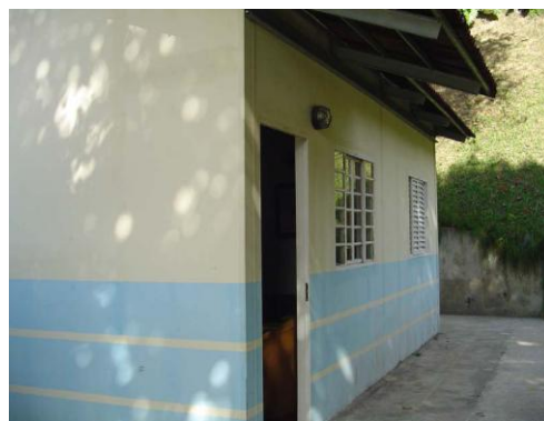
FIGURA 4.15 – Casa finalizada Fonte: USIMINAS, 1997.
