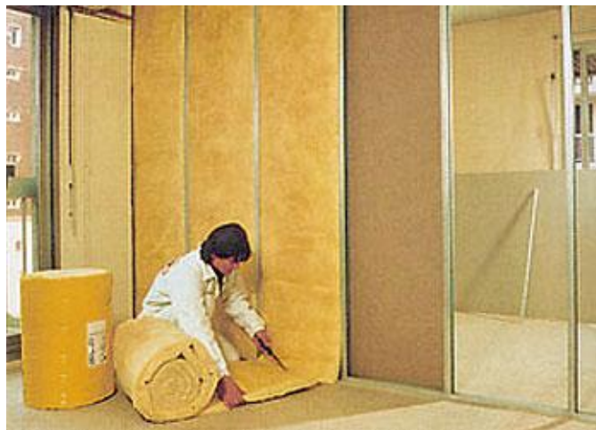
FIGURA 4.93 – Assentamento de lã de vidro entre as placas Fonte: FLASAN, 2011.
