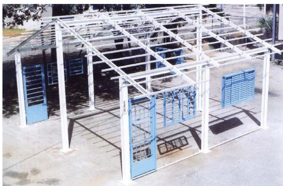
FIGURA 4.14 – Estrutura metálica montada Fonte: USIMINAS, 1997.
