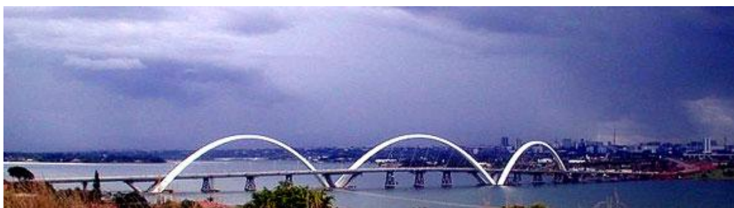
FIGURA 2.5 – Arcos usados como elemento de sustentação da Ponte JK, Brasília Fonte: CHAN, 2009.
