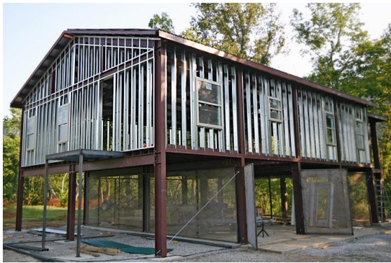
FIGURA 4.1 – Esqueleto metálico de casa, EUA Fonte: KODIAK..., 2011.
