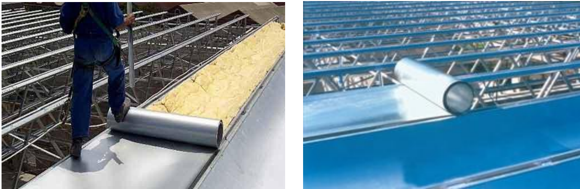
FIGURAS 4.76 – Sistema de cobertura metálica Roll-on Fonte: MARKO, 2010.
