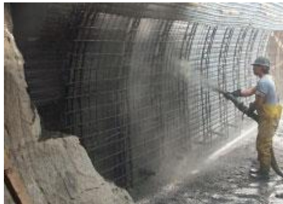
FIGURA 2.4 – Arcos metálicos usados como contenção Fonte: DSI FOSMINAS, 2010.
