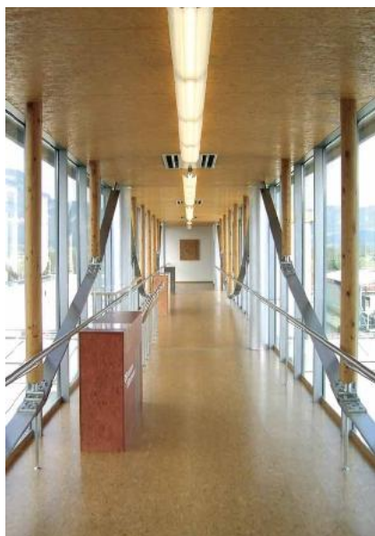
FIGURA 4.96 – Forro e piso em OSB Fonte: BANEMA, 2011.
