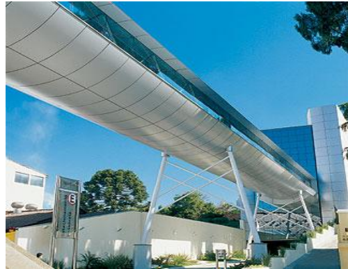
FIGURA 3.5 - Passarela high tech em Curitiba Fonte: GELINSKI, 2003.
