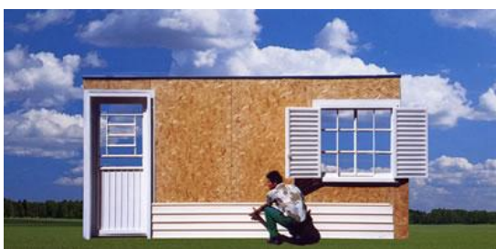
FIGURA 4.21 – Adicionando o acabamento em vinil Fonte: BIG FARM..., 2008.
