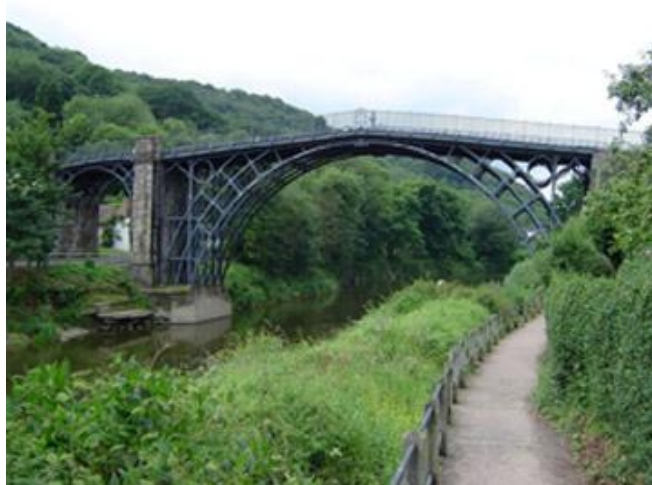
FIGURA 1.1 – Iron Bridge, em Coalbrookdale, Inglaterra Fonte: GYMPEL, 1996.
