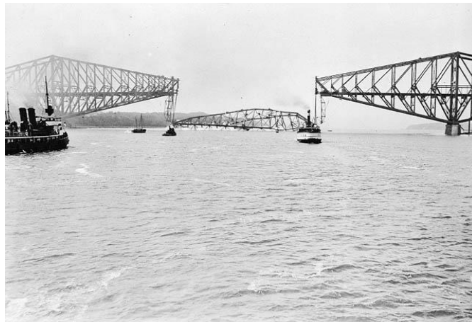
Figura 3. 4 - Vão central da ponte Quebec caindo no rio St. Lawrence em 11 de setembro de 1916[ www.maistorismo.net/.../ponte-de-quebec-4/ . Acessado em 10/07/2009].
