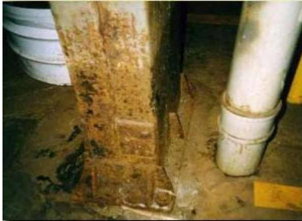
Figura 3. 6 - Corrosão uniforme
