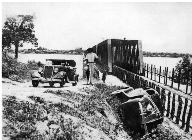
Figura 3. 14 - Construção da Ponte Marechal Hermes [www.pequi.tv/.../: Acessado em 08/08/2009].
