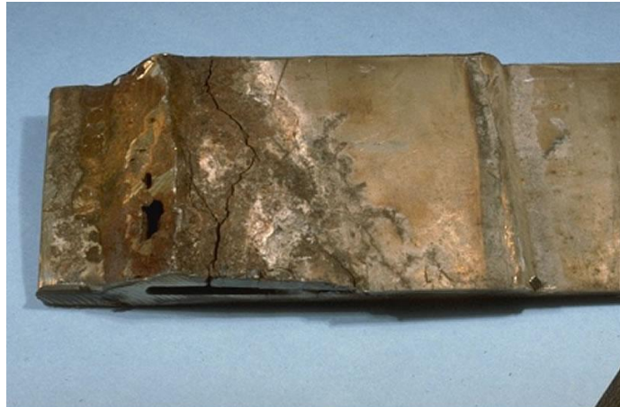
Figura 3. 9 - Corrosão sob tensão [ http://www.manutencaoesuprimentos.com.br/conteudo/4171-corrosao-sob-tensao-no-aco-inoxidavel/ . Acessado em 10/07/2009].
