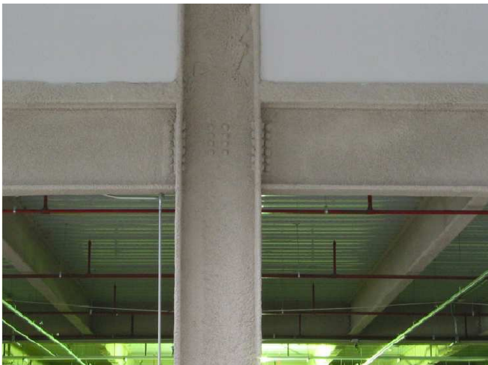
Figura 4.4 – Argamassa projetada (COSTA, 2001)
