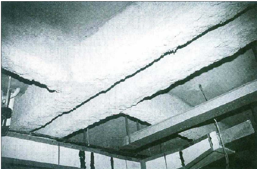
Figura 4.10 – Vigas de aço revestidas com argamassa de vermiculita, por meio de “spray” (COSTA, 2001)
