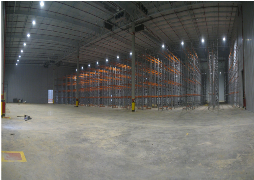
Figura 1-2. Interior do edifício (típico) Fonte: Medabil Sistemas Construtivos AS
