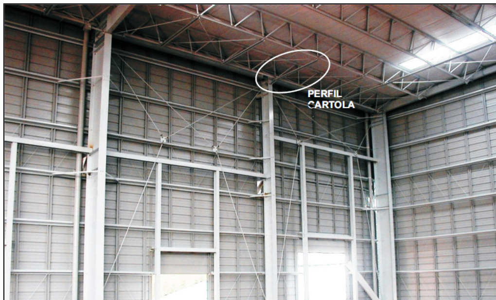
Figura 4-20. Fixação do perfil “cartola” na estrutura de cobertura
