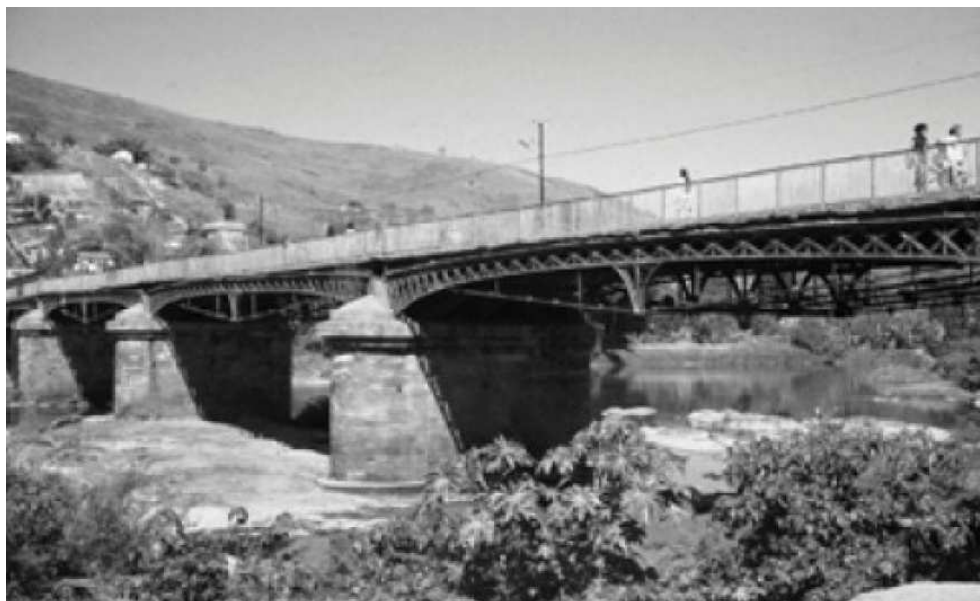
Figura 1.1 - Ponte sobre o Rio Paraíba do Sul (Fonte: PINHO e BELLEI, 2007).
