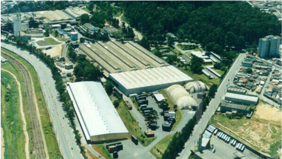
Figura 1.2 - Vista geral de um conjunto de galpões de uso geral (Fonte: Medabil S.A.).
