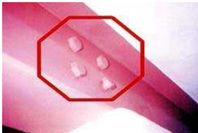
Figura 2.19: Erro na locação do furo. Fonte: Pravia e Betinelli, 1998 apud Teixeira, 2007.
