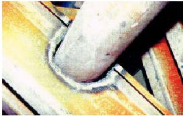
Figura 2.22: Furo para passagem de tubulação hidráulica. Fonte: Santos, 1998 apud Castro, 1999.
