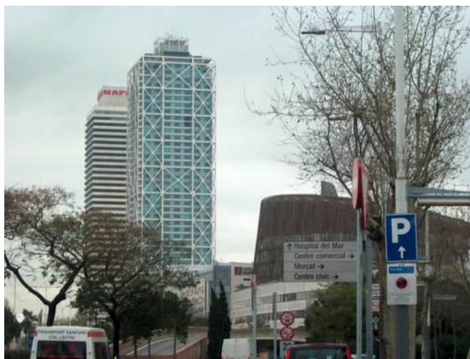
Figura 2.40– Exemplo de contraventamento em "X". Hotel Arts, Barcelona, 1986. Fonte: antecamera.blogs.sapo.pt/ . Acesso em 18 de junho de 2008.
