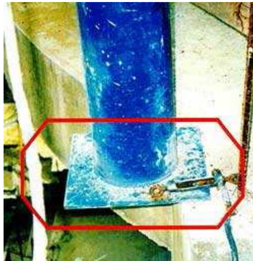
Figura 2.23: Incompatibilidade entre os projetos estruturais de concreto e metálico. Fonte: Pravia e Betinelli, 1998 apud Teixeira, 2007.
