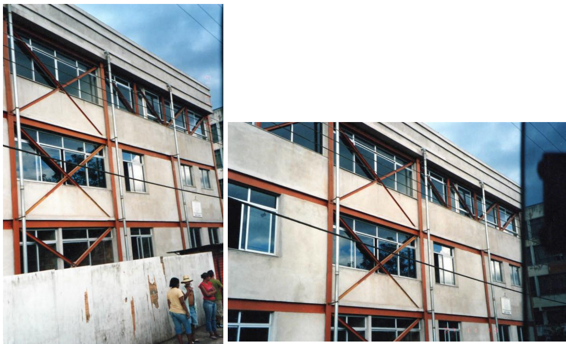
Figura 2.38: Interferência do contraventamento na posição das esquadrias. Projeto arquitetônico não coerente com o estrutural. Congonhas/MG, 2007.
