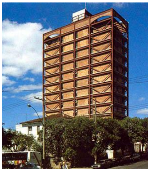
Figura 2.47: Contraventamento em K. Fonte: Dias 50 (2002).
