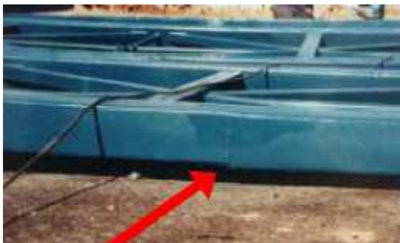
Figura 2.17: Incompatibilidade entre perfis. Fonte: Teixeira, 2007.
