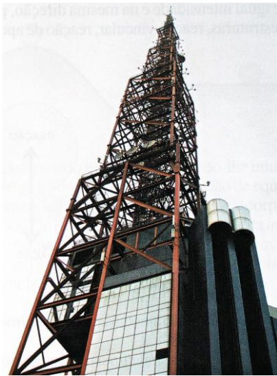
Figura C.4: Contraventamento em diagonal isolada com escora. Fonte: DIAS (2002).
