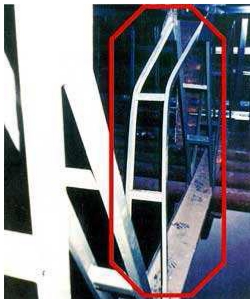
Figura 2.21: Flambagem global da diagonal da treliça. Fonte: Pravia e Betinelli, 1998 apud Teixeira, 2007.
