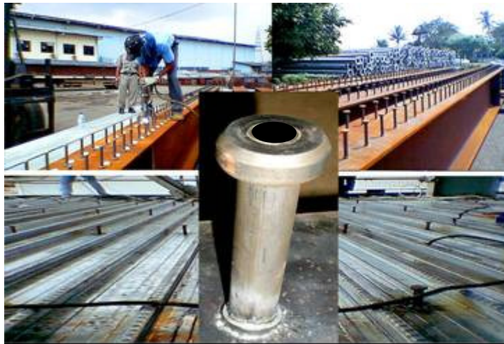
Figura 2.1 Conectores de cisalhamento em vigas. Fonte: ar-shearconnector.com
