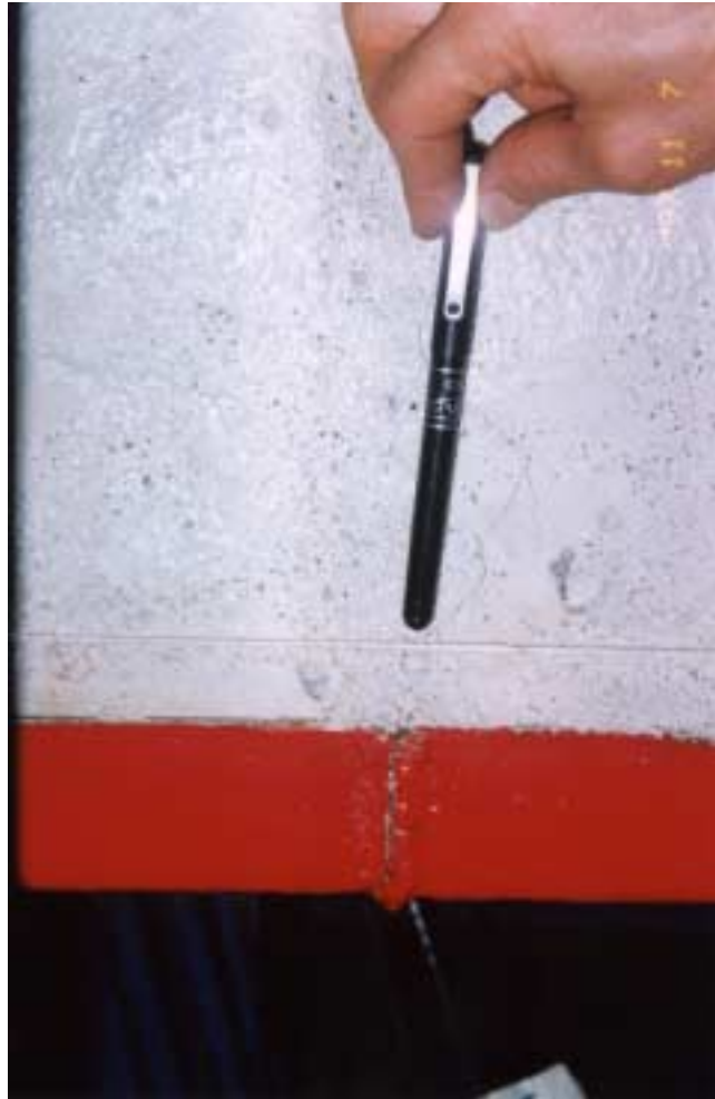
Foto 5.3 – Ruptura da Solda na Mesa Inferior da Viga VD1
