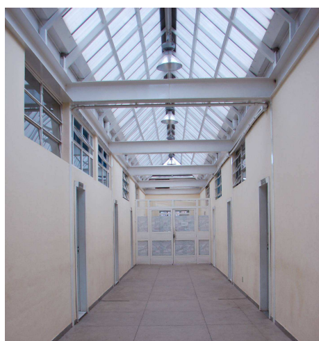
FIGURA 4.10–Foto do corredor central com cobertura em policarbonato.
