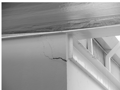
Figura 6.21. Trincas existentes na interface estrutura/fechamento – exterior (e) e no interior.
