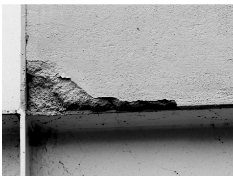
Figura 6.21. Trincas existentes na interface estrutura/fechamento – exterior (e) e no interior.
