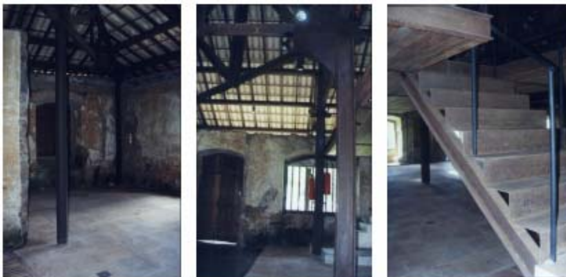
Figura 4. 5 – Pilares metálicos e pilares do mezanino compostos por perfis I soldados.
