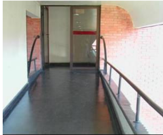
Figura 5.41 – Pequena rampa causada por desnivelamento entre blocos
