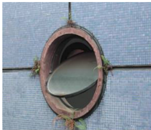
Figura 5.47 – Janela necessitando de manutenção
