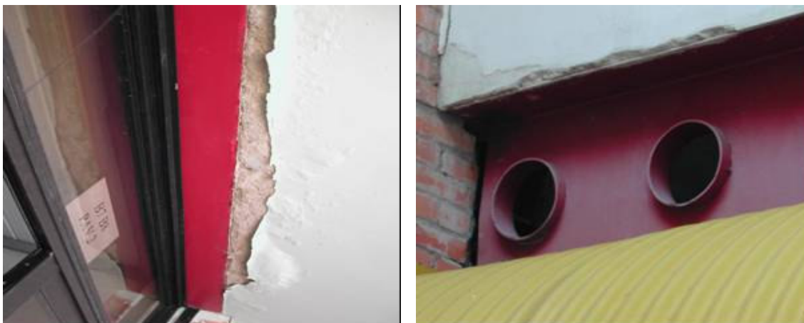
Figura 5.31 – Descascamentos de revestimento em laje e em parede externa
