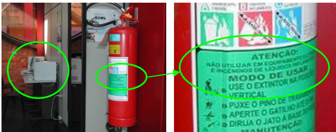
Figura 5.53 – Extintor inadequado próximo a equipamento ligado na rede elétrica
