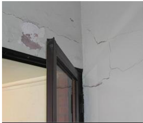
Figura 4.8 – Trincas em fechamento de alvenaria
