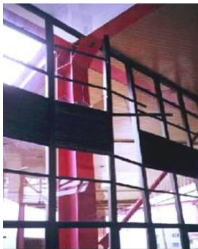
Figura 4.7 – Estragos em esquadrias causados pelo vento Fonte: CASTRO, 1999
