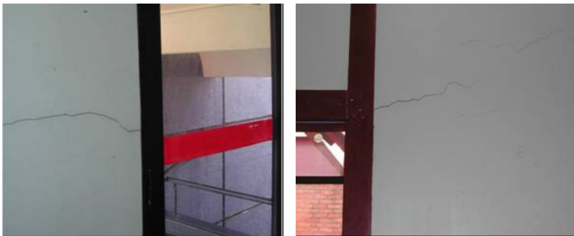
Figura 5.23 – Trincas devidas a cisalhamento
