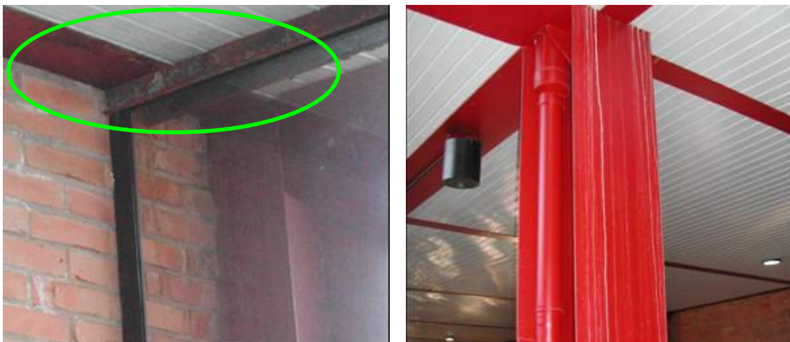
Figura 5.27 – Corrosão de peças metálicas causada por infiltração e evidências de infiltração na cobertura da biblioteca
