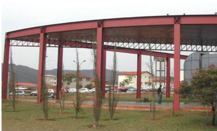
Figura 2.26 – Viga curva do pórtico de entrada
