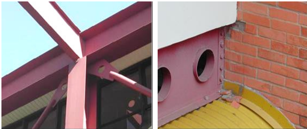
Figura 2.20 – Ligações soldada e parafusada
