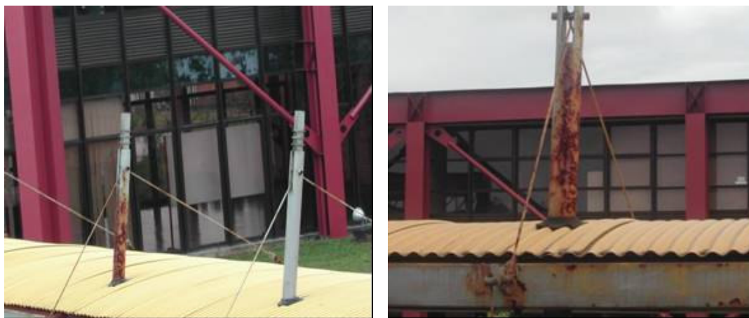
Figura 5.16 – Corrosão uniforme em elementos da passarela
