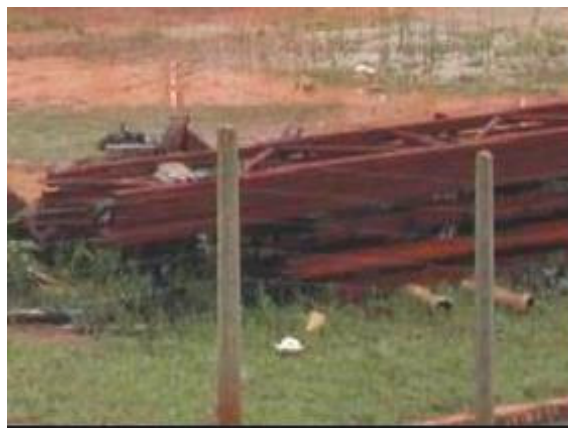
Figura 4.3 – Peças estruturais armazenadas inadequadamente e sujeitas à corrosão
