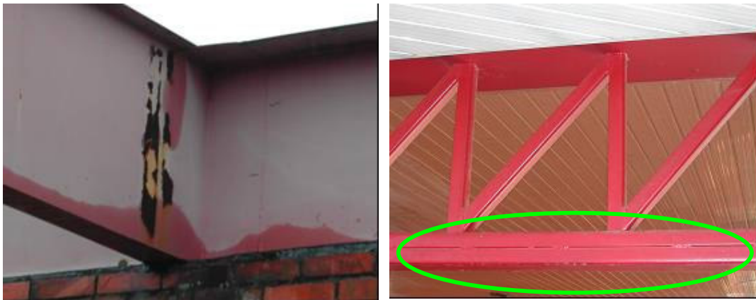
Figura 4.2 – Corrosão uniforme em vigamento; solda intermitente formando frestas susceptíveis à corrosão localizada
