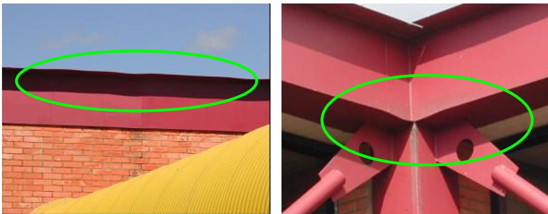
Figura 5.4 – Ondulações em mesas de vigas
