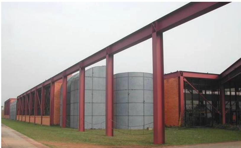
Figura 2.21 – Sistema aporticado
