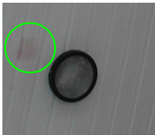
Figura 5.52 – Mancha no forro denotando problema na rede elétrica
