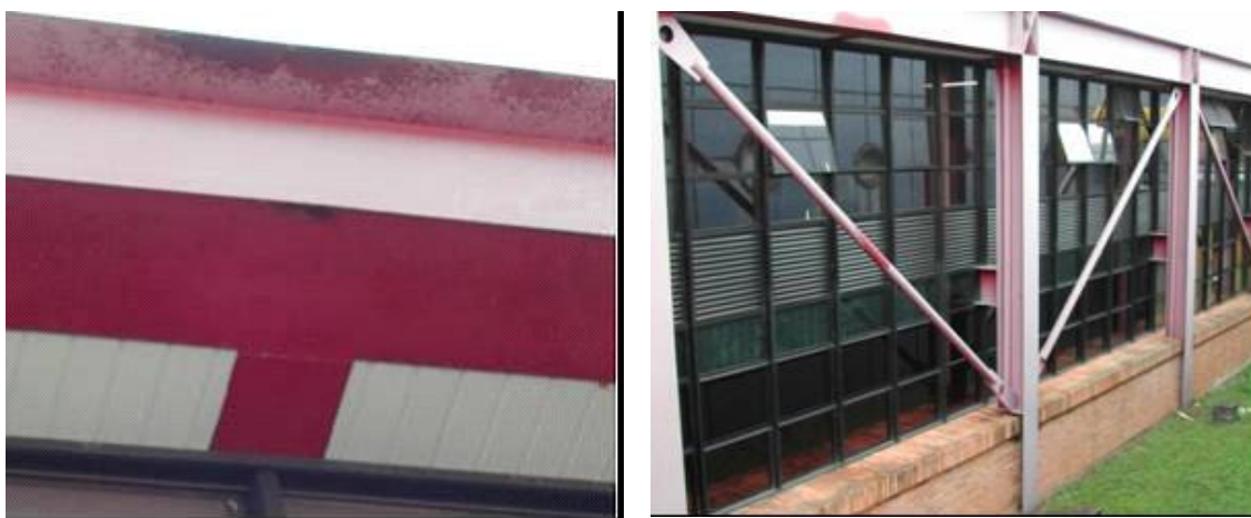
Figura 5.20 – Estado da pintura da estrutura metálica
