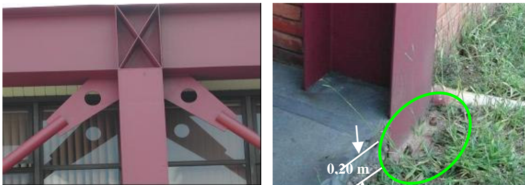
Figura 5.1 – Ligações soldada e parafusada bem executadas; piso interno pouco elevado em relação ao terreno
