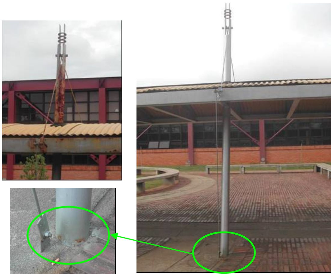
Figura 5.60 – Pilar antes e depois da repintura e sua base com princípio de corrosão
