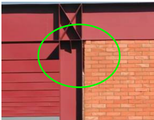
Figura 5.8 – Contato entre estrutura e fechamento em alvenaria
