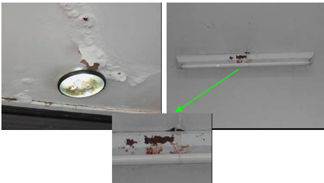
Figura 5.28 – Bolor no revestimento e corrosão na luminária causados por infiltração
