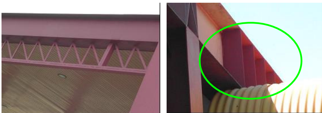
Figura 5.2 – Reforços estruturais em vigas no pórtico de entrada e no segundo pátio
