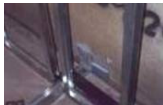
Figura 4.15 – Inserts metálicos de sustentação de fechamento em gesso acartonado; detalhe de fixação dos inserts em fechamento externo Fonte: SALES, 2001
