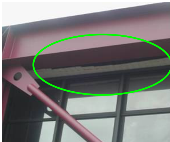
Figura 5.55 – Local propício para a entrada de aves no forro da edificação
