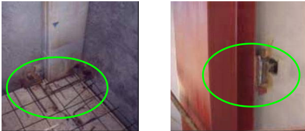
Figura 4.12 – Inserts metálicos aplicados na união de painéis de concreto e laje, e de painéis de isolite e pilar Fonte: SALES, 2001
