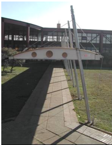
Figura 2.12 – Passarela central e detalhe do atirantamento
