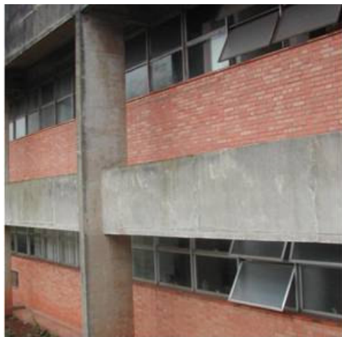
Figura 2.29 – Estrutura aparente em concreto armado em outra edificação do campus da UFOP
