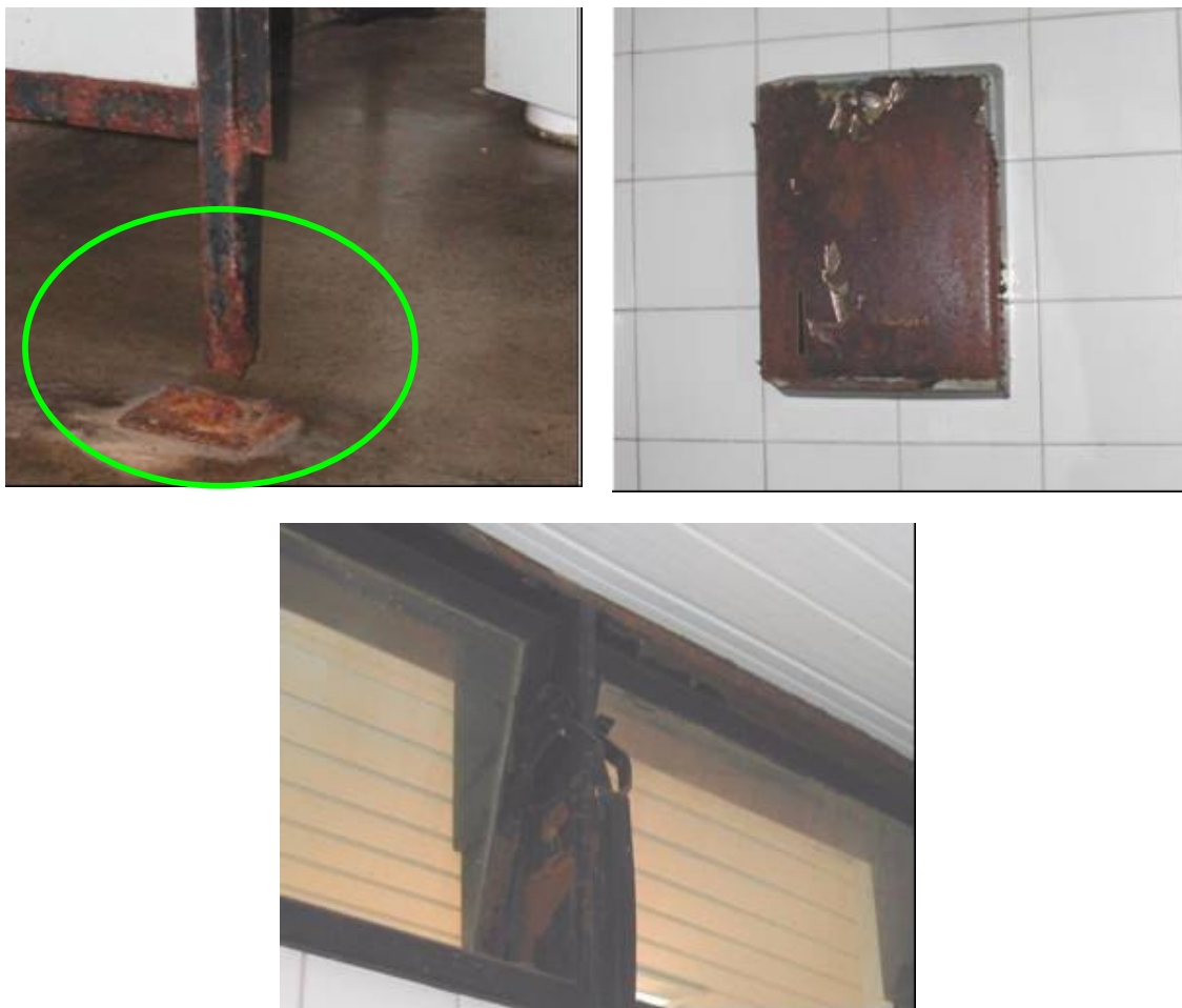
Figura 5.57 – Corrosão acentuada em peças dos banheiros
