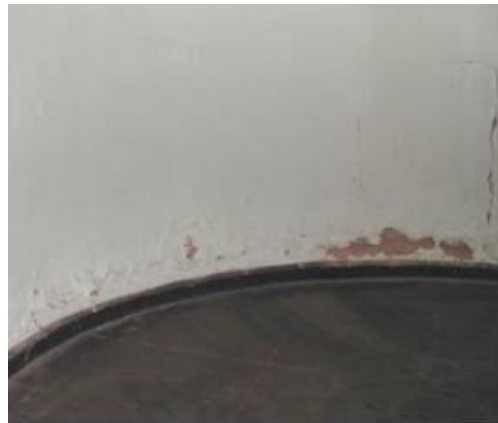
Figura 4.9 – Infiltrações causando descascamento de revestimento
