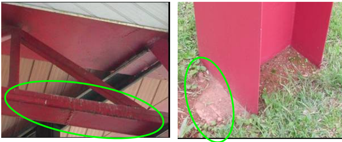
Figura 5.17 – Corrosão em frestas em viga com solda intermitente e em parafusos da base de pilar
