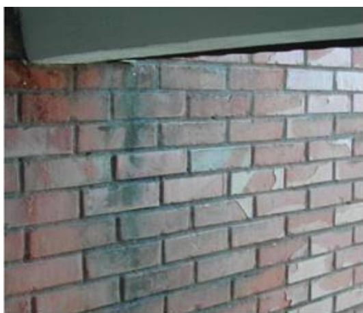
Figura 5.33 – Descascamento e limbo em paredes de alvenaria
