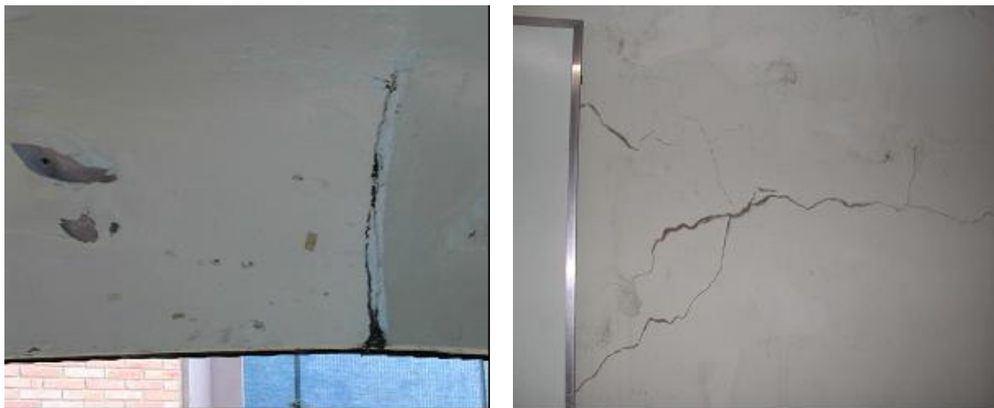
Figura 5.21– Trincas causadas por infiltração em laje arredondada de cobertura e em parede de alvenaria
