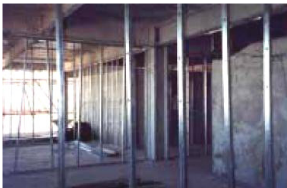
Figura 4.15 – Inserts metálicos de sustentação de fechamento em gesso acartonado; detalhe de fixação dos inserts em fechamento externo Fonte: SALES, 2001
