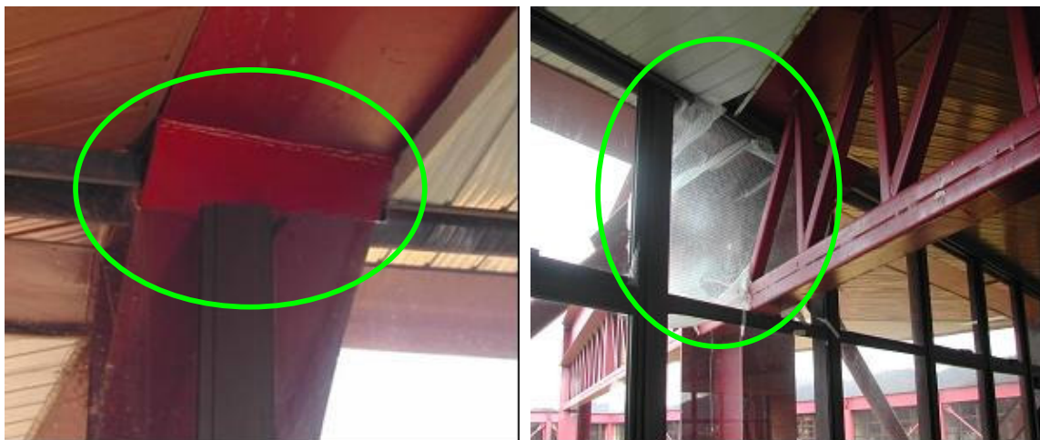
Figura 5.36 – Compatibilização e incompatibilização entre fechamento e estrutura
