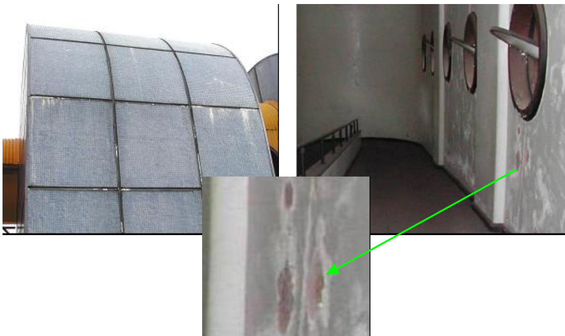
Figura 5.32 – Infiltração nas juntas de dilatação provocando o descascamento do revestimento no interior da edificação
