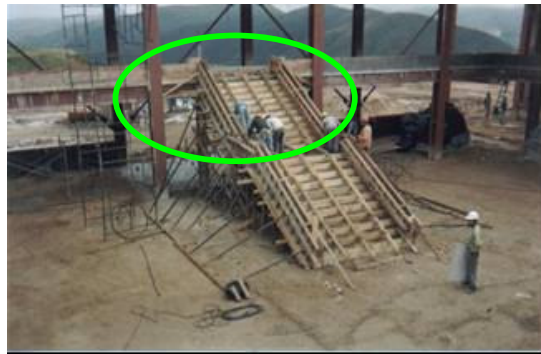
Figura II.2 – Viga v11 aplicada na chegada da escada da biblioteca
