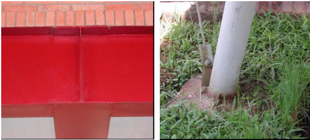
Figura 4.4 – Ligação rígida e ligação flexível
