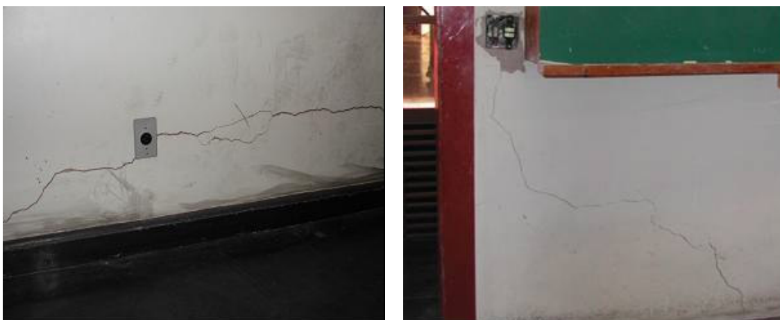
Figura 5.22 – Trincas em fechamento de alvenaria causadas por incompatibilidade de projetos
