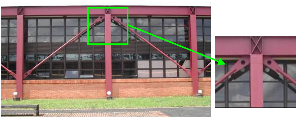
Figura 2.27 – Contraventamento vertical e detalhe de sua ligação
