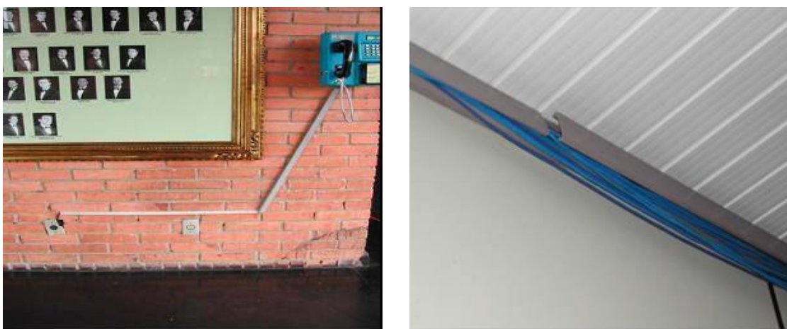
Figura 5.35 – Dificuldade de embutimento de fiação
