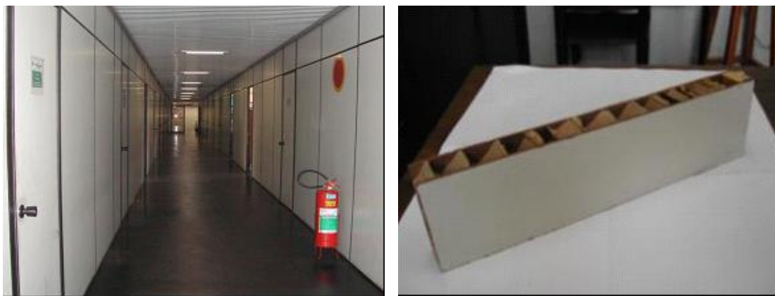
Figura 2.11 – Fechamento interno industrializado e recorte da divisória
