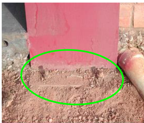
Figura 4.6 – Ligação parafusada susceptível à corrosão
