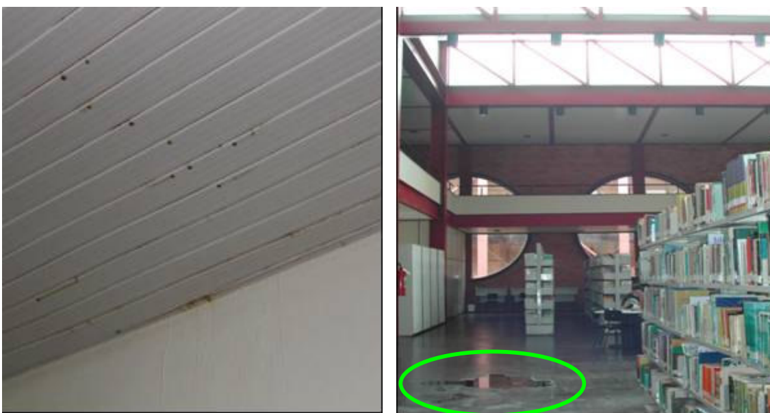
Figura 5.26 – Infiltração de água de chuva no forro de PVC e na cobertura da biblioteca
