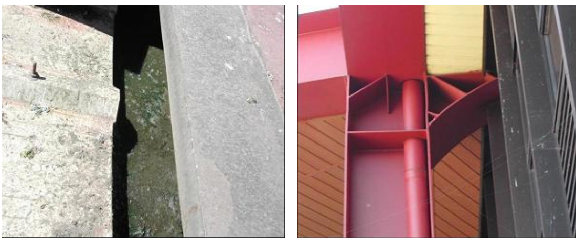
Figura 5.25 – Calha e tubo condutor de água de chuva
