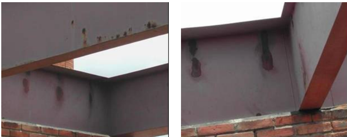
Figura 5.15 – Corrosão uniforme em vigas da cobertura
