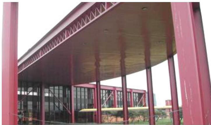
Figura 2.25 – Viga treliçada compondo o pórtico de entrada
