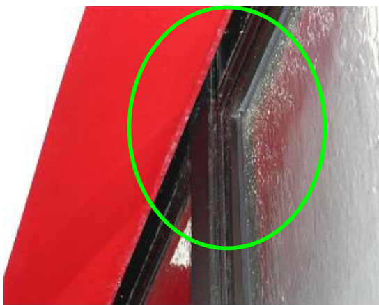
Figura 5.29 – Infiltração de água de chuva entre estrutura e fechamento
