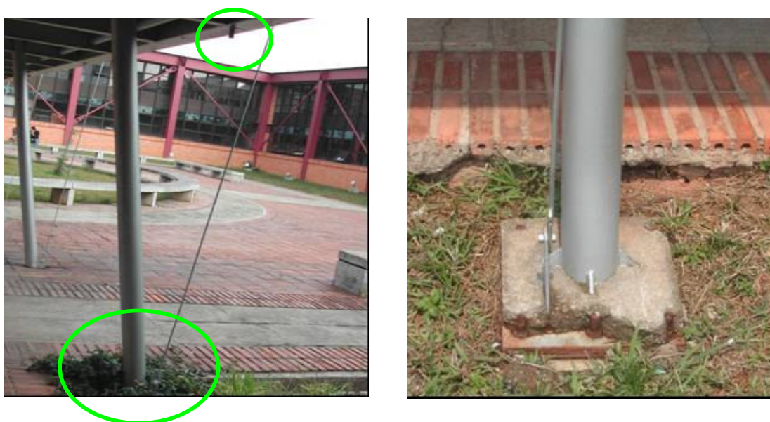
Figura 5.18– Pingadeira sobre pilar da passarela e placa de base à amostra
