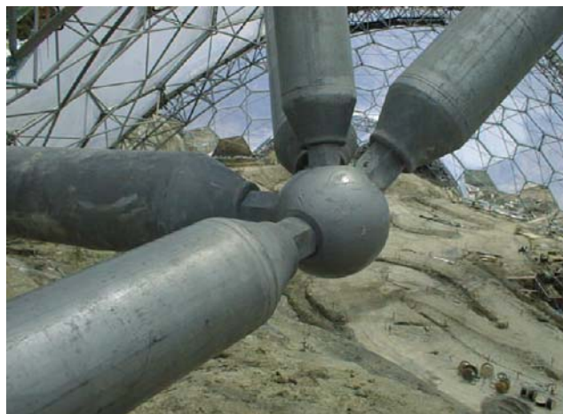
Fig. 82, Detalhe do nó da viga em tubo inferior e diagonais. Fonte: Knebel 2005.
