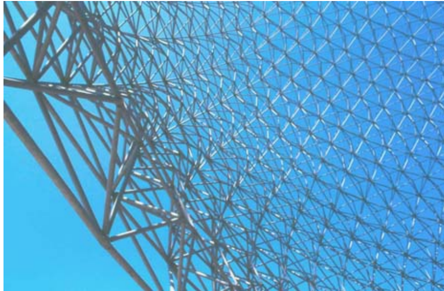
Fig. 51, O modelo estrutural da Biosfera com padrões triangulares externos e hexagonais internos Fonte: Boake, 2005
