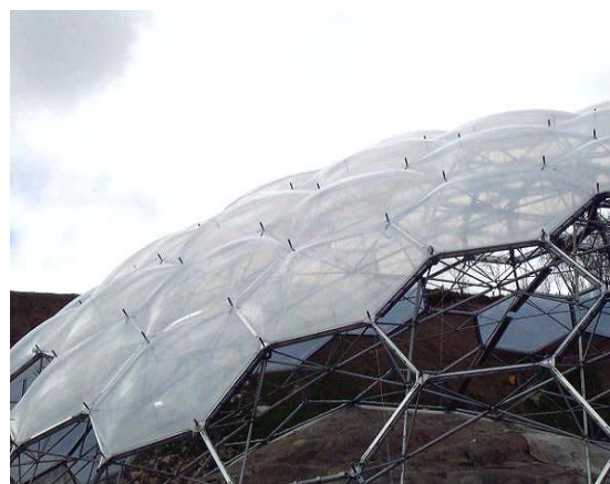
Fig. 79, A montagem da estrutura Hex-Tri-Hex. Fonte: Metálica 2004.
