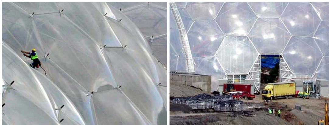
Figs. 93 e 94, A cobertura realizada em painéis de ETFE. Fonte: Metálica 2004.
