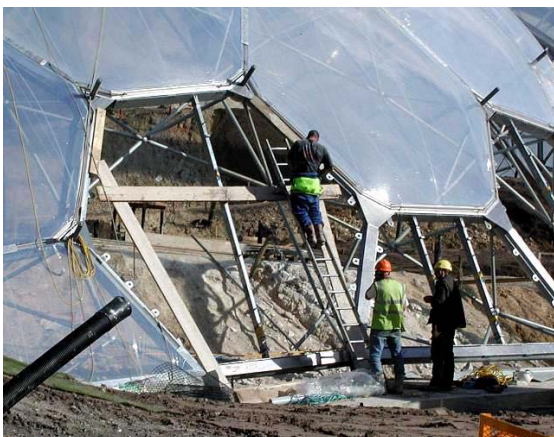
Fig. 79, A montagem da estrutura Hex-Tri-Hex. Fonte: Metálica 2004.
