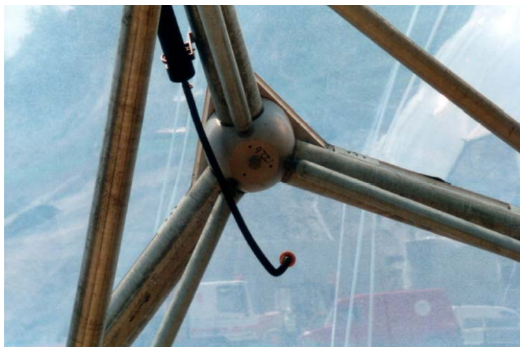
Fig. 92, O sistema de insuflamento de ar. Fonte: Knebel 2005.
