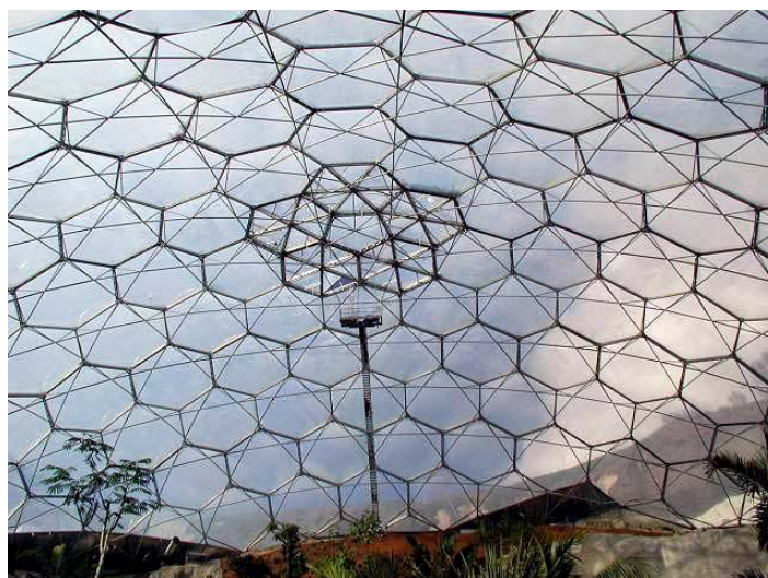
Fig. 78, O interior da estrutura Hex-Tri-Hex. Fonte: Metálica 2004.
