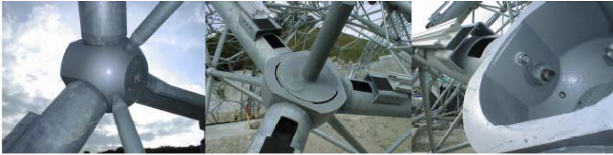
Fig.80, Os nós das vigas superiores. Fonte: Knebel 2005.
