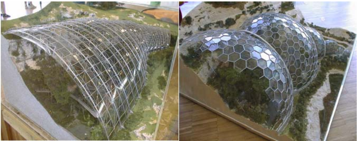
Fig. 71 e 72, O primeiro modelo estrutural e a configuração adotada. Fonte: Knebel 2005
