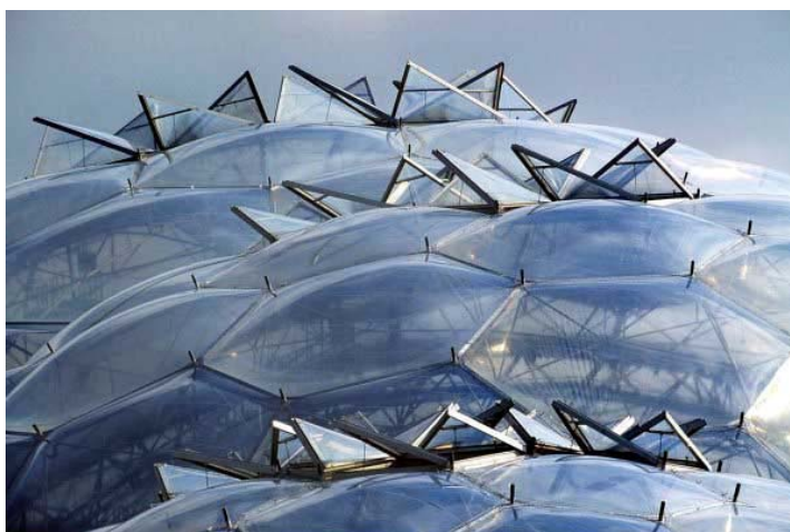
Fig. 87, Vista do sistema superior de ventilação. Fonte: Metálica 2004.
