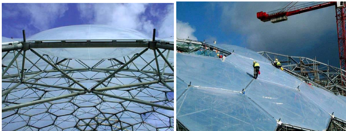
Figs. 90 e 91, Os travesseiros de ETFE instalados. Fonte: Knebel 2005.
