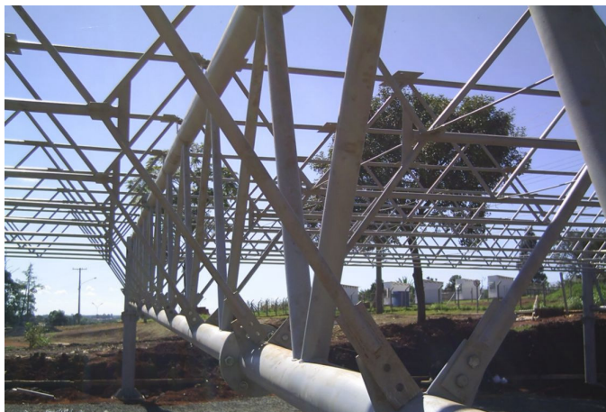
Figura 6.36: Ajustes finais das ligações das mãos francesas. Fonte: V&M / Unicamp, 2005.
