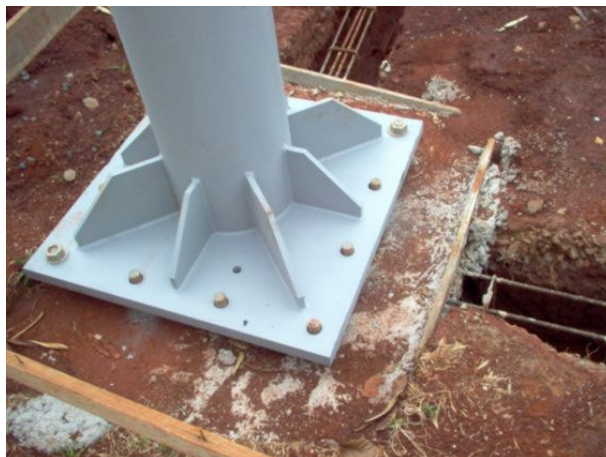
Figura 6.18: Detalhe do baldrame. Fonte: V&M / Unicamp, 2005.
