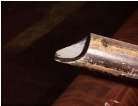
Figura 6.21: Corte para encaixe tipo “boca-de-lobo” em diagonal da terça. Fonte: Arquivo pessoal, 2005.
