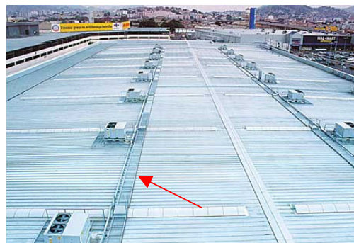
Figura 3.32: Passarela metálica em chapa expandida sobre cobertura. Fonte: http://www.icec.com.br/leroy/index.htm Acesso em junho de 2005.
