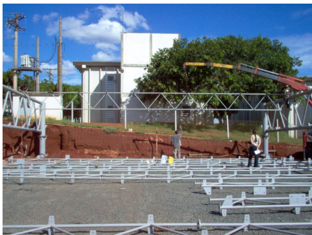
(a) Início do içamento da terça na primeira etapa
