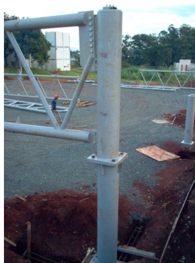
(b) Ligação Pilarete/Coluneta
