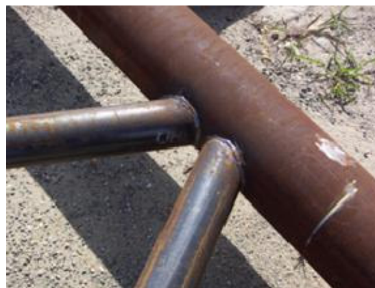
Figura 5.25: Ligação soldada entre as peças. Montagem da estrutura na empresa Brafer. Fonte: Arquivo Pessoal, 2005.
