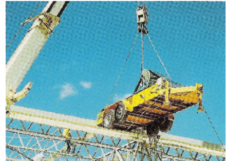
Figura 3.6: Perfilação da chapa in loco. Fonte: Catálogo Roofway, 2004.
