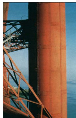
Figura 2.17: Ponte Firth of Forth. Detalhe. Fonte: EEKHOUT, 1996.
