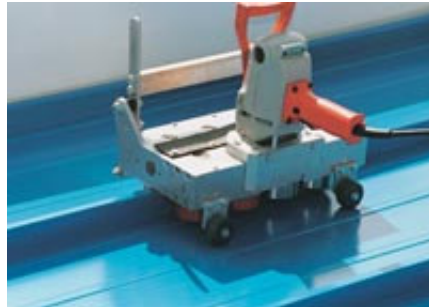
Figura 3.5: Processo de zipagem da telha. Fonte: http://www.perfilor.com.br Acesso em abril 2004.
