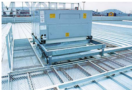
Figura 3.32: Passarela metálica em chapa expandida sobre cobertura. Fonte: http://www.icec.com.br/leroy/index.htm Acesso em junho de 2005.
