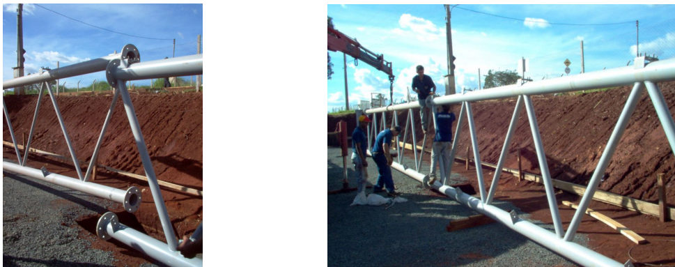
Figura 6.29: Montagem viga principal. Fonte: V&M / Unicamp, 2005.
