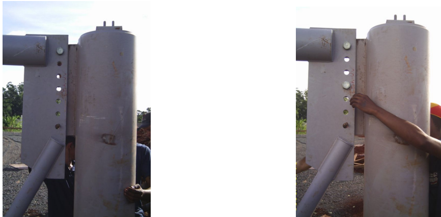
Figura 6.28: Seqüência de montagem do conjunto viga principal / pilarete no Campus da Unicamp. Fonte: V&M / Unicamp, 2005.
