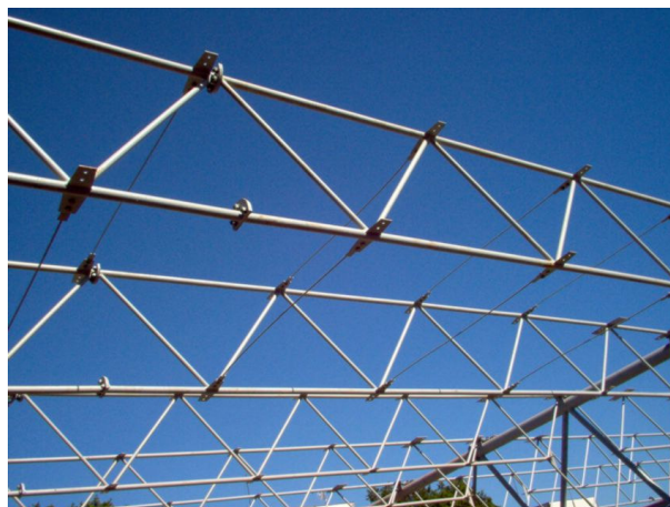
Figura 6.33: Travamento das terças. Fonte: V&M / Unicamp, 2005.
