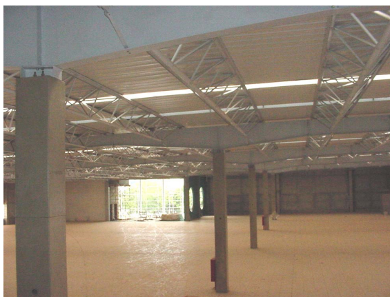
Figura 3.11: Terças treliçadas de seção transversal triangular. Fonte: Arquivo pessoal, 2004.
