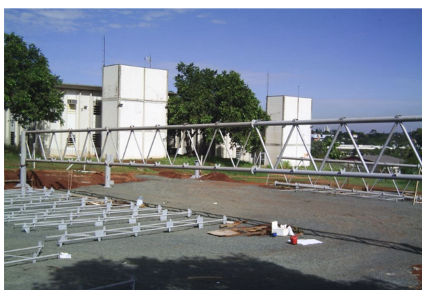
(c) Viga principal 2 posicionada na coluneta.
