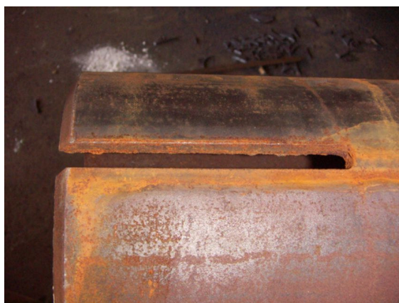
(a) Tubos dos banzos da Viga Principal.
