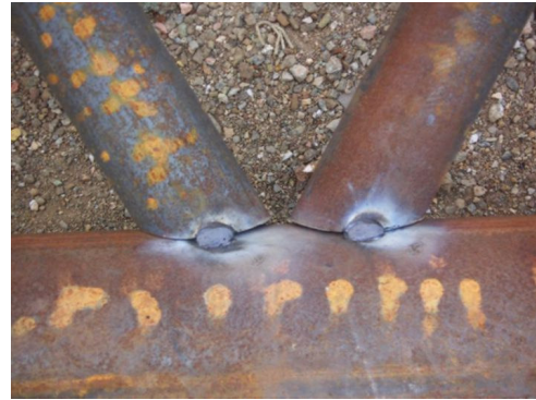
(b) Nó do banzo inferior da Viga Padrão Principal
