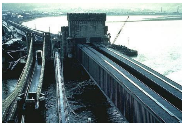
Figura 2.14: Ponte Conway, Inglaterra. Fonte: http://www.archinform.net/projekte/4917 . Acesso em agosto 2005.
