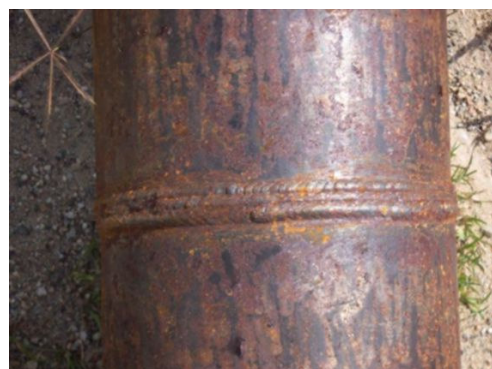
(b) Detalhe da Solda
