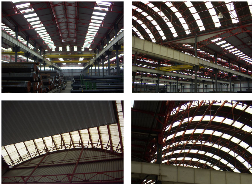
Figura 3.10: Iluminação zenital. Galpão da Açotubo, Guarulhos/SP. Fonte: Arquivo pessoal, 2005.
