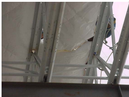
Figura 3.29: Manta em lã de vidro. Sistema de Cobertura do Hipermercado EXTRA, Belo Horizonte, MG. Fonte: Arquivo pessoal, 2004.
