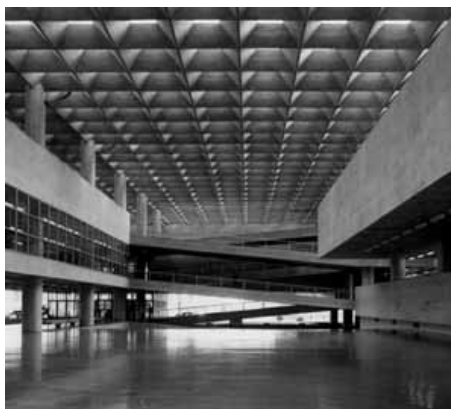
(c) Grelha de vigas da cobertura da FAUUSP, São Paulo.
