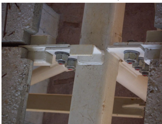
(c) Detalhe dos conectores
