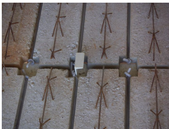
b) Detalhe do apoio da laje pré-moldada na viga metálica, já com os conectores soldados.
