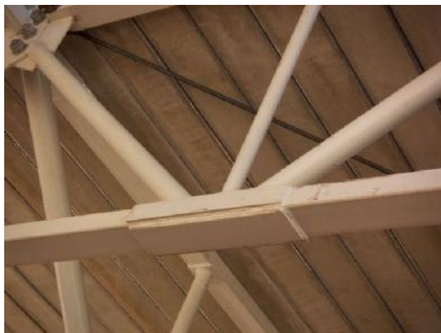
Figura 4.22: Reforço do nó na treliça tubular. Fonte: Arquivo Pessoal, 2005.
