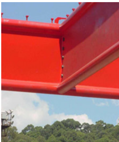
Figura 3.24: Viga de seção composta Fonte: COSTA, 2004.
