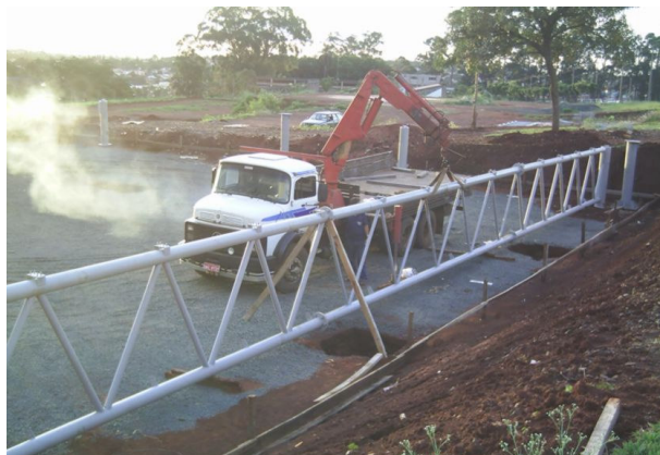
(a) Içamento da viga principal 1.
