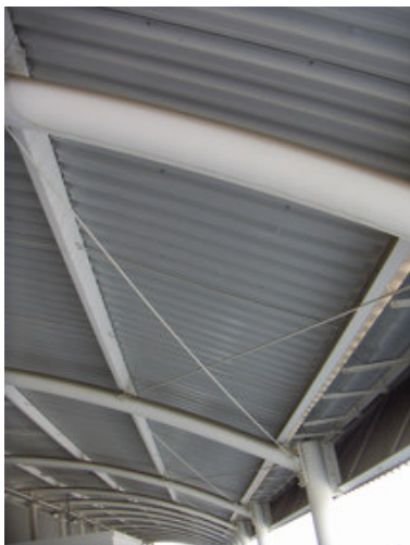
(a) Na extremidade da cobertura
