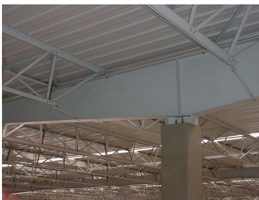
Figura 3.23: Viga em alma cheia com seção transversal "I", altura variável. Galpão em construção em Belo Horizonte, MG. Fonte: Arquivo pessoal, 2004.
