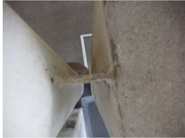
Figura 6.12: Detalhe da conexão entre o pilar tubular de seção circular e a alvenaria. Sede da Açotubo, Guarulhos. Fonte: Arquivo pessoal, 2005.
