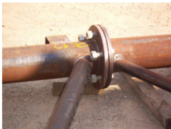
Figura 5.24: Ligações entre as peças e entre os elementos estruturais. Montagem da estrutura na empresa Brafer. Fonte: Arquivo Pessoal, 2005.
