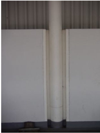
Figura 6.11: Elevação conjunta pilar / alvenaria. Sede da Açotubo, Guarulhos. Fonte: Arquivo pessoal, 2005.
