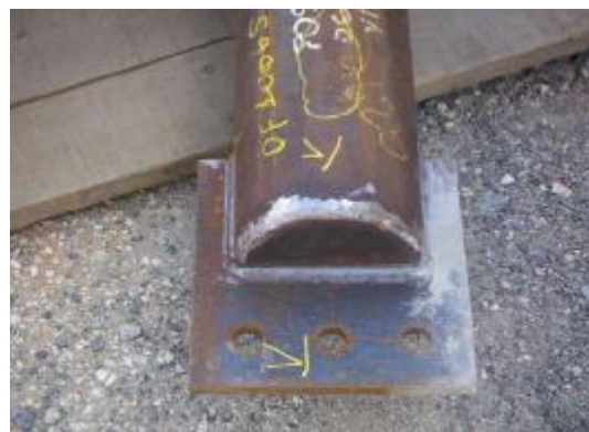
Figura 5.28: Ligação com chapa de gusset. Montagem da estrutura na empresa Brafer. Fonte: Arquivo pessoal, 2005.
