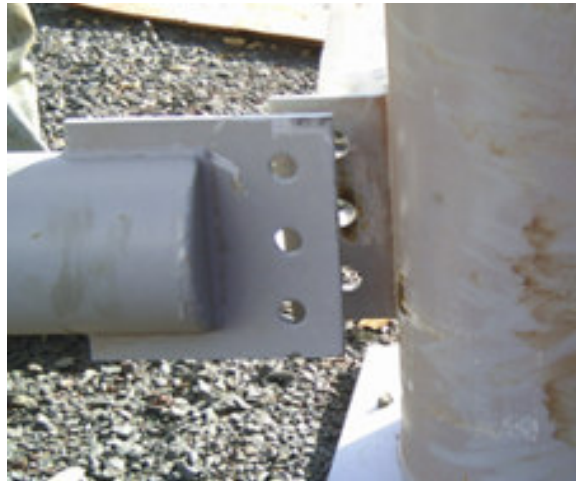
Figura 4.20: Ligação com chapa de gusset. Montagem de estrutura em perfil tubular na Fábrica da Brafer, Araucária/PR. Fonte: Arquivo pessoal, 2005.
