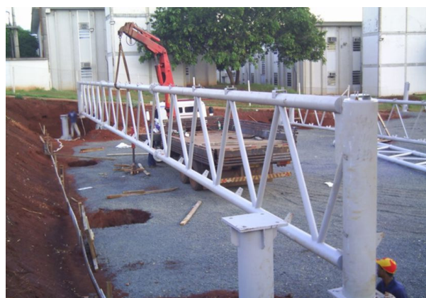
(b) Posicionamento da viga principal 1 na Coluneta.
