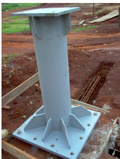
(a) Coluneta metálica tubular
