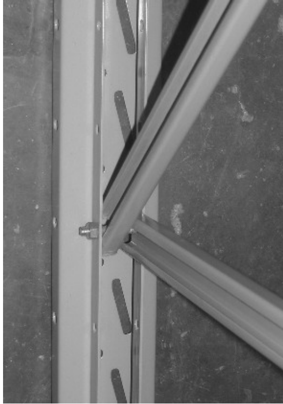
Figura 5.8. Ligação dos contraventamentos à coluna.
