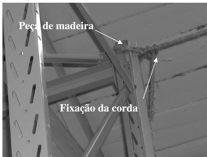
Figura 5.20. Fixação da corda à estrutura.
