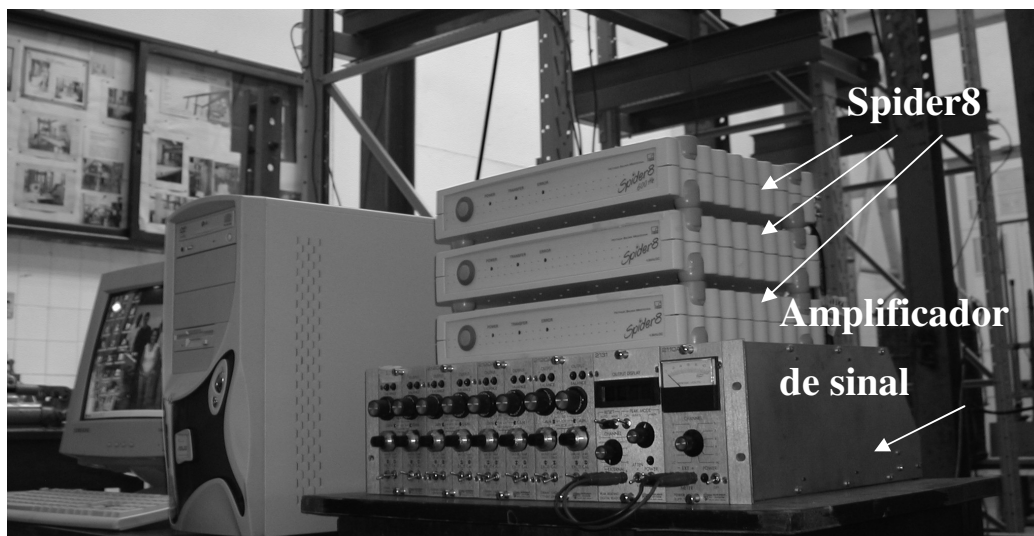
Figura 5.30. Montagem do sistema de aquisição de dados.
