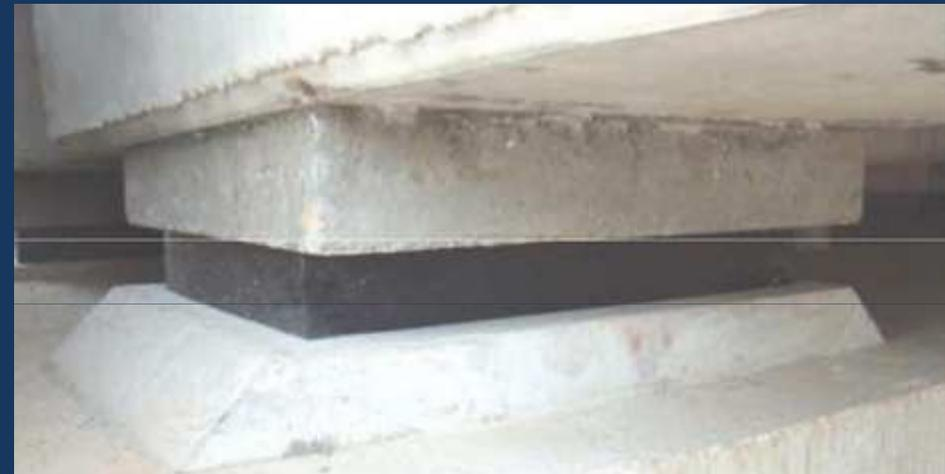
Elastômero sintético policloropreno, polímero do cloropreno.
