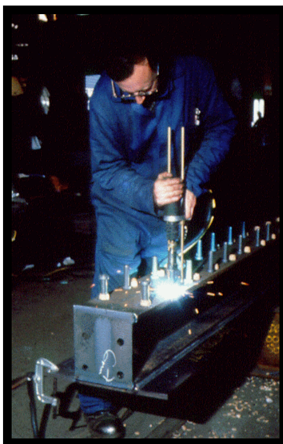
Figura 2.7 – Soldagem de conectores de cisalhamento. (ESDEP, 1996)
