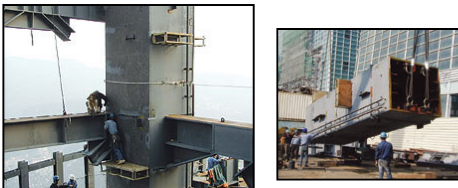
Figura 1.4 – Edifício Taipei 101 – Pilares Preenchidos (enr.construction.com).
