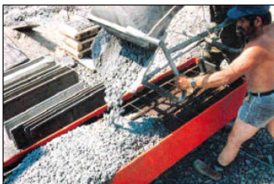
Figura 2.5 – Concretagem de pilar misto parcialmente revestido. (Stark, 2001)
