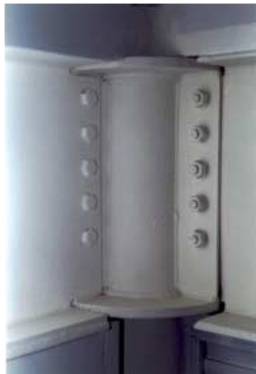
Figura 2.14 – Detalhe de uma ligação de pilar tubular de seção circular e viga “I” (Fonte: Gerken, 2003).
