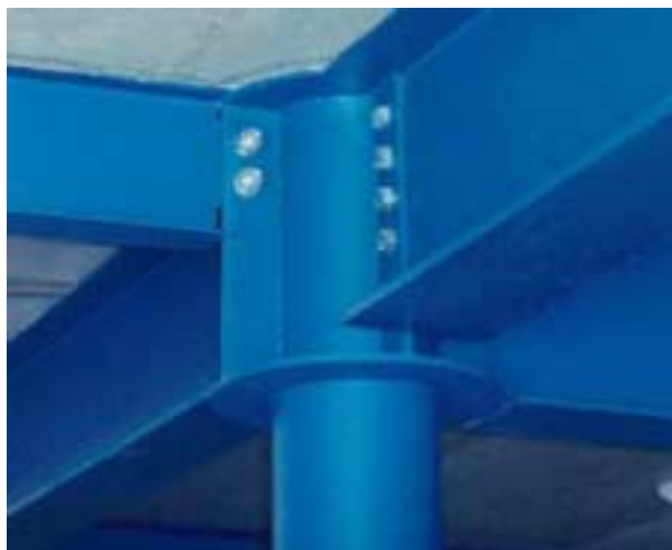
Figura 1.1 – Ligação de um pilar de seção circular com vigas “I”.
