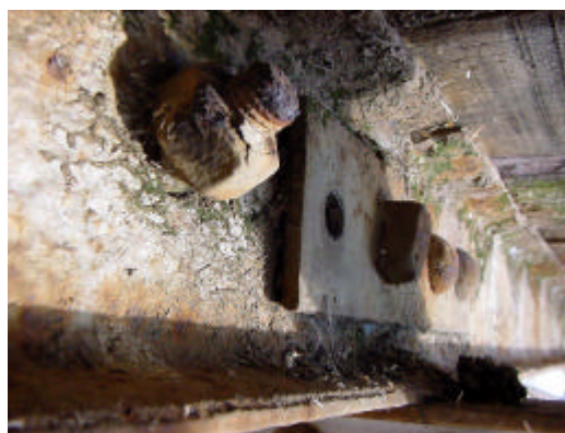
6.10 (q) - Destaca-se a região onde a união por parafusagem está comprometida, com sinais de corrosão.
