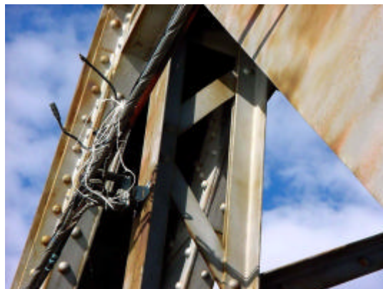
6.8 (d) - Nota-se, também, o sistema deficiente nas instalações elétricas.
