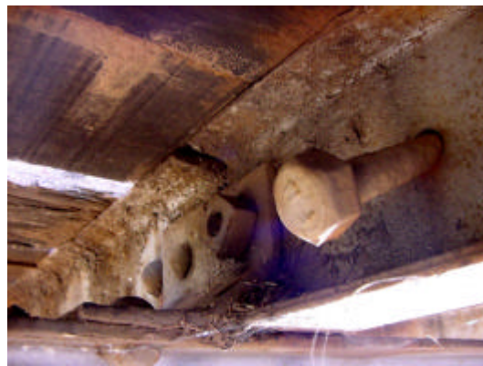
6.10 (p) - Destaca-se a região onde a união por parafusagem está comprometida, com sinais de corrosão.
