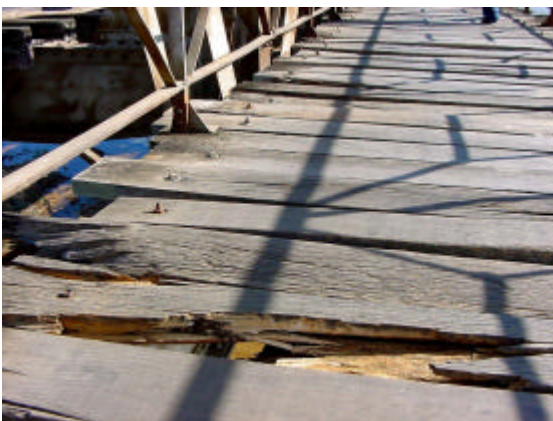
6.10 (k) - Destaca-se a deterioração da madeira, além do aspecto da retenção de umidade
