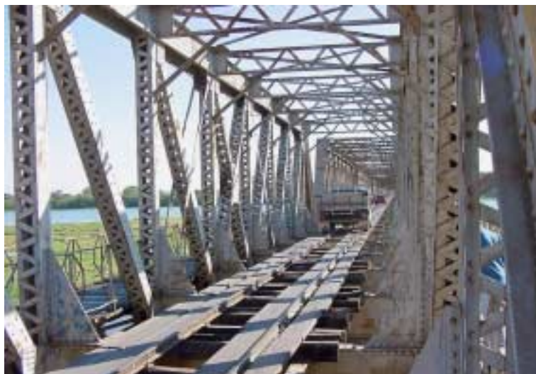
Figura 5.2 – Vista da seção transversal da ponte que mostra as tábuas colocadas para o tráfego de automóveis.
