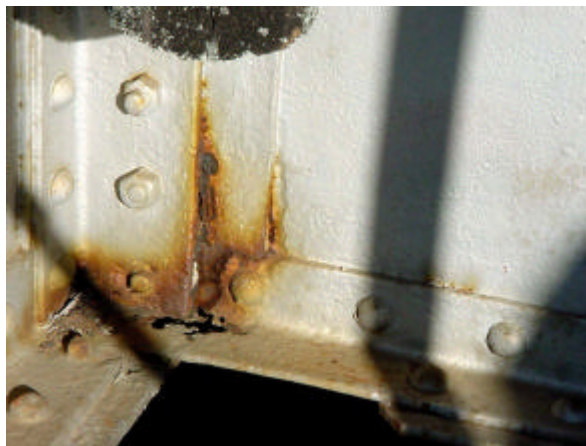
Figura 6.17 – Ataque corrosivo em chapas justapostas, unidas por parafusagem e rebitagem; nota-se o efeito mais pronunciado da corrosão na região onde o eletrólito fica retido e em locais de frestas.
