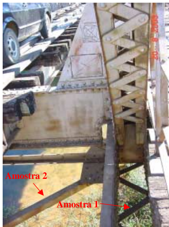
Figura 5.11 – Locais de onde foram retiradas as amostras para análise química e metalográfica da PMH.
