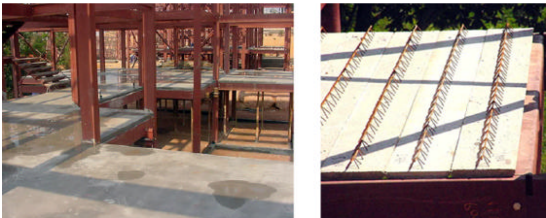
Figura 2.13: Sistema de lajes do edifício Alusa / Brastubo. Fonte: Núcleo do Aço: Cosipa.
