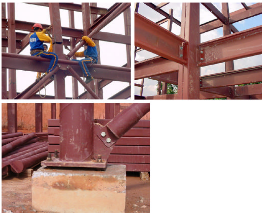
Figura 2.12: Ligações parafusadas do edifício Alusa / Brastubo. Fonte: Núcleo do Aço, Cosipa.
