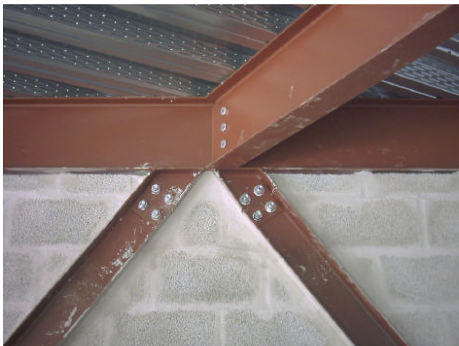
Figura 2.22: Sistema de estabilização da estrutura do edifício Bouganville. Fonte: Construtora Castro Pimenta
