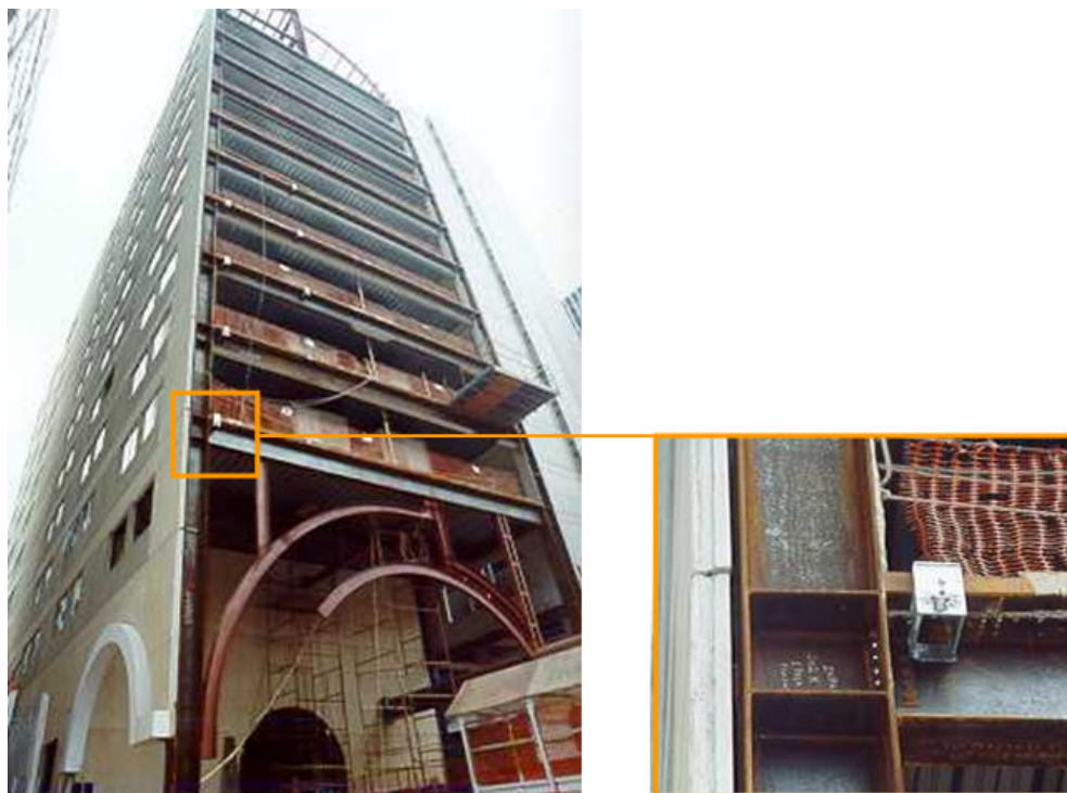
Figura 2.26: Sistema de fixação do fechamento externo no Hotel Íbis, São Paulo – SP.
