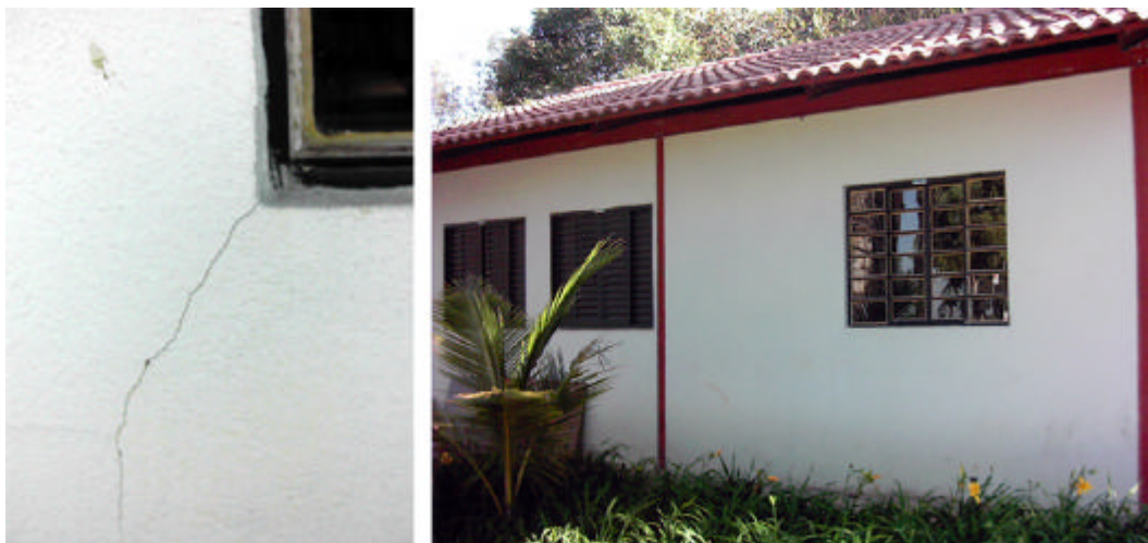
Figura 4.3: Trincas no reboco a partir da extremidade da abertura. Fonte: CGA USIMINAS.
