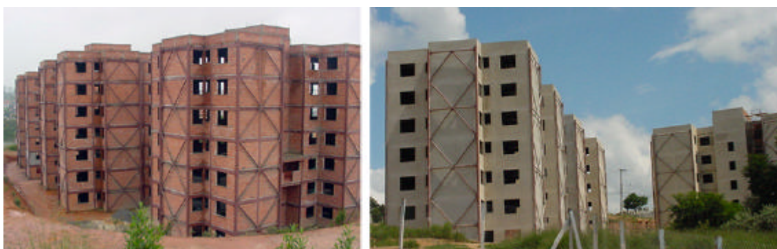
Figura 2.15: Revestimento externo do edifício Alusa / Brastubo, em reboco de argamassa. Fonte: Núcleo do Aço: Cosipa.
