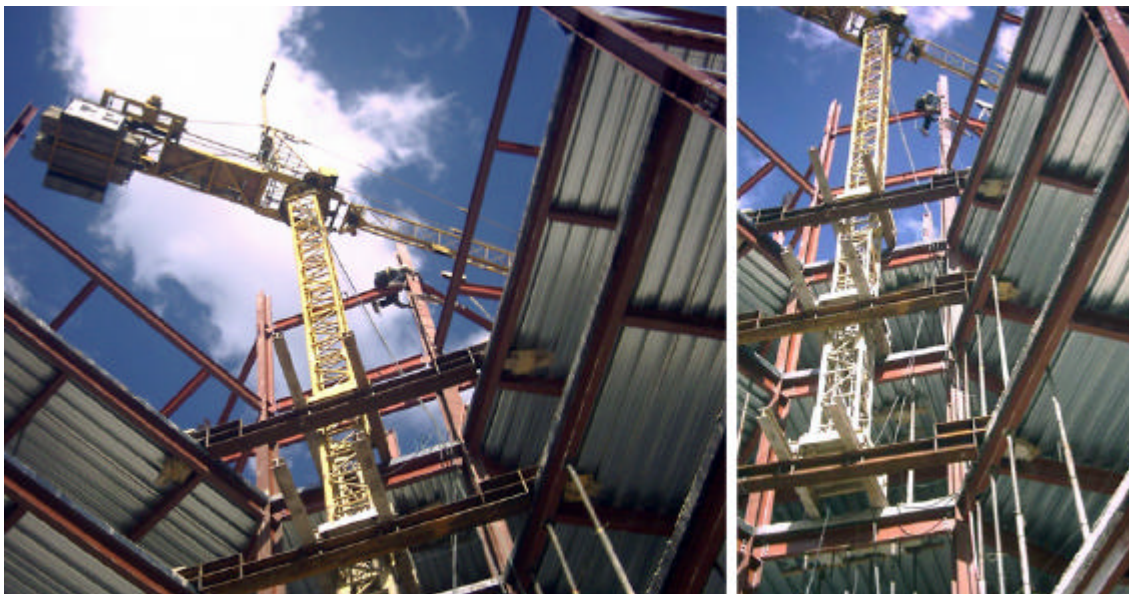
Figura 2.24: Processo de montagem da estrutura com grua apoiada sobre vigas. Fonte: Construtora Castro Pimenta
