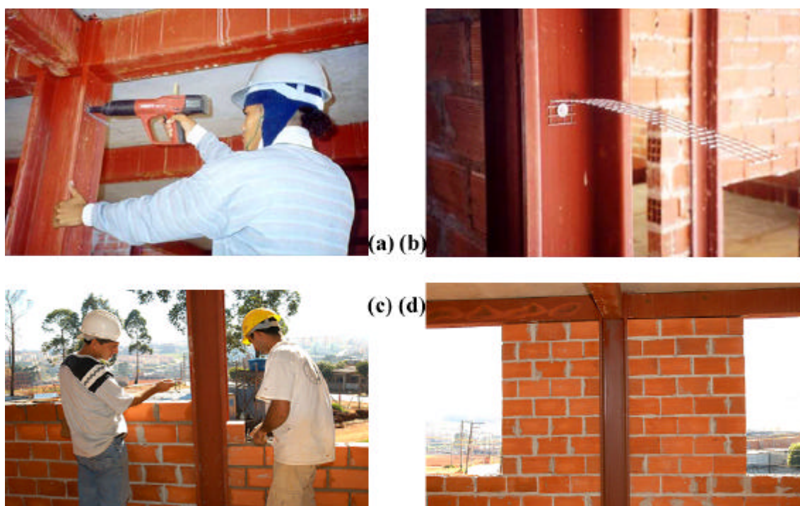
Figura 2.6: Sequência de execução das alvenarias com visualização das ligações da estrutura metálica do edifício Múltipla / Alphametal.
