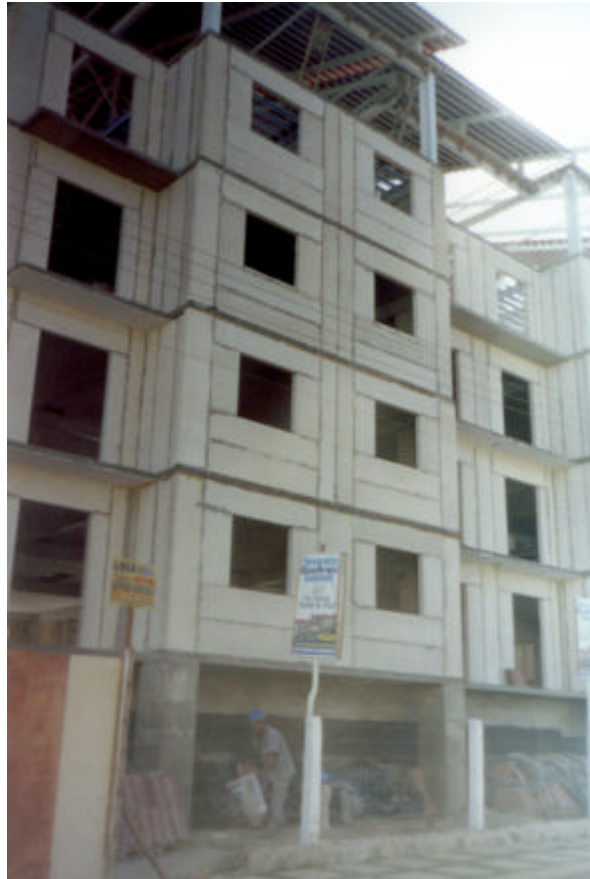
Figura 2.27: Paginação de painéis de concreto celular autoclavado nas paredes de hotel em Caldas Novas – GO. Fonte: Sical Industrial.
