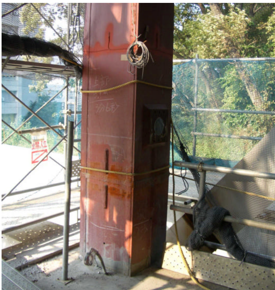
Figura 5.1: Obra em execução em Tóquio, Japão, detalhe do orifício para injeção de concreto pressurizado nos pilares metálicos tubulares. Foto do Autor
