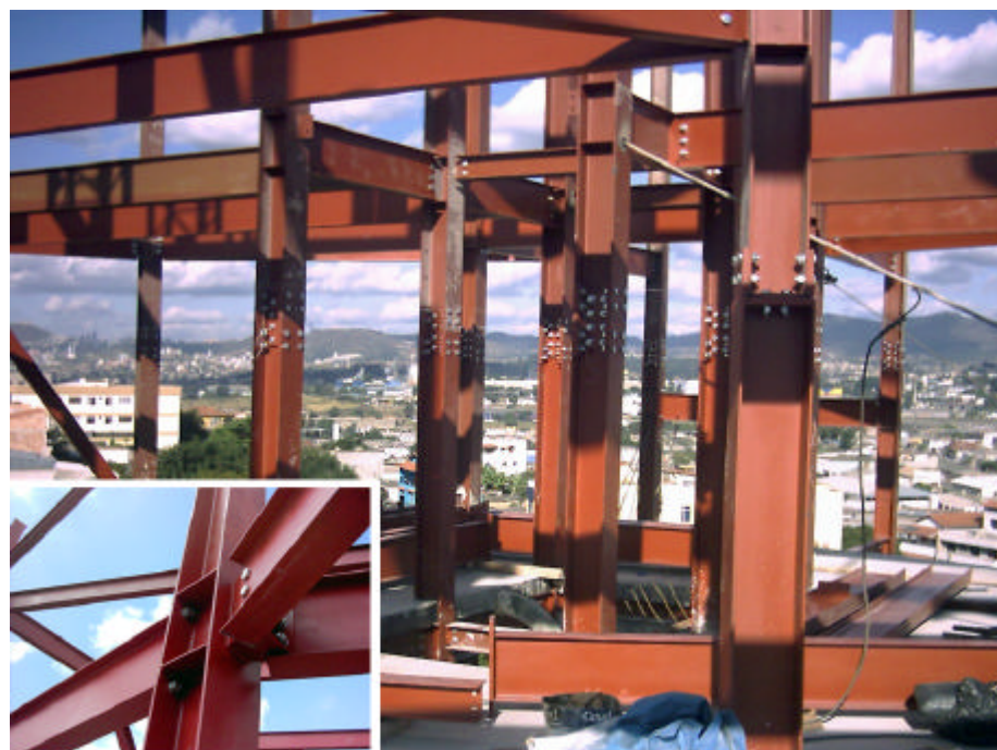
Figura 2.23: Ligações aparafusadas do edifício Bouganville. Fonte: Construtora Castro Pimenta
