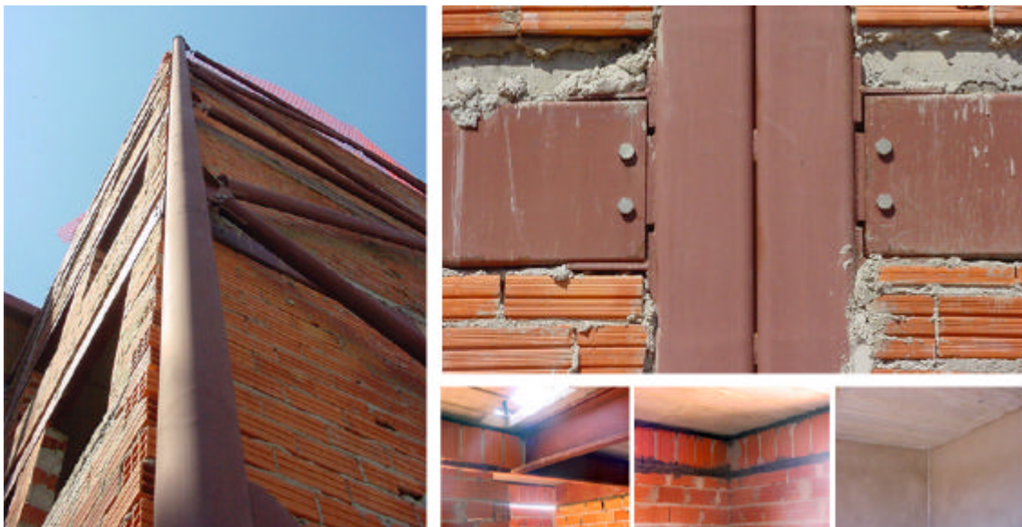
Figura 2.11: Sistema construtivo com recobrimento das alvenarias e estrutura do edifício Alusa / Brastubo (Fonte: Núcleo do Aço: Cosipa)
