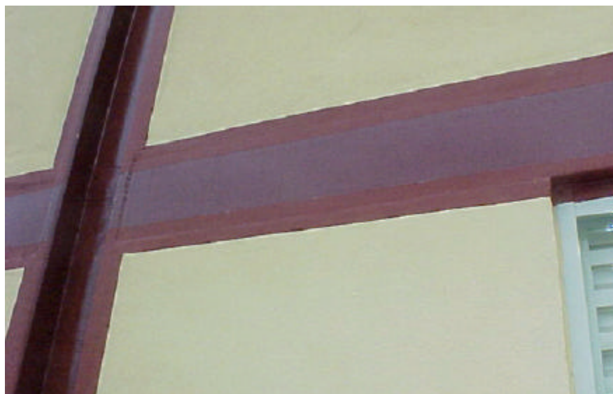
Figura 2.7: Detalhe da pintura elastomérica entre reboco de revestimento das alvenarias e vigas do edifício Múltipla / Alphametal. (Fonte: CGA – Usiminas)
