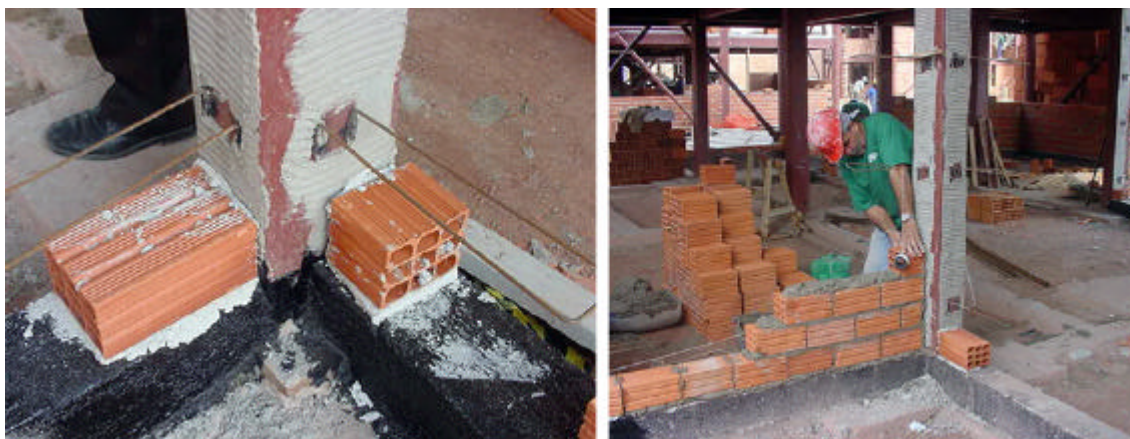
Figura 2.14: Ligações entre as alvenarias de tijolos furados cerâmicos convencionais e a estrutura do edifício Alusa / Brastubo. Fonte: Núcleo do Aço: Cosipa.
