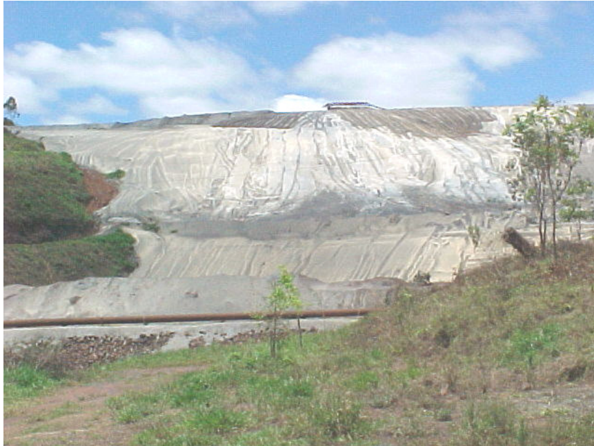
Figura 4.7 – Vista frontal do talude de jusante da Barragem de Campo Grande
