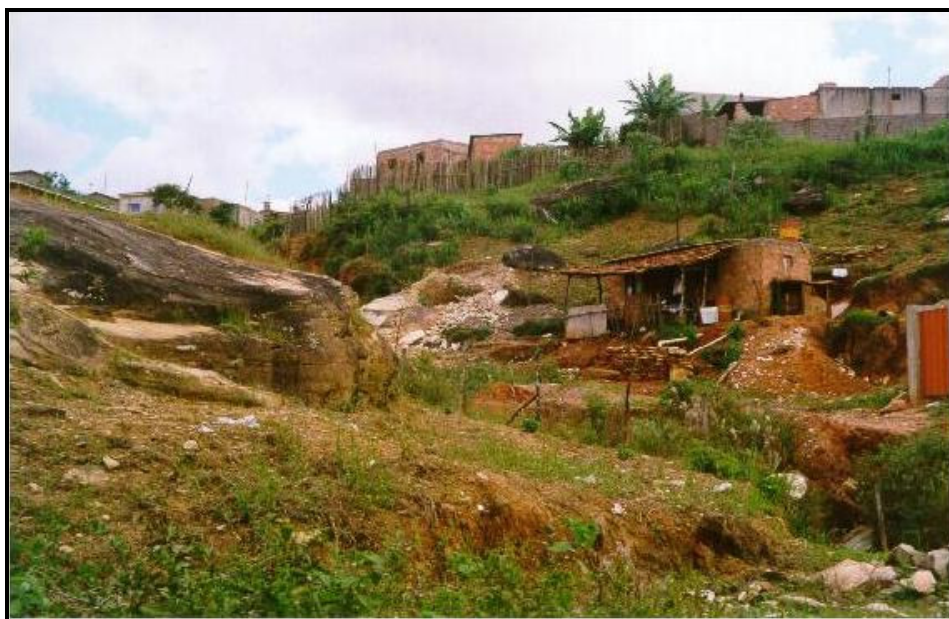
Foto 6.8 – Ocupação do Depósito de Tálus no Bairro Santa Rita de Cássia. Corte e aterro na matriz do depósito e lançamentos de água e esgoto sem infra-estrutura. Fonte: Sobreira – 2000.
