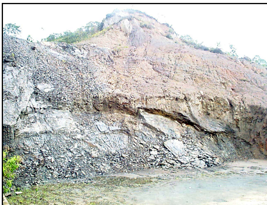
Foto 6.4 – Escorregamento translacional à esquerda da foto, em materiais da Formação Barreiro. Desconfinamento do maciço após execução de corte.
