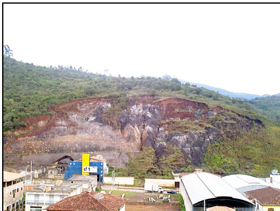
Foto 6.5 – Erosão hídrica e escorregamentos rotacionais em materiais da Formação Barreiro. Degraus de abatimento no contato com os materiais do depósito de cobertura (colúvio). A esquerda da foto é possível identificar uma tentativa de retaludamento da encosta e o aparecimento de novos sulcos e superfícies de escorregamentos.
