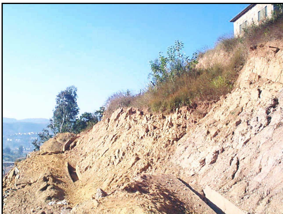
Foto 6.6 – Escorregamento Rotacional em material do Grupo Sabará. Talude no Bairro São Cristóvão as margens da Rodovia MG – 129. Detalhe para o rompimento da canaleta de drenagem.
