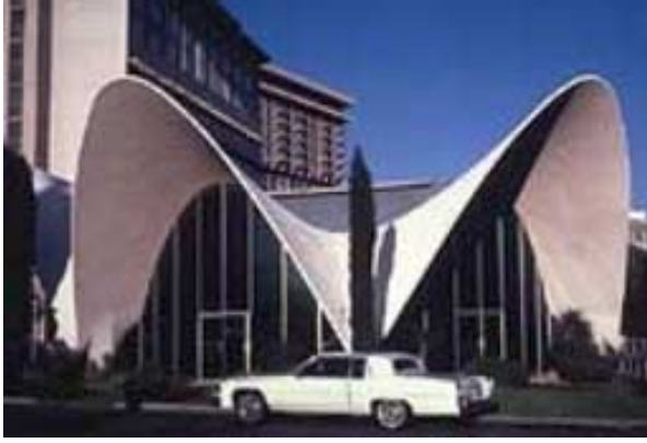
FIGURA 7.19 – Cobertura em HP do hall de entrada de um motel. Las Vegas, Nevada FONTE - Disponível em: < http://nisee.berkeley.edu/thumbnail/6257_3021_0661/IMG0074.jpg >. Acesso em: 20 fev. 2002.
