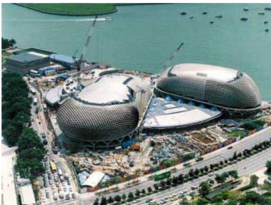
FIGURA 1.2 – Vistas gerais do projeto do grande Domo da Casa de Ópera de Cingapura, uma superestrutura tubular espacial amorfa com dupla curvatura FONTE - Fotos gentilmente cedidas por Charles Walker.
