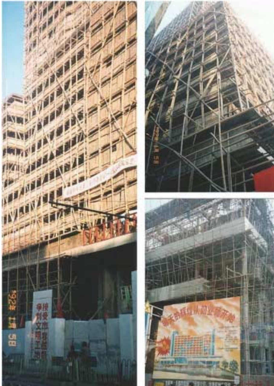
FIGURA 6.8 – Utilização de andaimes de bambu em edificações modernas na China FONTE - Arquivo pessoal.
