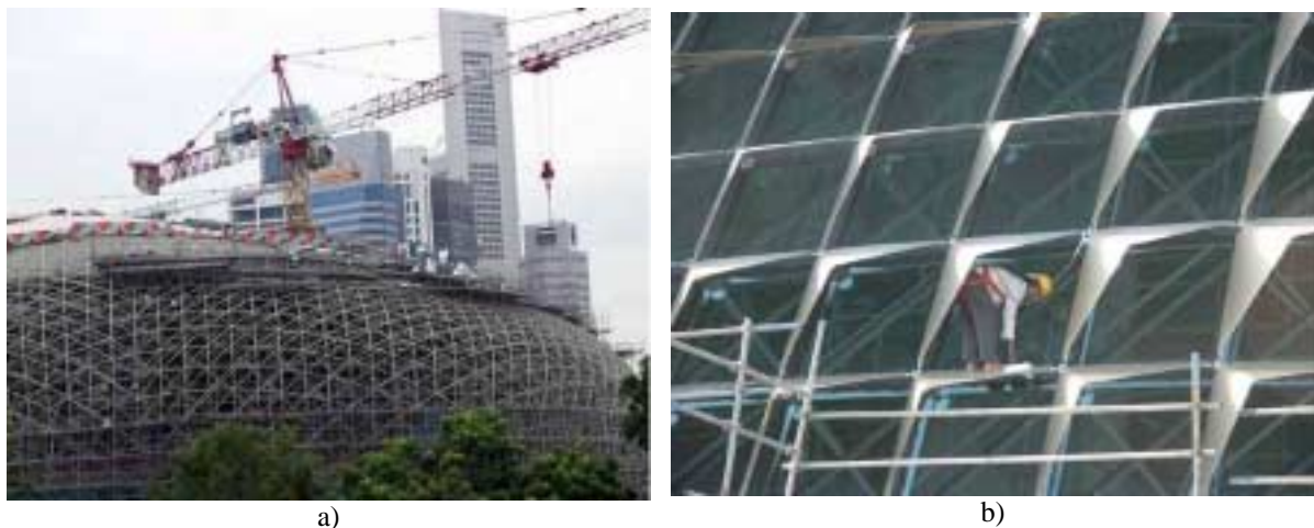
FIGURA 1.1 – Vistas em detalhe do projeto do grande Domo da Casa de Ópera de Cingapura, uma superestrutura tubular espacial amorfa com dupla curvatura FONTE - a) Disponível em: < http://www.vitruvius.com.br/entrevista/walker/walker_03.jpg > Acesso em: 12 abr. 2003; b) foto gentilmente cedida por Charles Walker.
