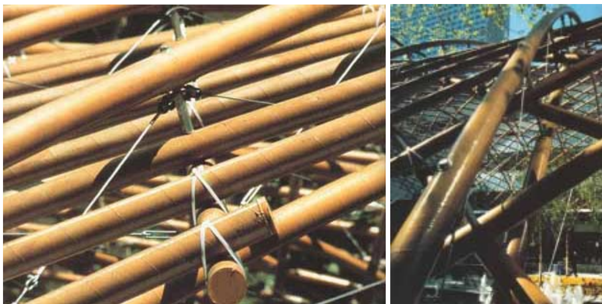
FIGURA 4.6 – Detalhe da estrutura em tubos de papelão montada no Jardim das Esculturas do MoMA em N.Y. em 2000, similar à executada no pavilhão do Japão - Expo de Hanover, 2000 FONTE - AMBASZ, 2001. p.132,128.
