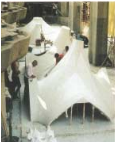
FIGURA 5.37 – Modelo em gesso do capitel dos pilares em escala real FONTE - GÓMEZ, 1996. p.157.
