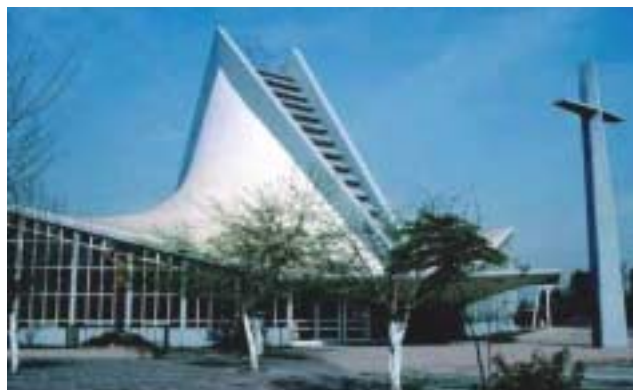
FIGURA 7.13 – F. Candela . Capela de São José Operário em Monterrey, México. 1959-1960 FONTE - Disponível em: < http://www.anc-d.fukui-u.ac.jp/~ishikawa/Aloss/data/Candela/Catalog/Candela_catalog_files/data/catalog1/44.jpg >. Acesso em: 17 dez. 2003.
