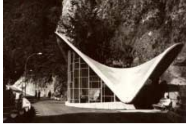
FIGURA 7.20 – Abrigo de chuva. Olanesti, Romênia FONTE - Disponível em: < http://www.structurae.de/photos/mihailescu/olanesti01.jpg >. Acesso em 22 jan. 2002.
