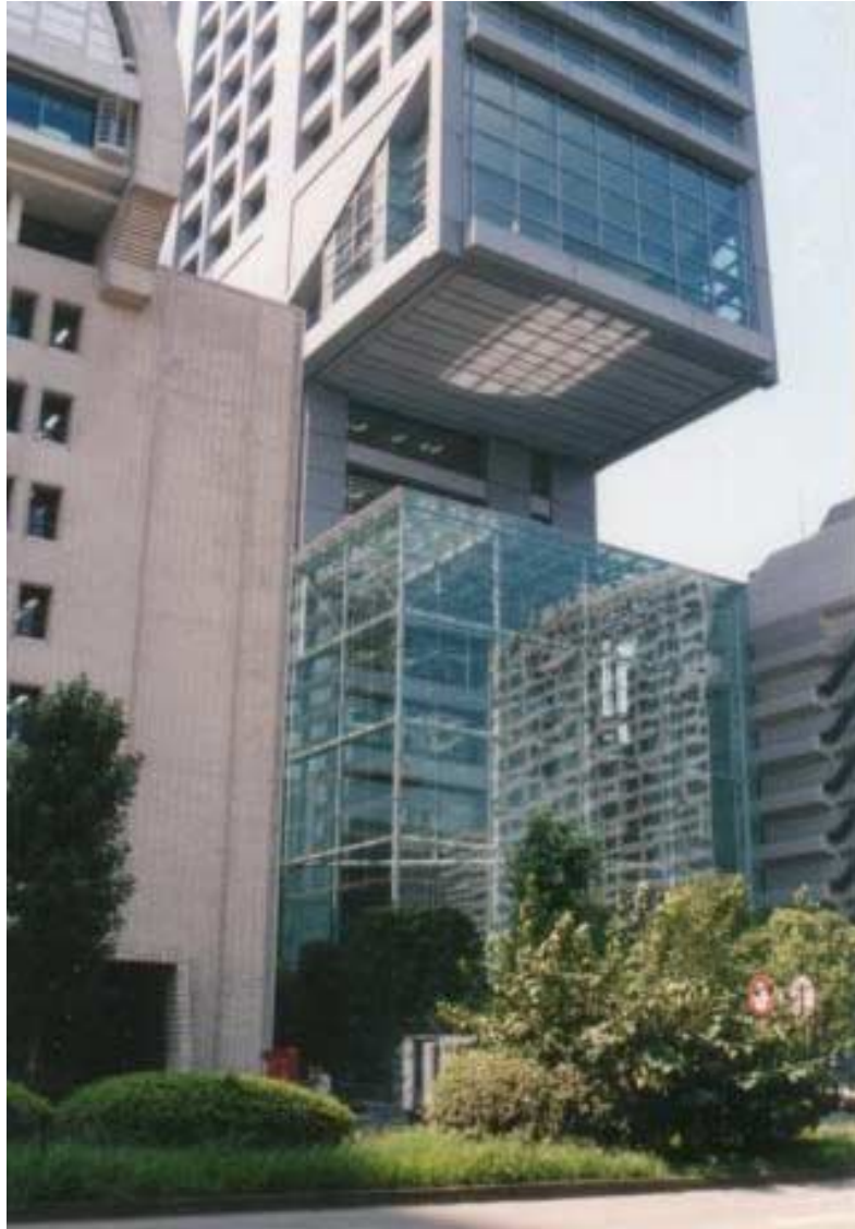
FIGURA 3.18 – Hall de edificação em estrutura tubular de seção circular. Tóquio, Japão FONTE - Arquivo pessoal.
