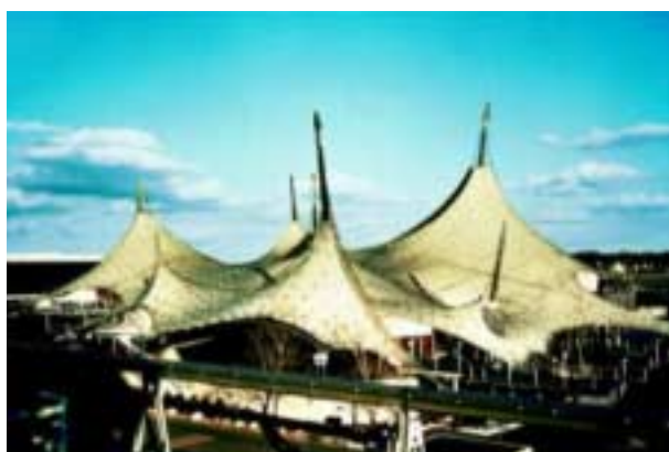
FIGURA 7.14 – F. Otto . Pavilhão da Alemanha na Expo 67 de Montreal. (cobertura em tecido) 1965-1967 FONTE - Disponível em: < http://freiotto.com/FreiOtto/FreiOttoNetzkonstruktionenGross.htm >. Acesso em: 17 dez. 2003.
