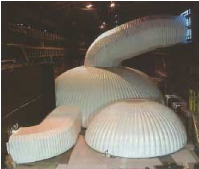
FIGURA 6.30 – Restaurante em estrutura pneumática FONTE - KIMPLIAN, 2002. p.38.
