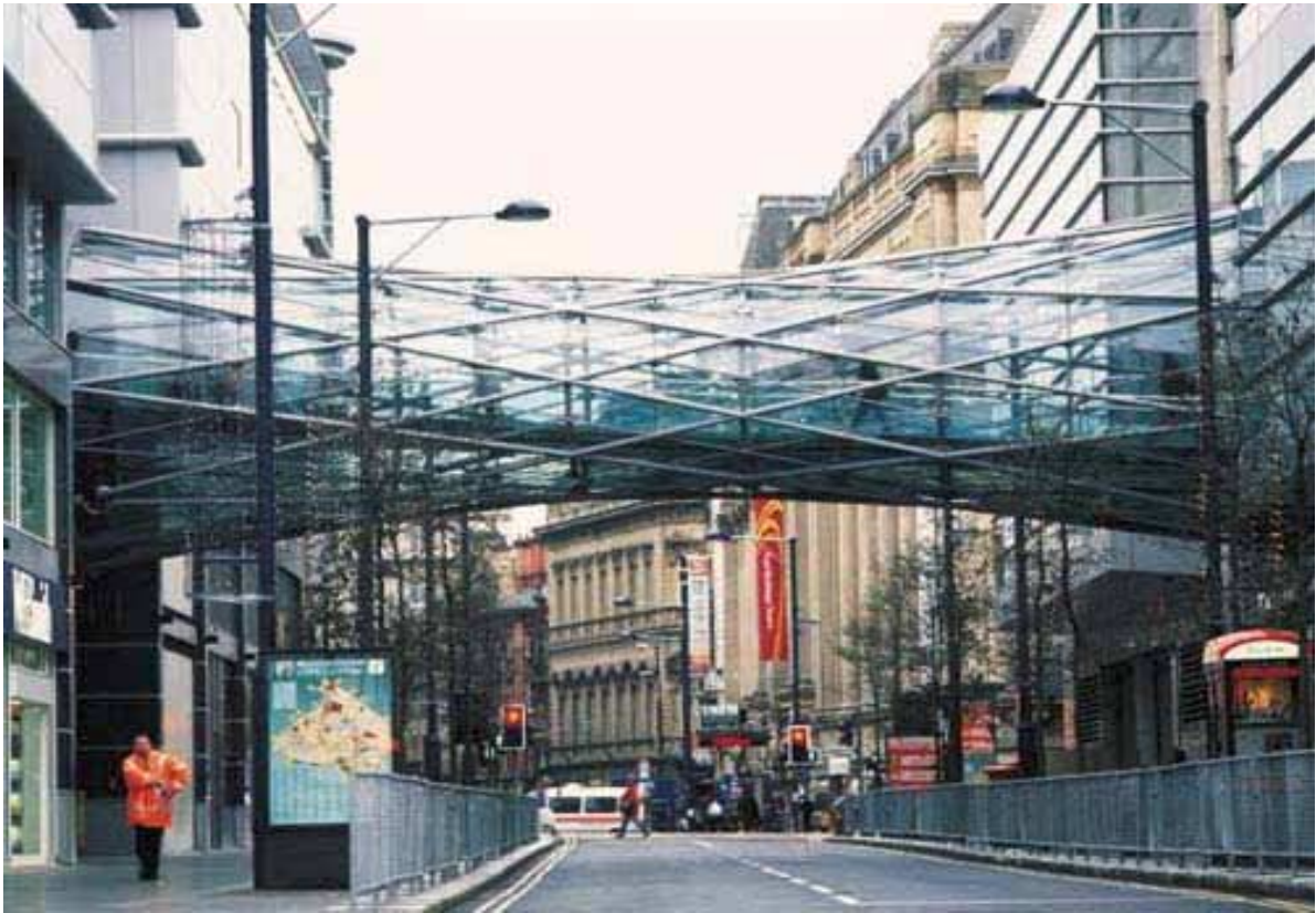
FIGURA 7.30 – Passarela de pedestre em hiperbolóide de revolução FONTE - Disponível em: < http://www.structurae.de/photos/ice/corporation_street01.jpg >. Acesso em: 25 nov. 2003.
