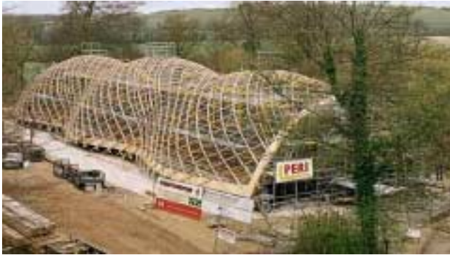
FIGURA 7.24 – Museu em Chinchester, UK, com estrutura de madeira em dupla curvatura FONTE - Disponível em: < http://www.structurae.de/photos/fir1341/peri_scaffolding_weald_2_1g.jpg >. Acesso em: 18 nov. 2003.
