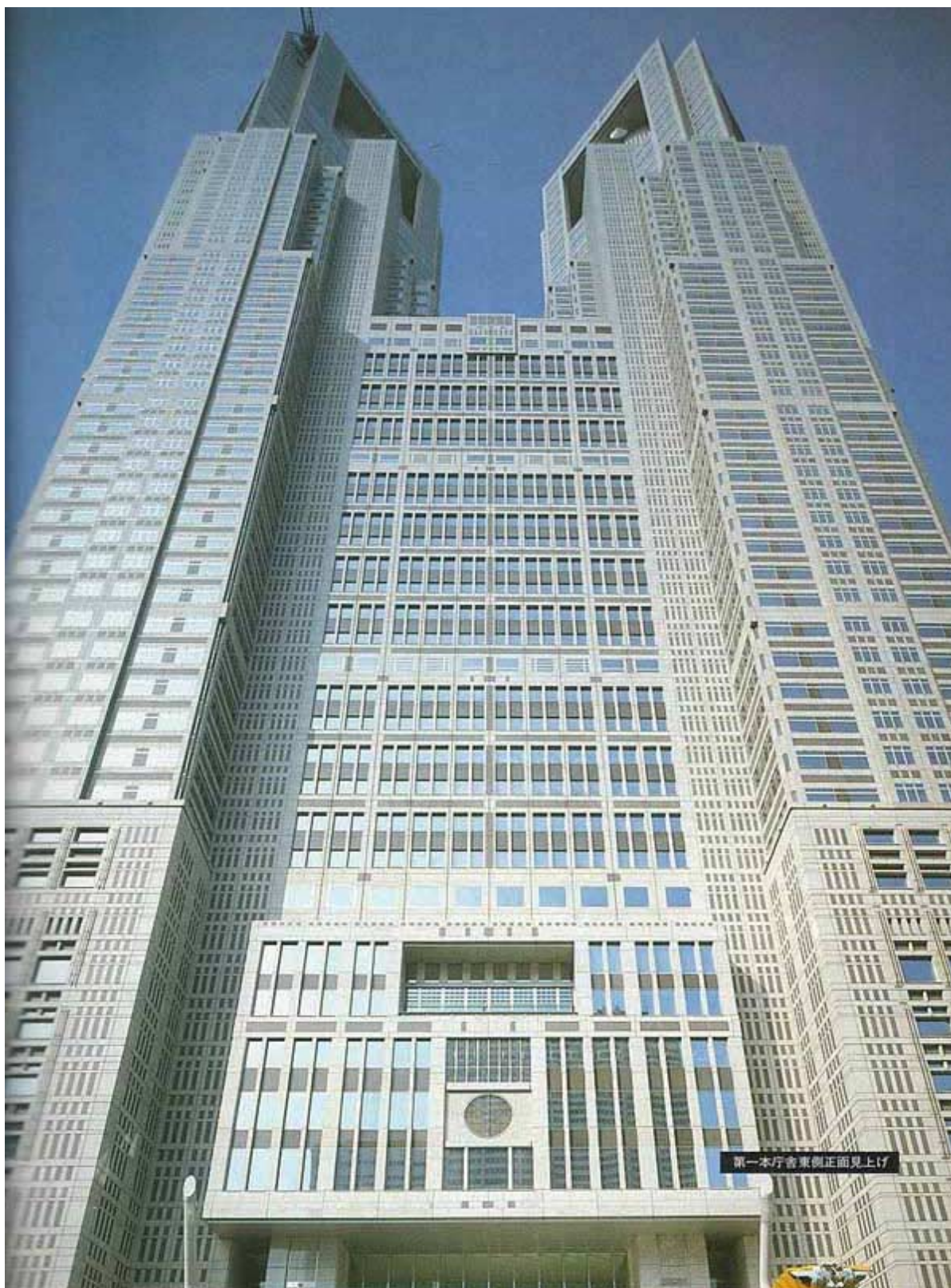
FIGURA 3.10 – Vista parcial térrea da edificação TMG N° 1 Building do complexo da Sede do Governo de Tóquio, Japão FONTE - NIKKEI, 1991.p.9.
