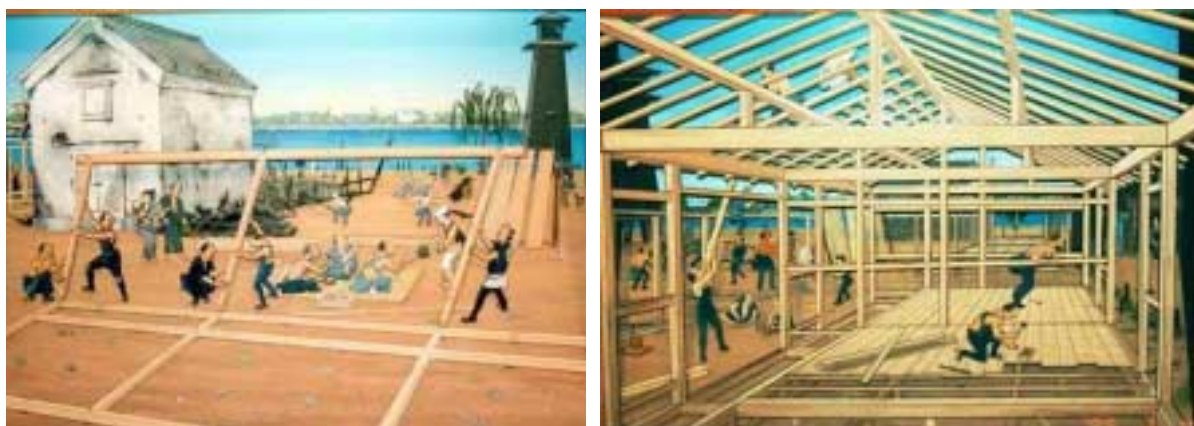
FIGURA 2.1 – A racionalização do sistema construtivo japonês através da padronização de todas as dimensões, despertou a atenção de todo o mundo, pela afinidade com o conceito da industrialização FONTE - Arquivo pessoal. Fotos tiradas no Fukagawa Edo Museum. Tóquio, Japão.
