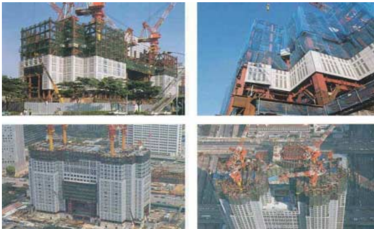
FIGURA 3.9 – Etapas construtivas / Painéis de fechamento FONTE - NIKKEI, 1991.p.103,106.
