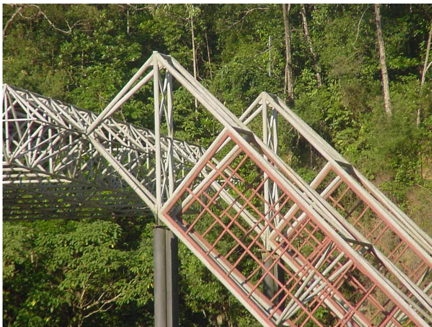
FIGURA 6.19 - Detalhe da ligação das estruturas diagonais com a treliça de cobertura FONTE – Arquivo pessoal, 2002.
