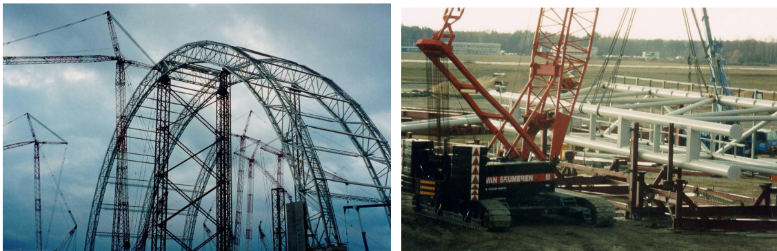
FIGURA 5.53 - Montagem de peças de grande porte do Hangar do Cargo-Lifter – Brandenburg, Alemanha
