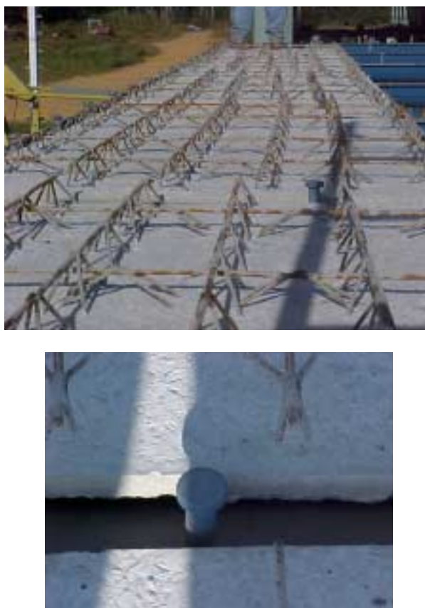
FIGURA 4.35 - Vigas bi-apoiadas com travamento através de elementos de lajes FONTE – Arquivo pessoal, 2003.
