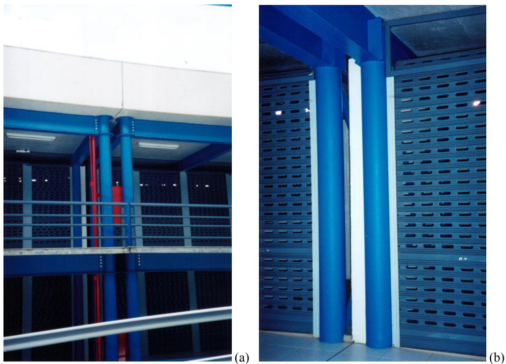
FIGURA 6.92 - Vista das juntas de dilatação: (a) juntas de dilatação nos pavimentos; (b) detalhe de junta de dilatação entre lojas FONTE – Arquivo pessoal, 2002.
