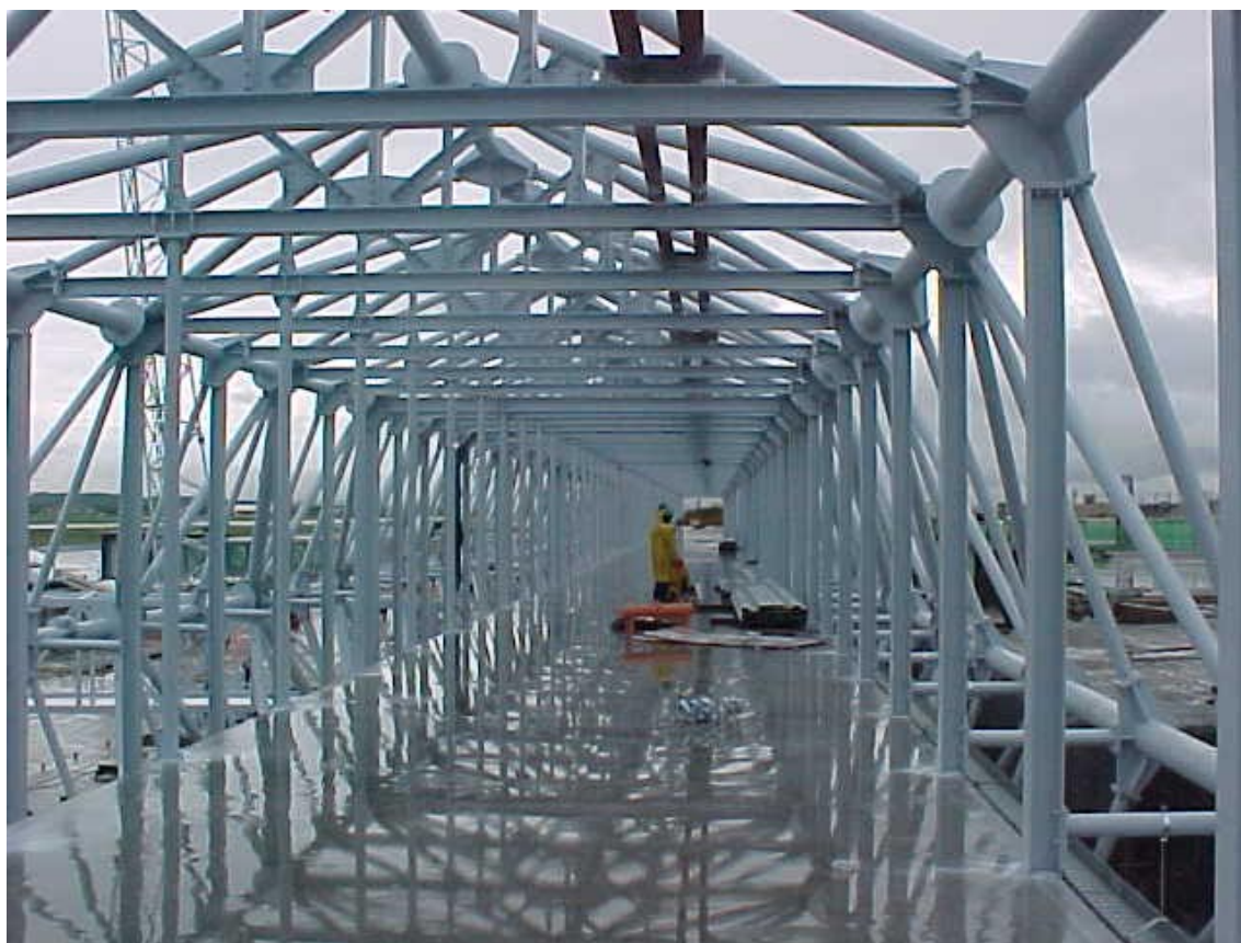
FIGURA 6.107 - Montagem do conector FONTE – ARAÚJO, 2001.
