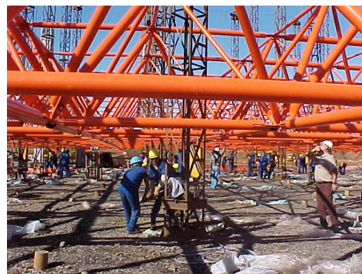
FIGURA 5.51 - Montagem de estrutura espacial acima do solo para posterior içamento FONTE – ARAÚJO, 2001.
