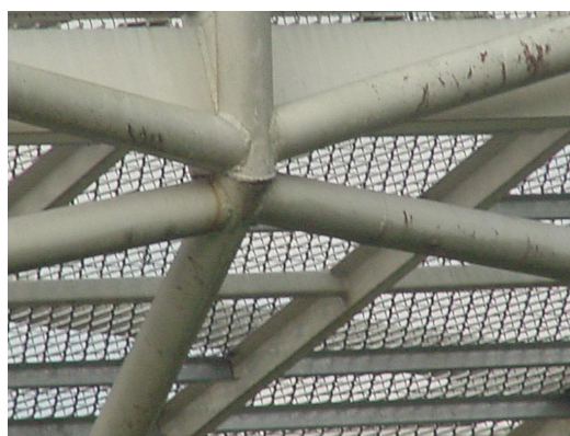
FIGURA 6.37 - Passarela: (a) vista da seção octogonal e malha da passarela; (b) detalhe da soldagem das peças, grelha e tela metálica do tabuleiro FONTE – Arquivo pessoal, 2002.
