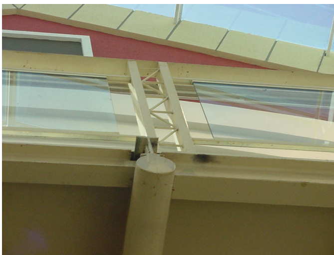
FIGURA 6.40 - Detalhe de perfil tubular como parte de estrutura de sustentação de piso FONTE – Arquivo pessoal, 2002.
