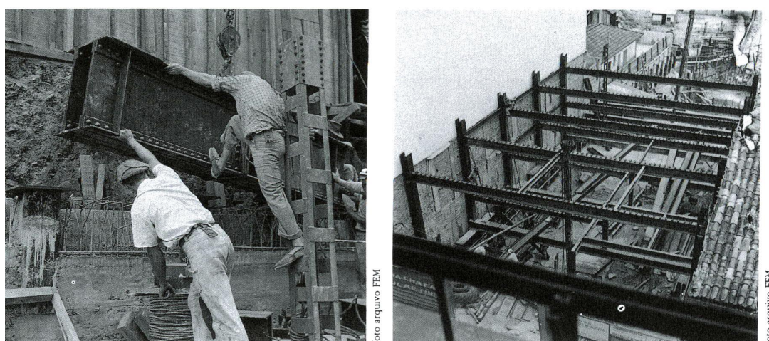
FIGURA 2.98 - Edifício Garagem América: montagem das vigas de transição seção caixão FONTE – Arquivo FEM apud DIAS, 1999.
