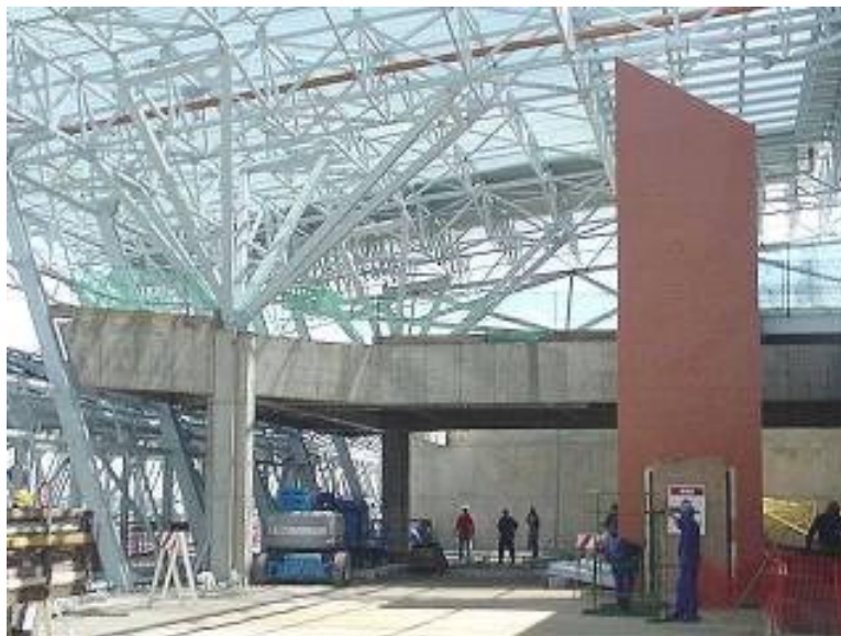
FIGURA 6.104 - Terminal de passageiros: estrutura de cobertura da parte central - “abertura”
