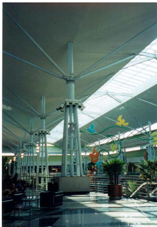
FIGURA 6.9 - Pilar composto: centrais FONTE – Arquivo pessoal, 2002.
