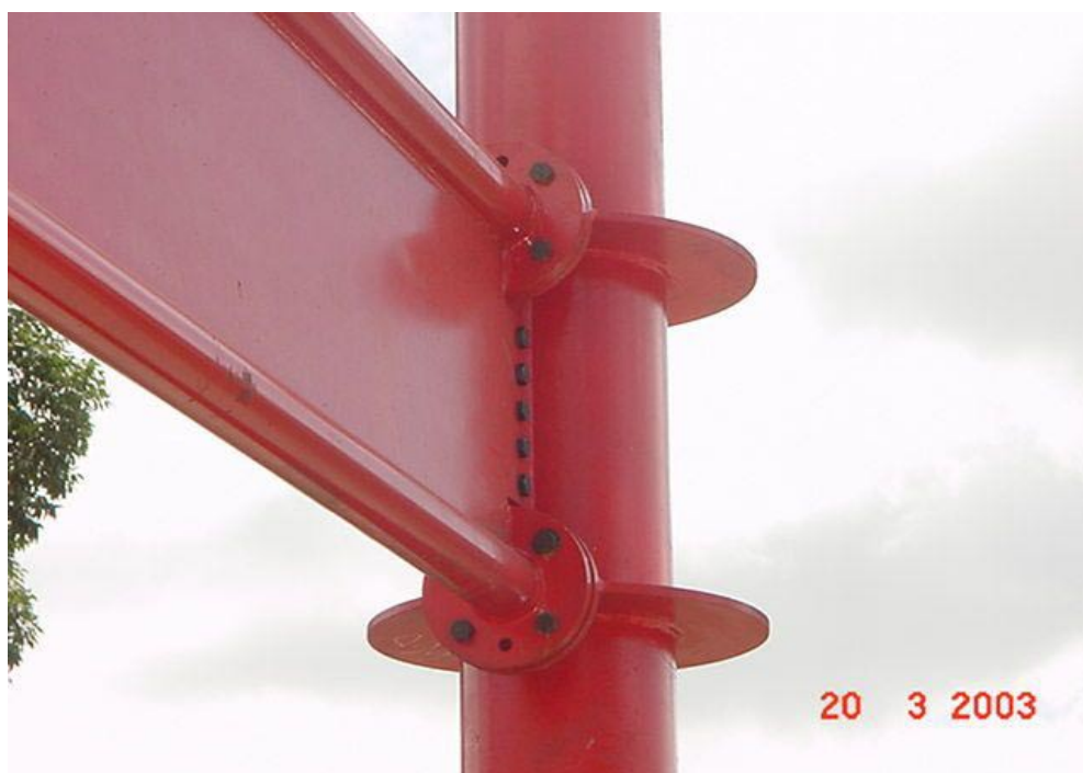
FIGURA 3.26 - Perfis com seções compostas FONTE – Arquivo pessoal, 2003.
