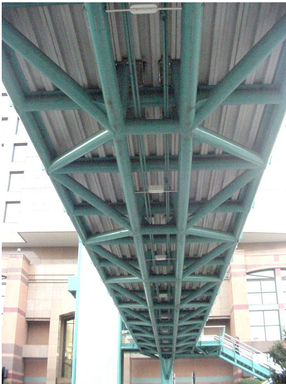
FIGURA 6.75 - Composição estrutural de suporte da passarela e tabuleiro FONTE – Arquivo pessoal, 2003.
