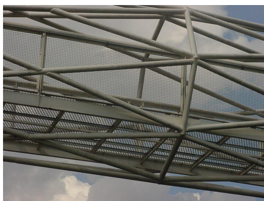
FIGURA 6.37 - Passarela: (a) vista da seção octogonal e malha da passarela; (b) detalhe da soldagem das peças, grelha e tela metálica do tabuleiro FONTE – Arquivo pessoal, 2002.
