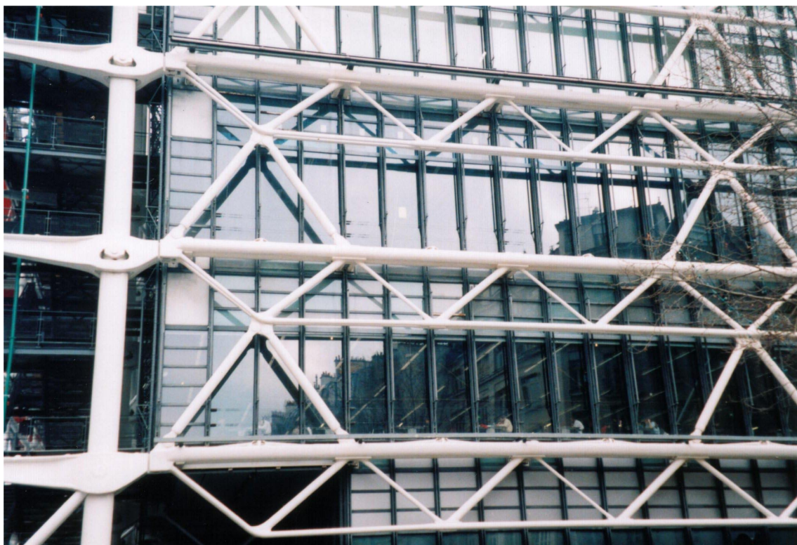
FIGURA 2.33 - Centre Georges Pompidou: detalhe de composição de treliças FONTE – Arquivo pessoal, 2002.
