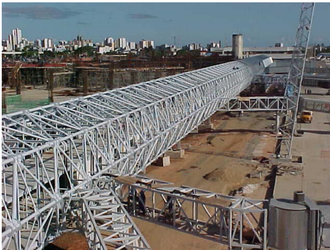
FIGURA 6.106 - Montagem do conector e pontes de embarque FONTE – ARAÚJO, 2001.
