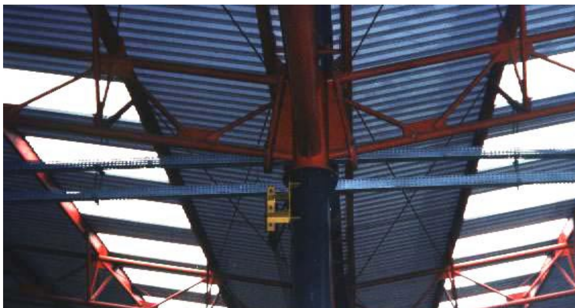
FIGURA 6.62 - Galpão: cobertura - detalhe da iluminação zenital (vários pontos) com telhas translúcidas FONTE – Arquivo pessoal, 2002.
