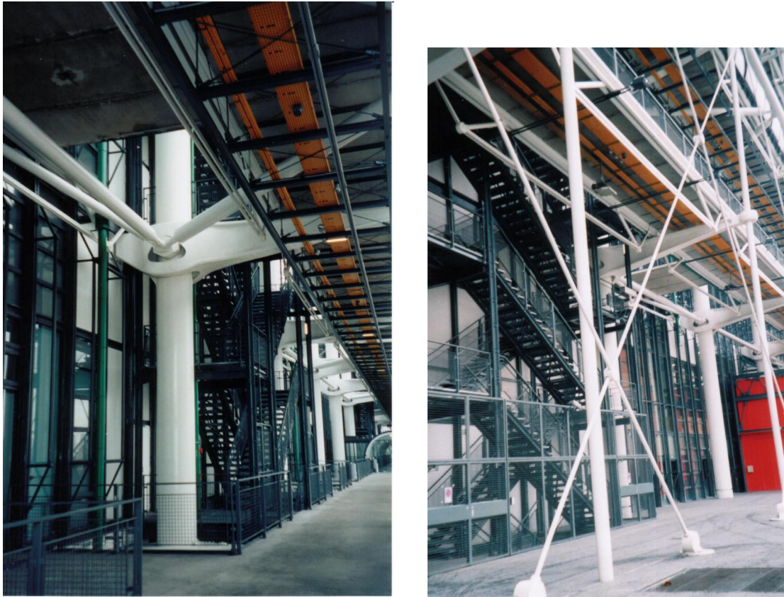
FIGURA 2.34 - Centre Georges Pompidou: detalhes estruturais – pilares e contraventamentos FONTE – Arquivo pessoal, 2002.
