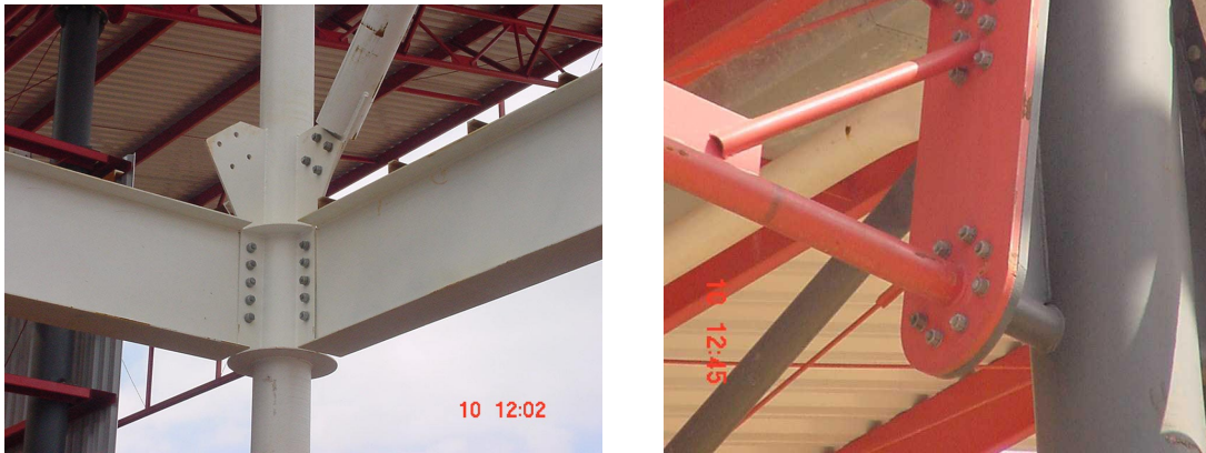
FIGURA 5.34 - Ligações com utilização de parafusos do tipo ASTM A307, A325 ou A490 FONTE – ARAÚJO, 2001.
