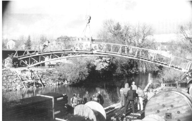
FIGURA 5.49 - Montagem de uma ponte treliçada em arco FONTE – CIDECT, 1998.
