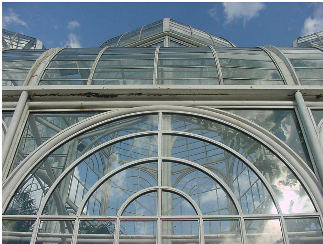
FIGURA 6.22 - Detalhe da ligação de tubos e vidro e/ou policarbonato FONTE – Arquivo pessoal, 2002.
