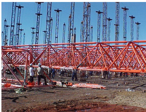
FIGURA 5.51 - Montagem de estrutura espacial acima do solo para posterior içamento FONTE – ARAÚJO, 2001.
