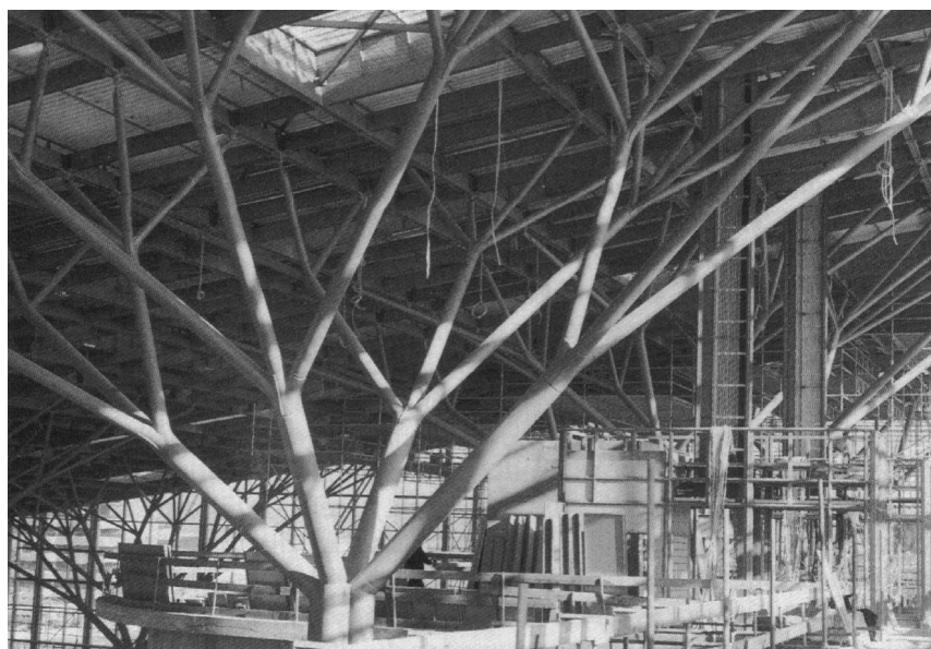
FIGURA 3.37 - Aeroporto de Stuttgart: detalhe dos pilares “árvores” FONTE – RÜTER, 1997.
