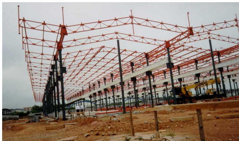
FIGURA 5.47 - Montagem de estrutura plana com auxílio de guindastes FONTE – ARAÚJO, 2001.
