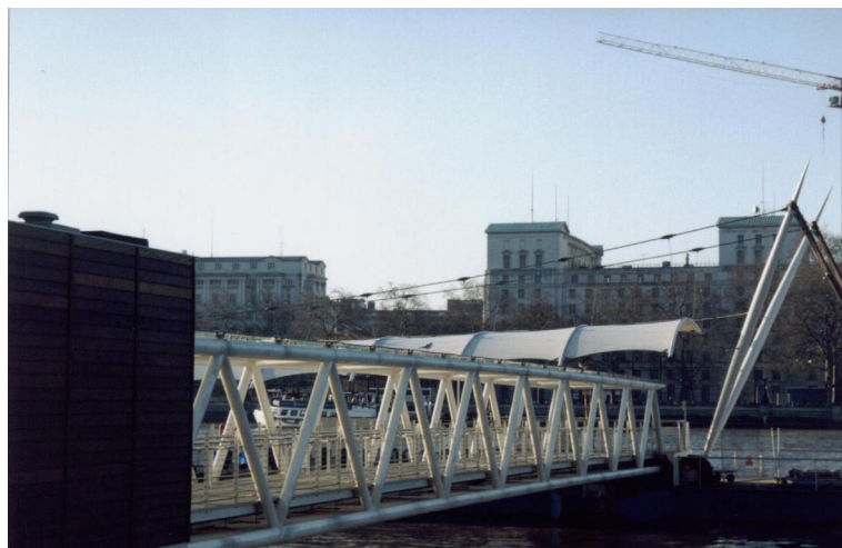
FIGURA 3.25 - Passarela em viga treliçada FONTE – Arquivo pessoal, 2002.
