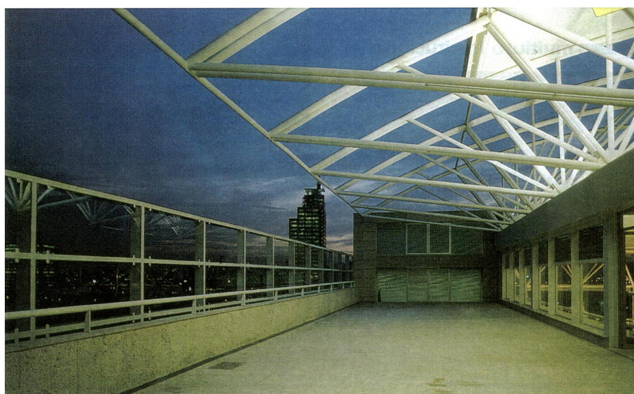
FIGURA 6.71 - Terraço aberto ao lado do restaurante (último piso): treliça curva de cobertura, com fechamento retrátil FONTE – REVISTA AU, 2000.
