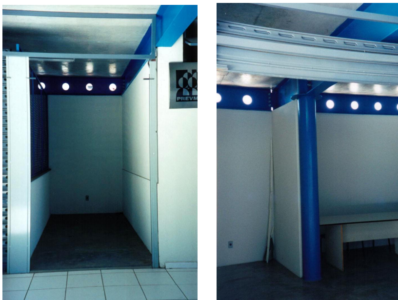
FIGURA 6.88 - Vista interior das lojas: vigas vazadas para exaustão FONTE – Arquivo pessoal, 2002.
