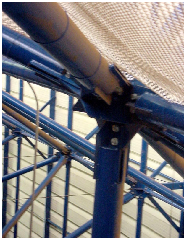
FIGURA 6.4 - Detalhes dos nós de ligação das treliças FONTE – Arquivo pessoal, 2002.
