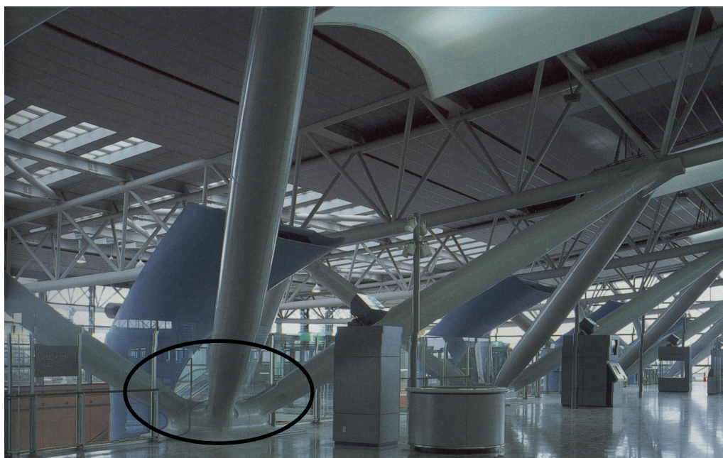
FIGURA 2.40 - Aeroporto de Kansai: detalhe da placa de base do pilar FONTE – KANSAI INTERNATIONAL AIRPORT, 1994.
