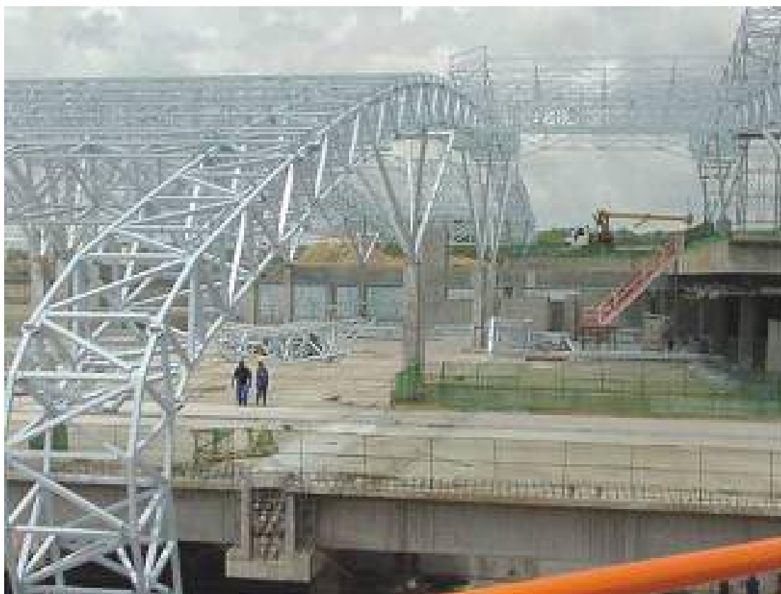
FIGURA 6.101 - Terminal de passageiros: estrutura em arco “achatado”
