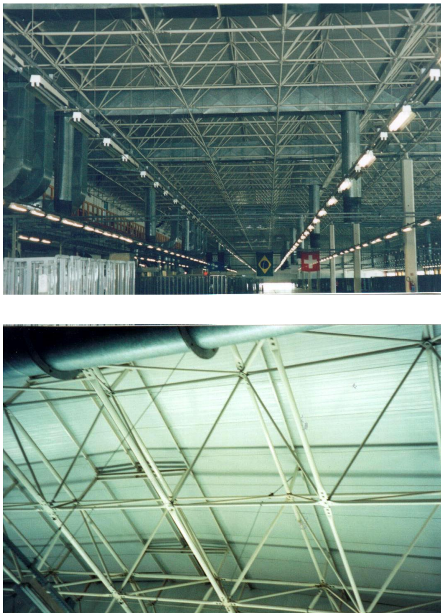
FIGURA 6.125 - Estrutura interna em treliças espaciais FONTE – Arquivo pessoal, 2002.
