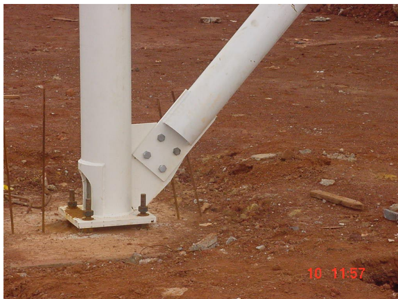
FIGURA 4.11- Ligação de tubos usando chapa de ligação FONTE – Arquivo pessoal, 2002.
