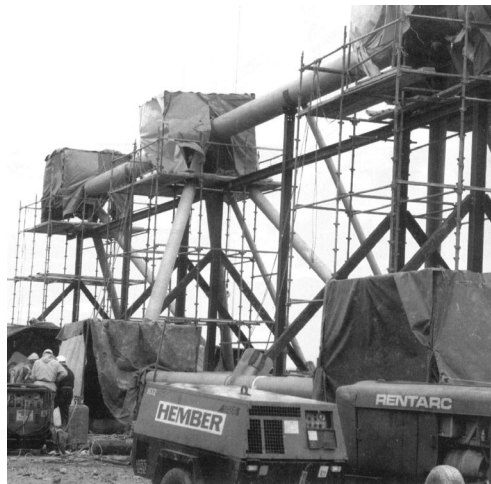
FIGURA 5.45 - Soldagem no canteiro com a utilização de proteção contra intempéries FONTE – CIDECT, 1998.
