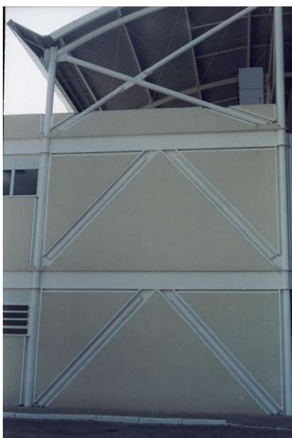
FIGURA 6.57 - Contraventamentos em “K”, em “X” e vigas tipo “I” FONTE – AÇOTUBO, 2003.
