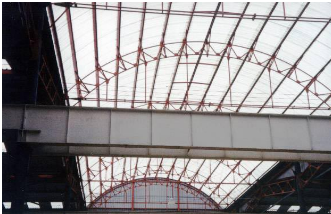
FIGURA 6.61 - Galpão: detalhe da cobertura - parte curva elevada translúcida FONTE – Arquivo pessoal, 2002.
