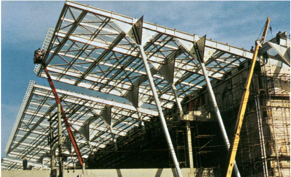
FIGURA 6.122 - Vista da montagem da estrutura FONTE – CATÁLOGO BRAFER, s/d.
