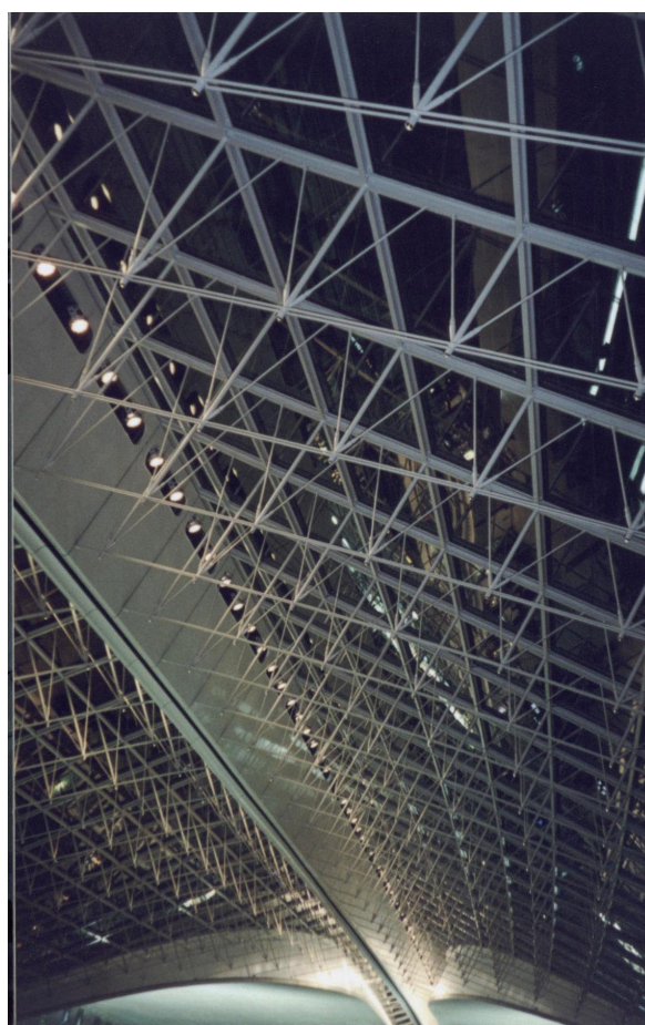
FIGURA 3.22 - Cobertura com sistema estrutural em treliça espacial FONTE – Arquivo pessoal, 2002.
