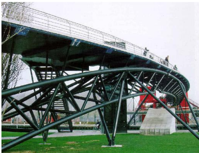
FIGURA 3.21 - Passarela com sistema estrutural em treliça espacial FONTE – WARDENIER, 2000.
