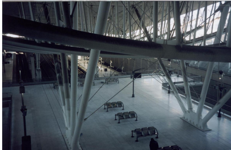
FIGURA 3.24 - Sistema estrutural em perfis tubulares em leque e cobertura em treliça com banzos arqueados FONTE – Arquivo pessoal, 2002.
