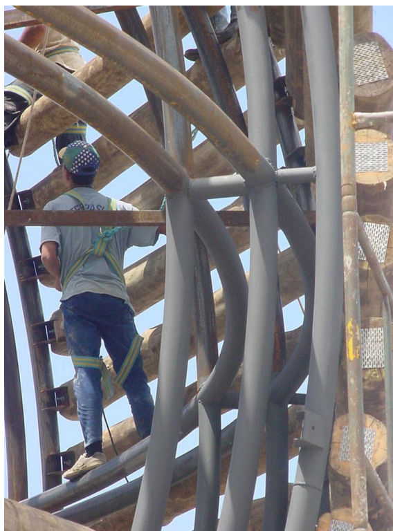
FIGURA 6.45 - Esfera: detalhe da estrutura em perfis tubulares e toras de madeira (revestimento – fechamento) FONTE – Arquivo pessoal, 2002.
