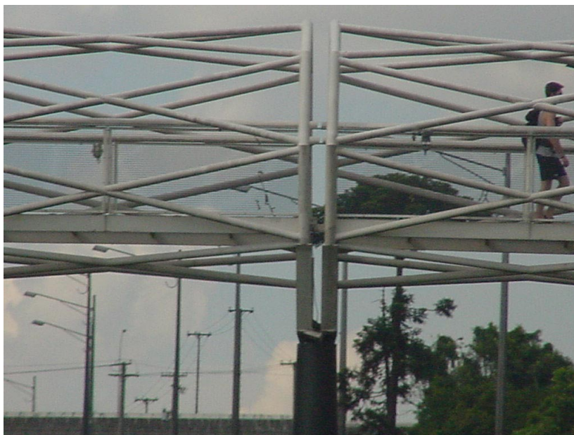
FIGURA 6.36 - Malha da passarela e detalhe da junta de dilatação FONTE – Arquivo pessoal, 2002.
