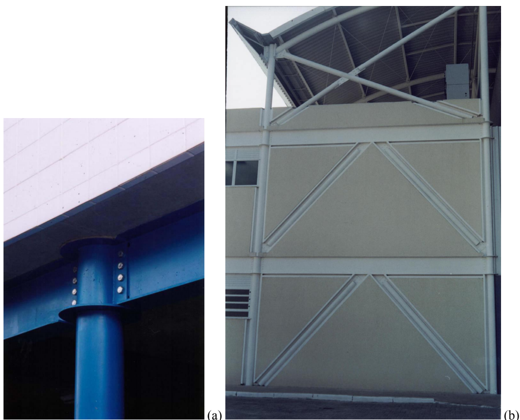
FIGURA 3.12 - Perfis tubulares submetidos a compressão: (a) pilar; (b) barra de contraventamento em “K”
