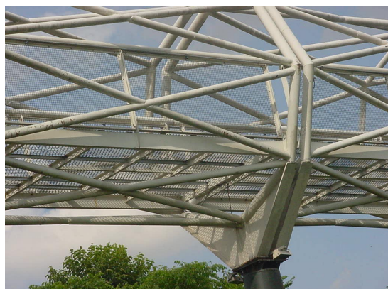
FIGURA 6.38 - Passarela: detalhes das juntas de dilatação e pilar de apoio FONTE – Arquivo pessoal, 2002.
