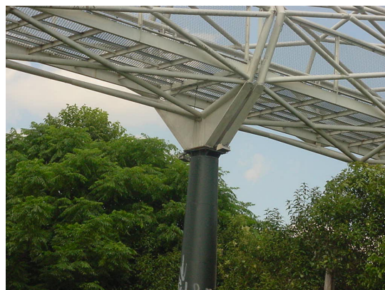
FIGURA 6.38 - Passarela: detalhes das juntas de dilatação e pilar de apoio FONTE – Arquivo pessoal, 2002.
