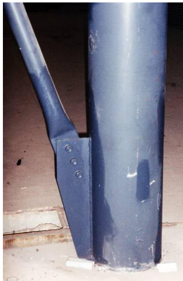
FIGURA 4.10 - Ligação de tubos com ponta amassada FONTE – Arquivo pessoal, 2002.
