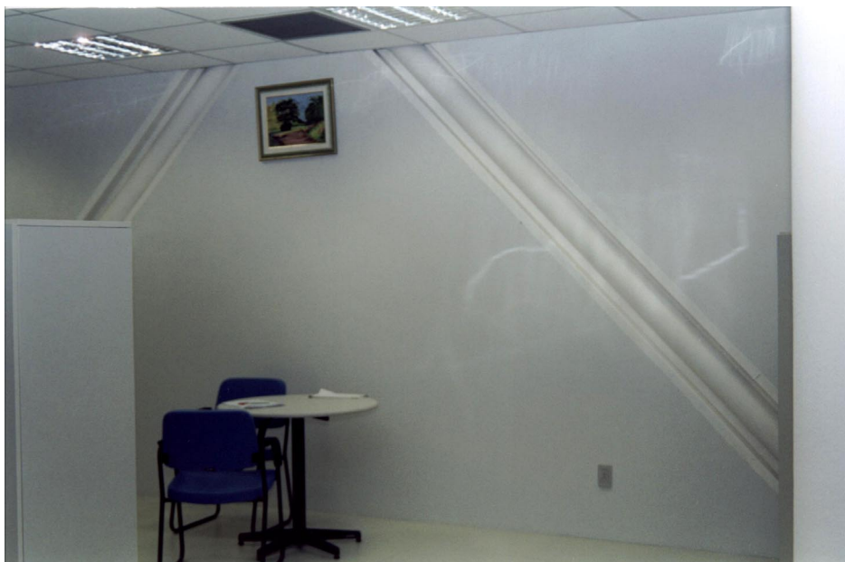
FIGURA 6.58 - Vista interna do Edifício Sede: detalhe dos contraventamentos FONTE – AÇOTUBO, 2003.
