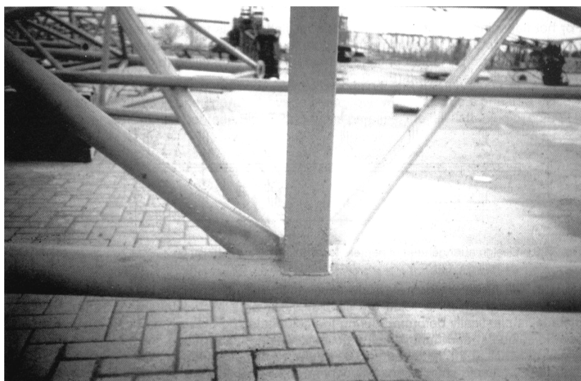
FIGURA 5.18 - Ligação soldada com as extremidades das diagonais amassadas FONTE – CIDECT, 1998.
