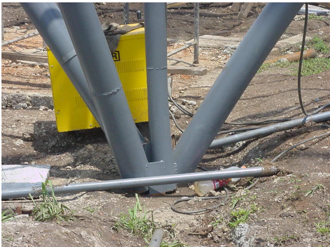
FIGURA 6.48 - Estufa: detalhes de ligações entre os perfis tubulares FONTE – Arquivo pessoal, 2002.
