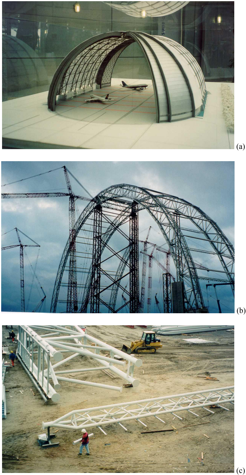
FIGURA 3.50 - Hangar Cargo Lifter. Associação de perfis tubulares em tenso-estruturas: (a) maquete; (b) montagem da estrutura principal; (c) vista de vigas treliçadas no solo FONTE – ARAÚJO, 2000.
