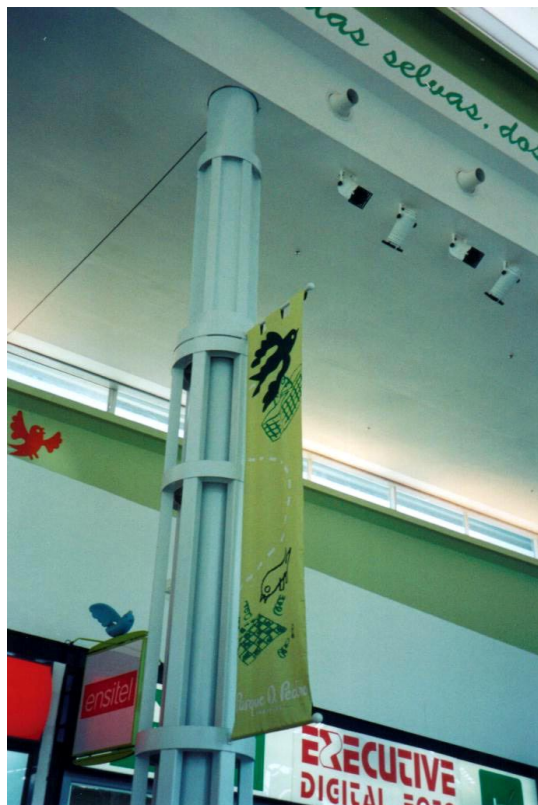
FIGURA 6.8 - Pilar composto: periféricos FONTE – Arquivo pessoal, 2002.
