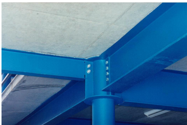
FIGURA 6.94 - Detalhe de pilar com anel de encaixe e vigas em “I” aparafusadas FONTE – Arquivo pessoal, 2002.
