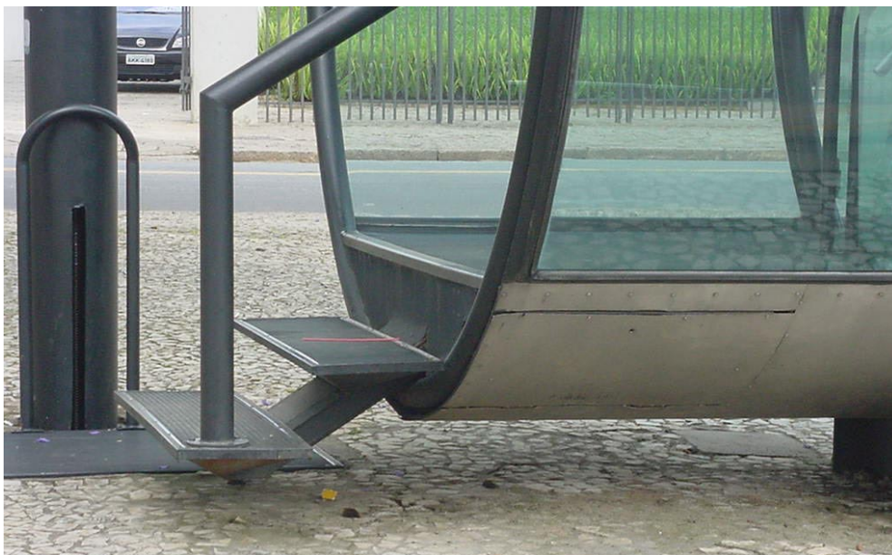
FIGURA 6.26 - Detalhe do piso elevado nas plataformas de embarque e desembarque FONTE – Arquivo pessoal, 2002.
