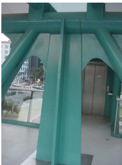
FIGURA 6.74 - Detalhe da composição de pilares estruturais internos FONTE – Arquivo pessoal, 2003.
