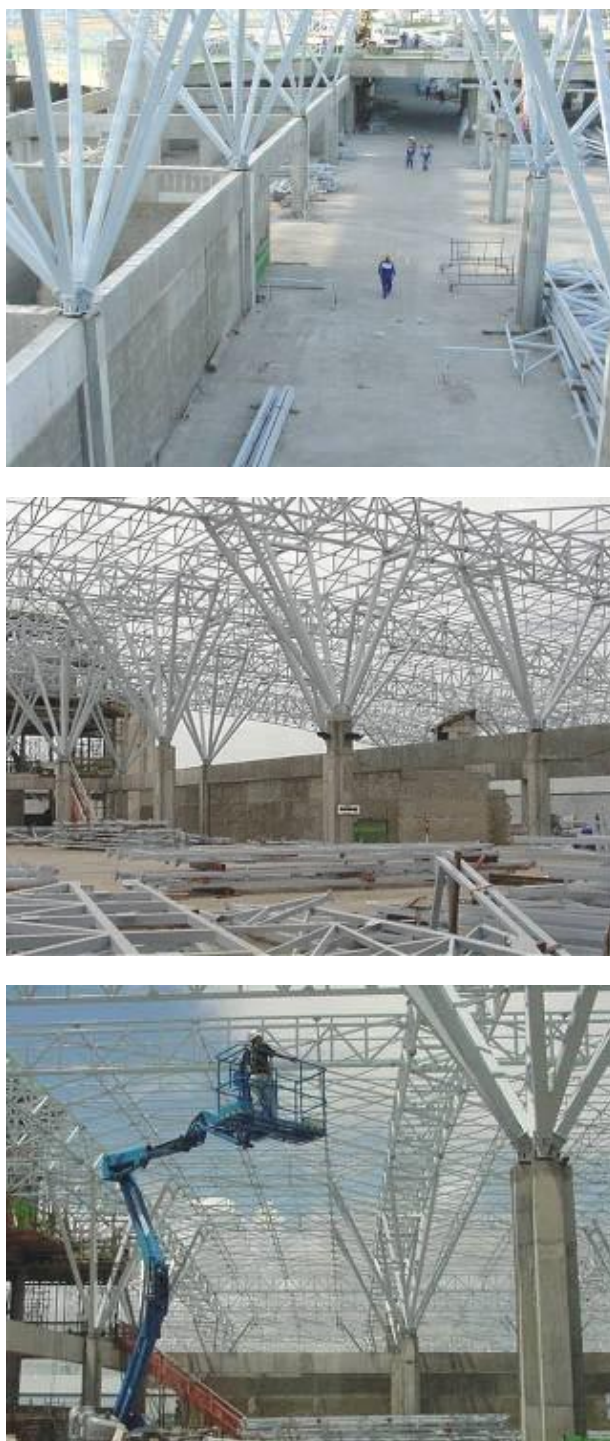
FIGURA 6.102 - Terminal de passageiros: pilares e estrutura de cobertura
