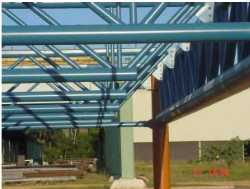
FIGURA 4.36 - Contenção por meio de vigas transversais FONTE – Arquivo pessoal, 2003.
