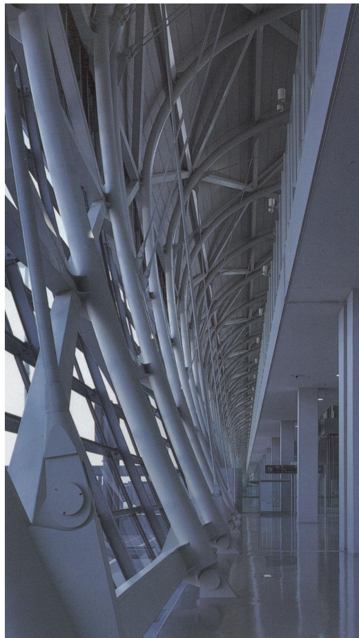
FIGURA 2.38 - Aeroporto de Kansai: detalhe do sistema estrutural de fechamento vertical (laterais) FONTE – KANSAI INTERNATIONAL AIRPORT, 1994.
