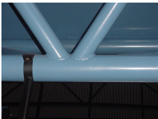
FIGURA 6.32 - Detalhes dos diversos tubos usados na composição da cobertura FONTE – Arquivo pessoal, 2002.
