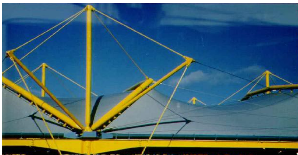
FIGURA 3.52 - Aplicação de perfis tubulares em tenso-estruturas FONTE – WARDENIER, 2000.
