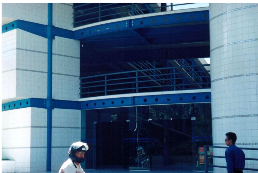
FIGURA 6.93 - Entrada principal: detalhe das vigas calandradas com recorte na alma FONTE – Arquivo pessoal, 2002.
