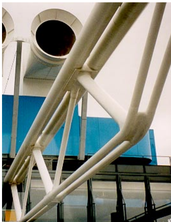
FIGURA 3.39 - Centre Georges Pompidou – Paris, França: viga treliçada FONTE – Arquivo pessoal, 1997.
