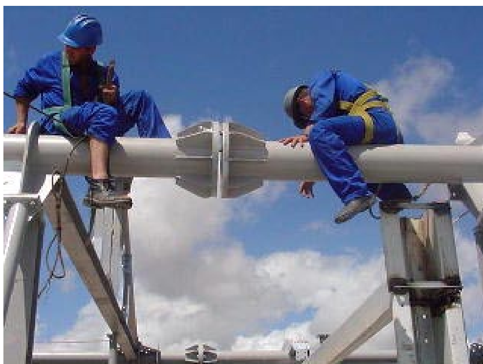
FIGURA 6.109 - Detalhe da ligação de perfis tubulares do conector
