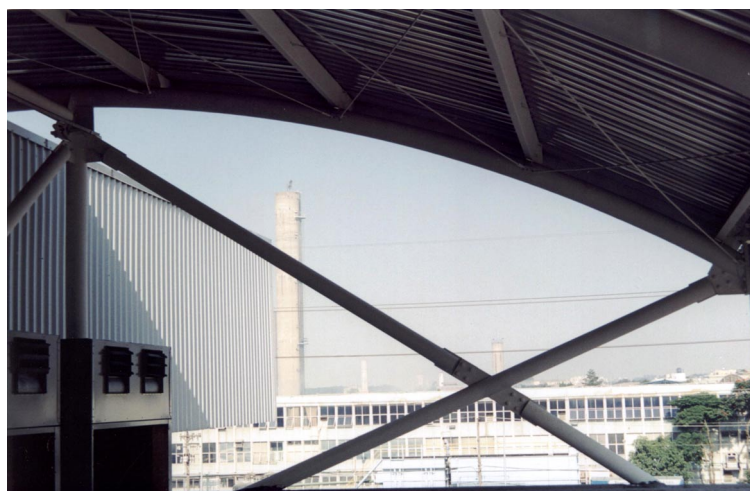
FIGURA 6.65 - Detalhe de contraventamento em “X” e elemento de cobertura curvo FONTE – AÇOTUBO, 2003.
