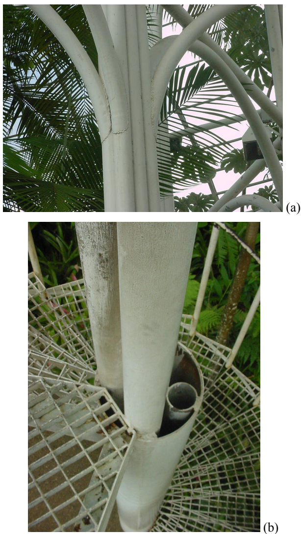
FIGURA 6.24 - Detalhe de pilares: (a) composição de pilar; (b) composição do pilar de suporte da escada
