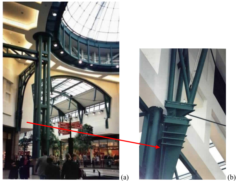
FIGURA 3.40 - Shopping Center Neue Mitte Oberhausen – Oberhausen, Alemanha. Composição de pilar: (a) mão francesa associada ao pilar principal; (b) detalhe do arremate do pilar FONTE – ARAÚJO, 2000.
