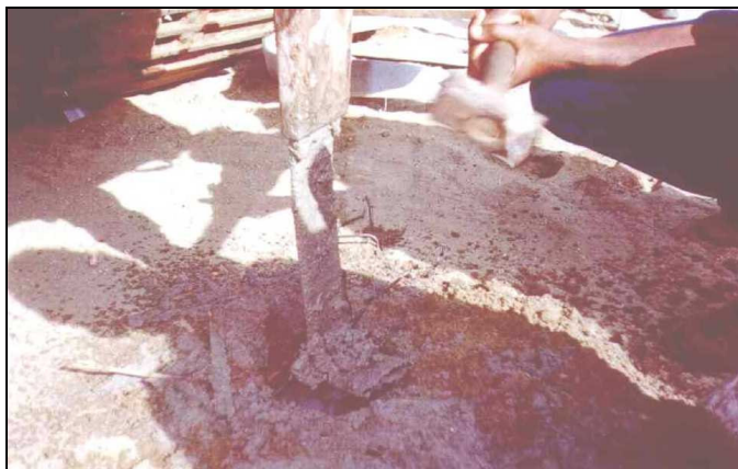
Foto 7 – Detalhe da perda de ancoragem do dreno no terreno subjacente
