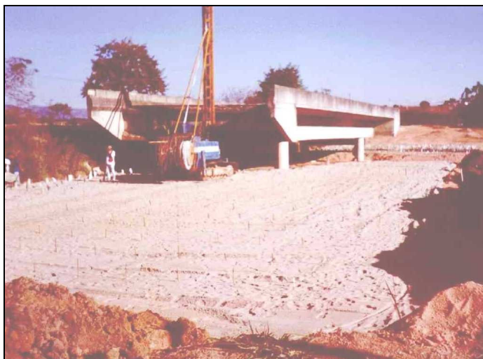
Foto 5 – Área de cravação dos drenos verticais sintéticos (lado BH).
