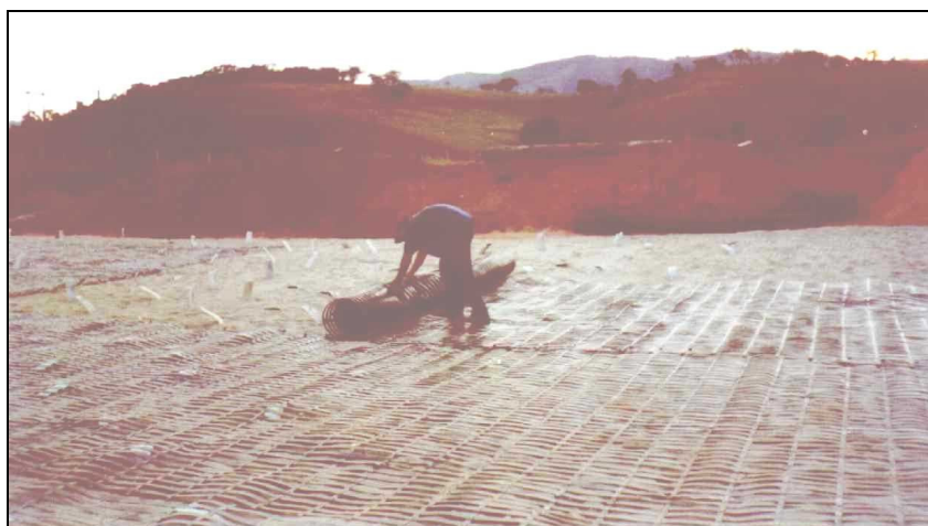
Foto 8 – Colocação da primeira camada de geogrelha sobre o colchão drenante
