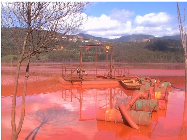
Figura 3.13: Sistema de bombeamento da lama
