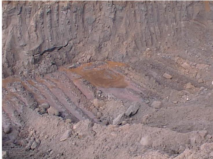
Figura 3.10: Escavação atingindo a camada de lama
