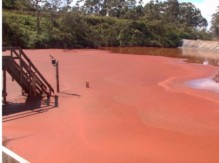
Figura 3.15: Drenagem da lâmina d'água
