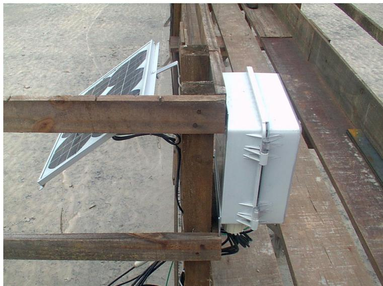
Figura 3.28: Painel solar e a caixa protetora
