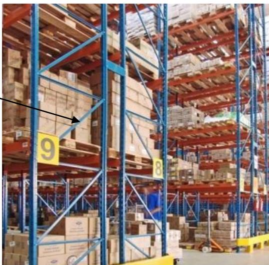
FIGURA 2.13 - Contraventamentos laterais do sistema *porta-pallets* (ÁGUIA, 2011).
