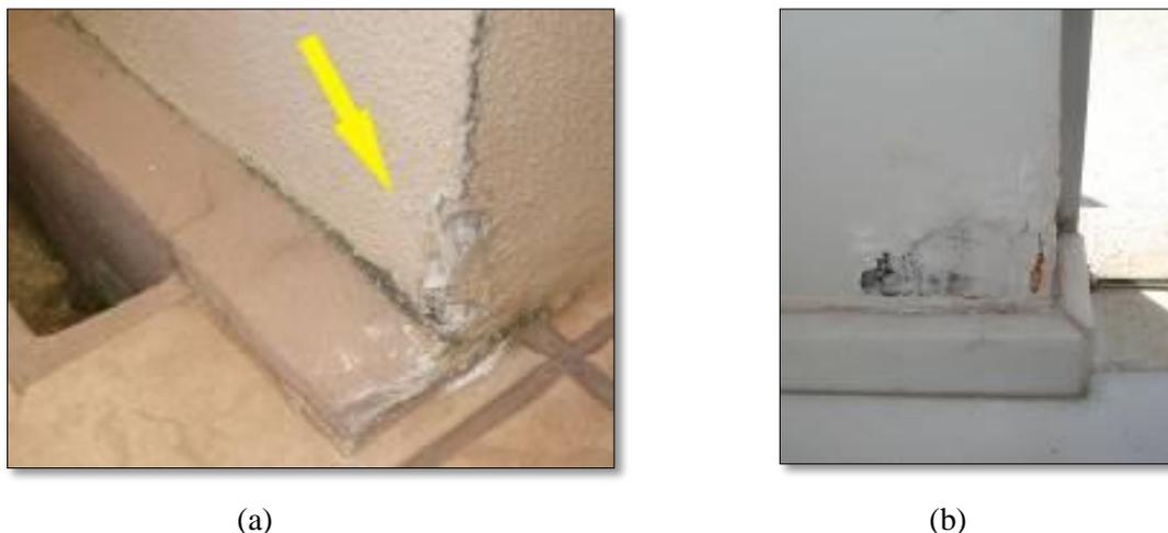
**Figura 4.7** – (a) Sem proteção do rodapé/ (b) Rodapé de pequena altura.
