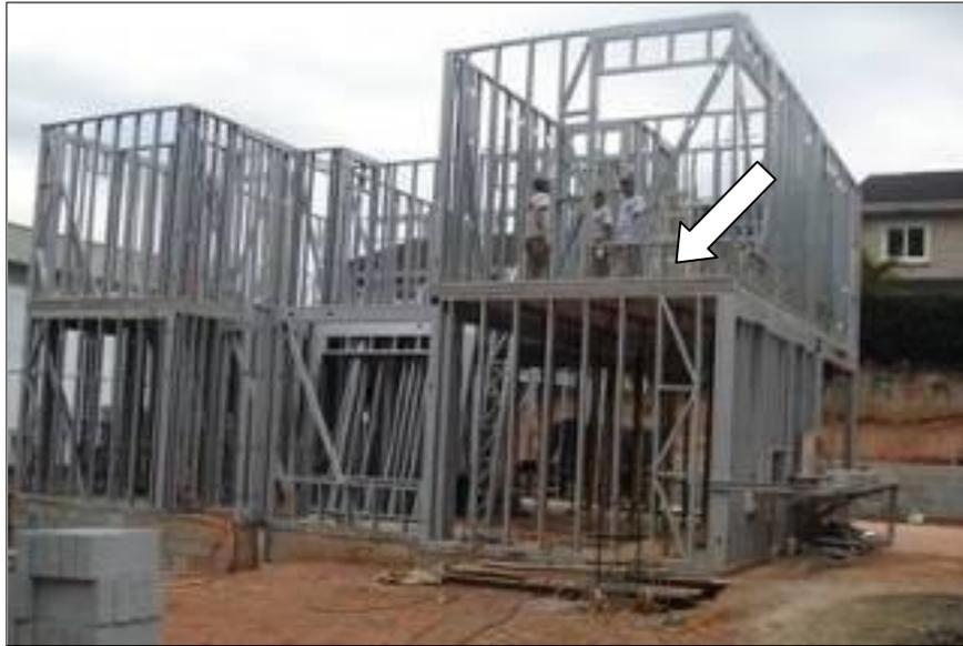
**Figura 4.3** - Uso de laje de concreto.
