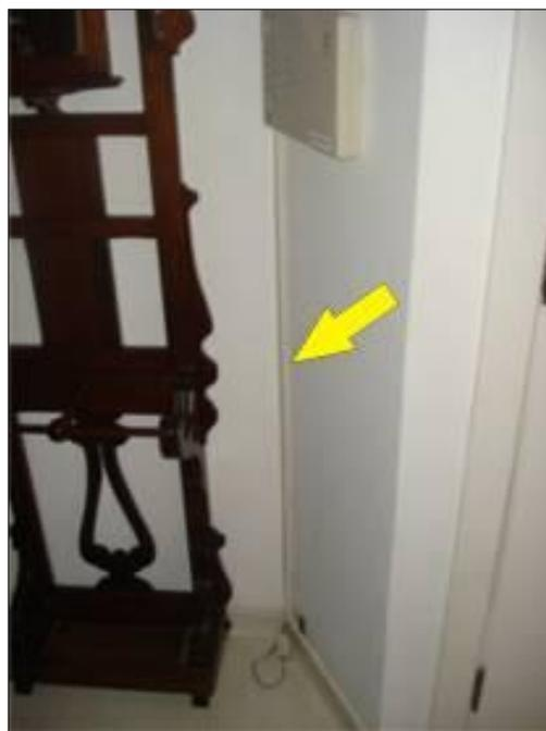
**Figura 4.5** - Uso de “canaletas” para passagem de fiação.
