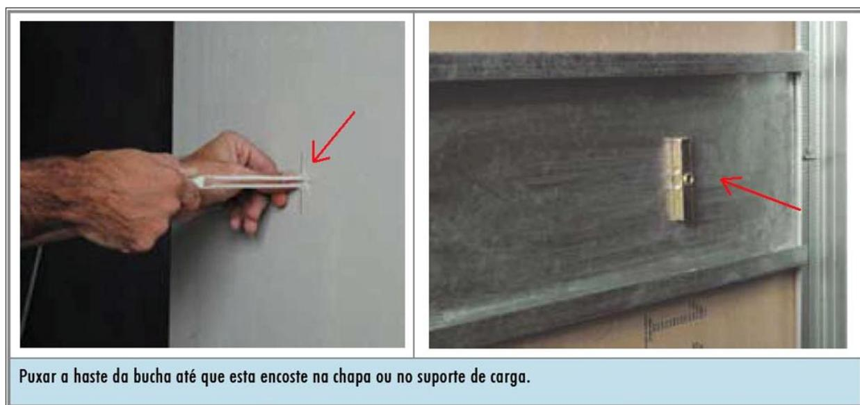
**Figura 5.14** - Cargas pesadas aplicadas/ reforço com suporte metálico.
