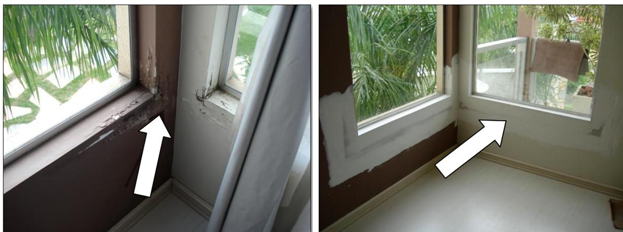
**Figura 5.13** - Reparo de patologia causada por infiltração nas esquadrias.
