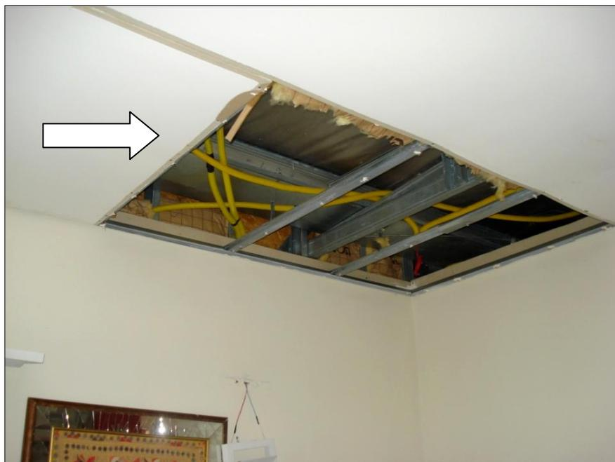
**Figura 5.12** - Descolamento do teto devido a problemas no sistema de coleta de água de chuva.
