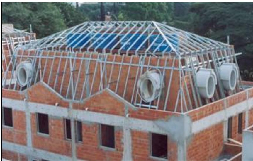
**Figura 1.7** - Telhado em LSF.
