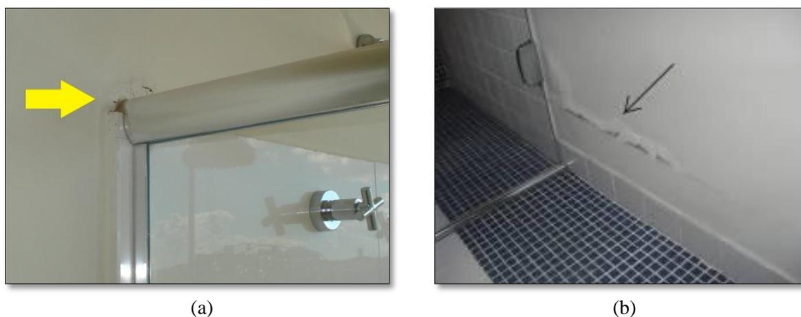
**Figura 4.6** - (a) Descascamento da pintura em área sem revestimento estanque/ (b) Patologia gerada por detalhe mal elaborado na fase de projeto.
