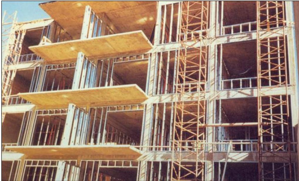
**Figura 1.6** - Fechamento em LSF, método embutido, em estrutura de concreto armado.
