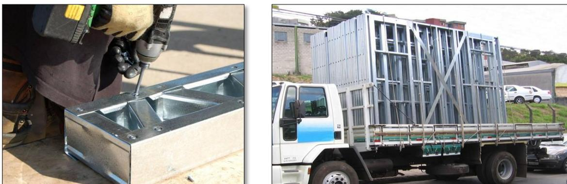
**Figura G3 -** Montagem dos painéis em fábrica/ Transporte de painéis montados.
