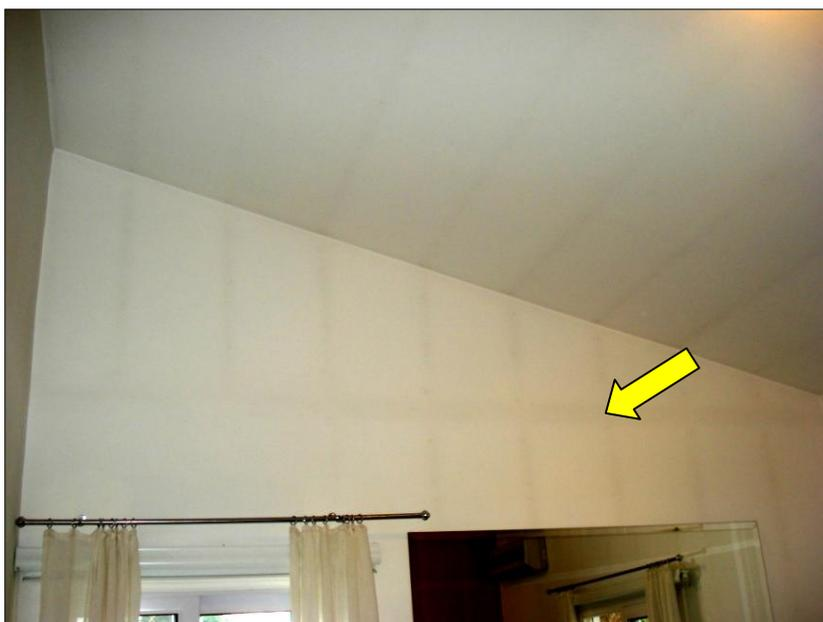
**Figura 4.2** - Condensação de água na superfície da estrutura.
