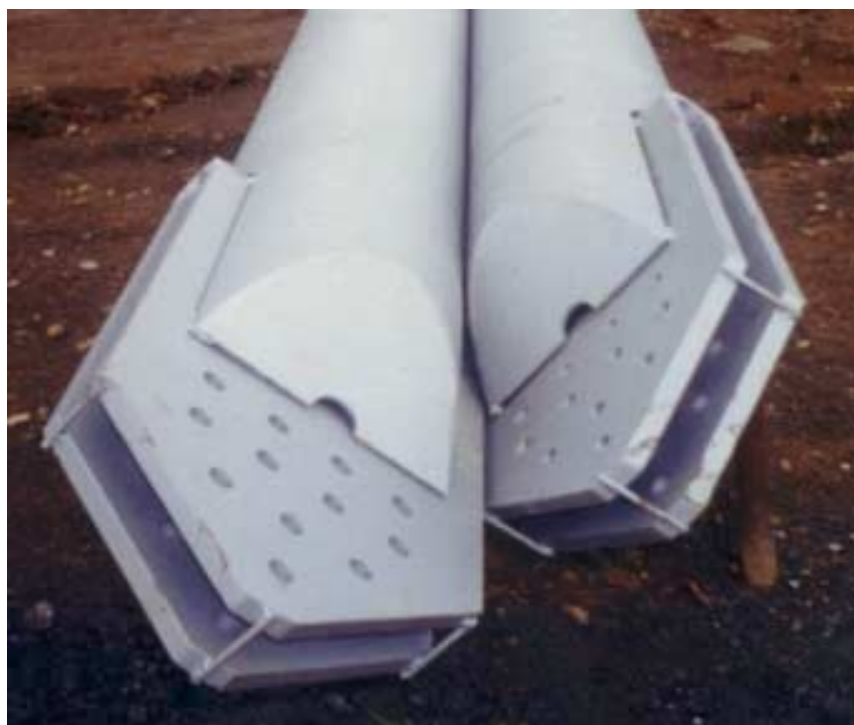
Foto II.6 – Detalhe das Extremidades das Barras – Pavilhão da Gameleira – BH/MG.
