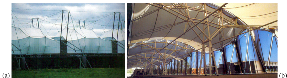
Figura 3.1 - Sistema suporte: (a) mastros e cabos; (b) pórticos (a) Schlumberger Laboratory, Cambridge, UK, 1984 – Fonte: EEKHOUT, p.26 (b) Estação de Metrô, Bruxelas – Fonte: BAHAMÓN, 2004, p.23.
