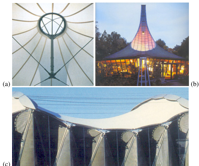
Figura 3.26 - Pontos de apoio da membrana – linhas de contato (casca, loop , arcos) (a) Truck Depot, Munich – Fonte: KOCH, 2004, p.193; (b) Institute Leichtbau, Stuttgart , 1967 – Fonte: BAHAMÓN, 2004, p.11; (c) Estação de Metrô, Bruxelas – Fonte: BAHAMÓN, 2004, p.23.
