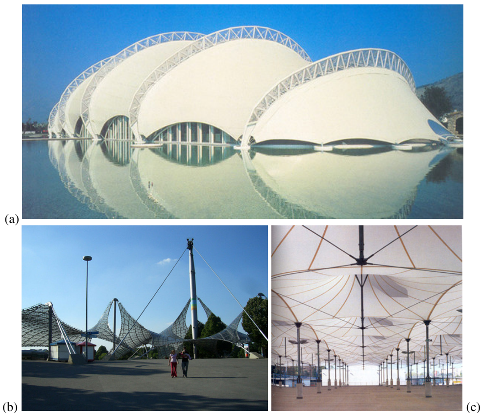
Figura 3.16 - Superfícies anticlásticas: (a) selas, (b) parabolóides hiperbólicos, (c) conóides (a) Laboratório de Investigação, Venafro , Itália – Fonte: BAHAMÖN, 2004, p.26.
