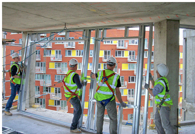
Figura 4.4 - Instalação de painel embutido de fachada em LSF, pré-montado em fábrica. Edifício residencial, Londres, Inglaterra
