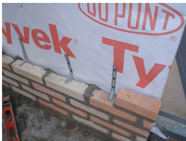
Figura 5.29 - Fechamento de alvenaria sobre painel OSB com manta de polietileno
