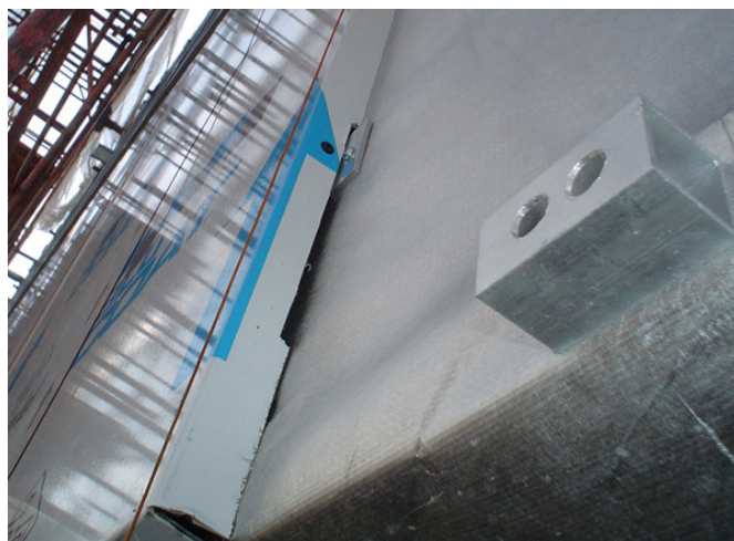
Figura 5.41 - Inserts para fixação de painel metálico sobre fechamento em LSF
