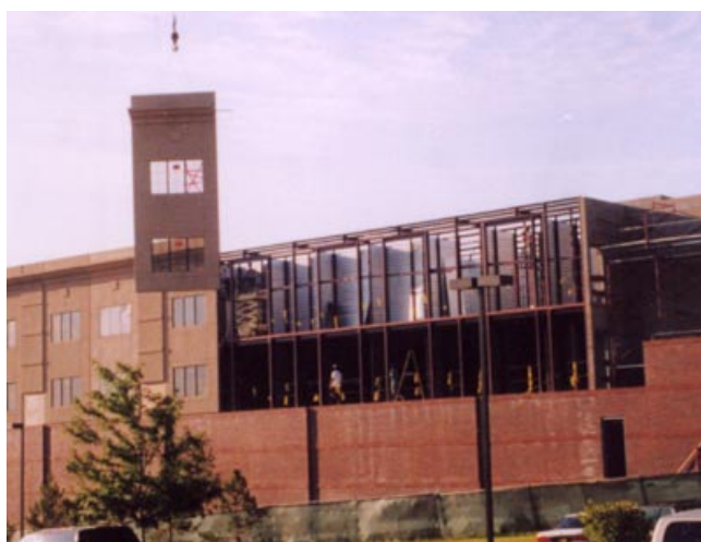
Figura 2.17 - Montagem de painéis pré-fabricados em LSF com acabamento executado previamente Fonte: AEGIS METAL FRAMING, 2007
