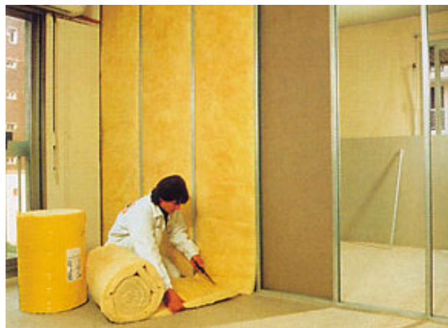
Figura 2.14 - Instalação de isolamento em lã de vidro Fonte: ISOVER, 2007
