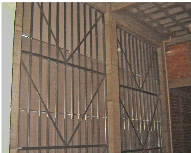
Figura 6.1 - Painel de fechamento em LSF com travamento horizontal e diagonal
