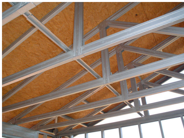
Figura 2.13 - Tesouras de cobertura em LSF
