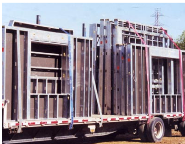
Figura 2.16 - Painéis em LSF produzidos em fábrica e transportados para obra Fonte: AEGIS METAL FRAMING, 2007
