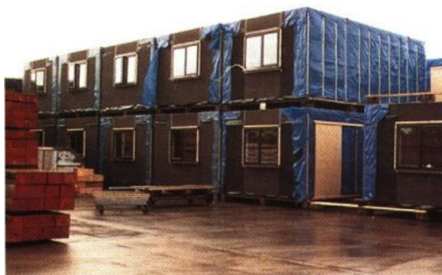
Figura 2.18 - Construção de edifício em módulos
