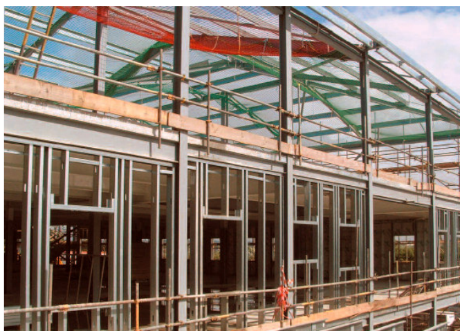
Figura 4.2 - Montagem de painéis de LSF embutidos, com estrutura principal em aço. Hospital Aintree, Inglaterra
