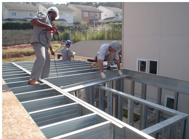
Figura 2.10 - Montagem de vigas da estrutura de piso
