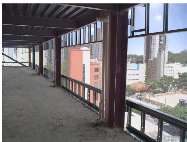
Figura 4.42 - Painel janela a janela em fachada de edifício com estrutura metálica. Edifício comercial, Belo Horizonte, MG
