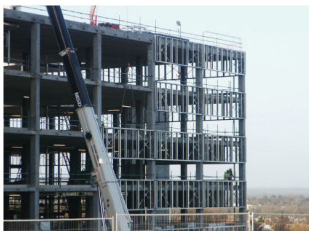
Figura 4.38 - Montagem de painéis janela a janela em fachada de edifício em concreto armado. John Radcliffe Hospital, Inglaterra
