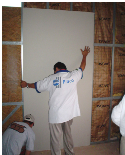
Figura 5.30 - Instalação de placa de gesso cartonado
