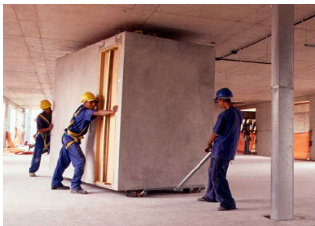
Figura 2.19 - Montagem de módulo de banheiro. Edifício de Hotel, São Paulo
