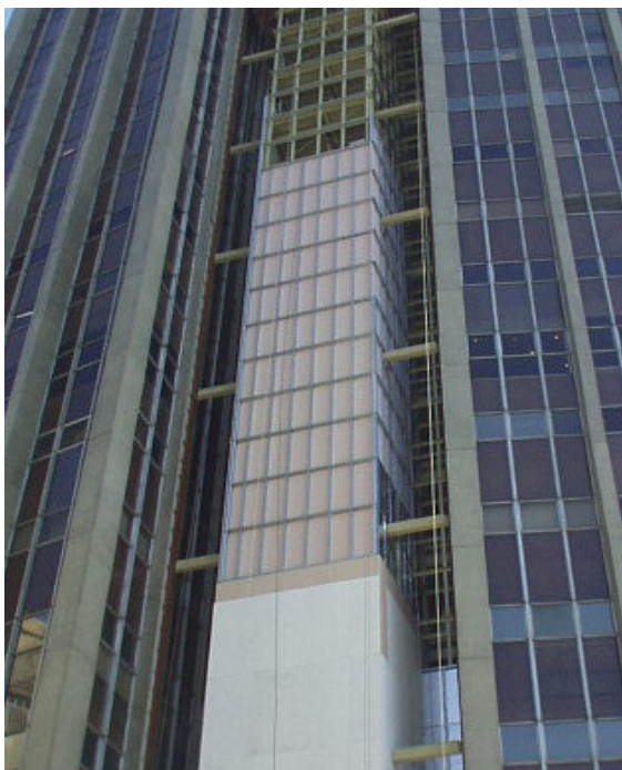
Figura 4.19 - Execução de painel contínuo em retrofit de edifício comercial. Rio de Janeiro, RJ
