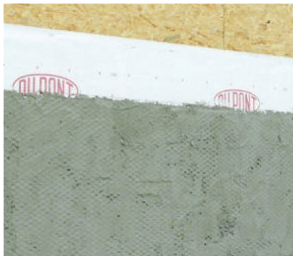
Figura 5.12 - Revestimento de argamassa aplicado sobre placas de OSB com manta de polietileno e tela de aço expandida
