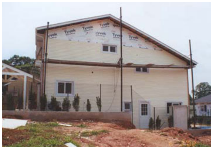
Figura 5.4 - Execução de siding vinílico sobre membrana de polietileno e OSB Fonte: MADEX, 2007
