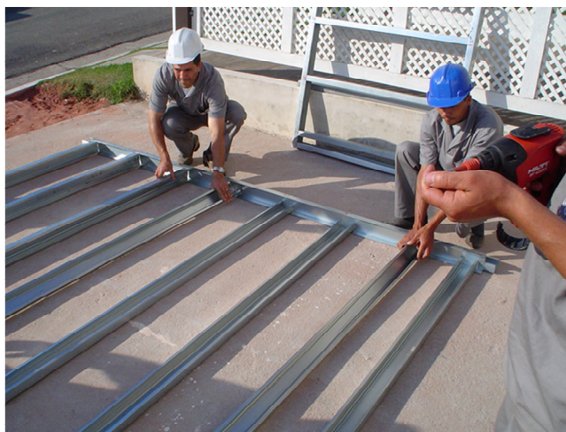
Figura 2.15 - Montagem de painel em LSF no canteiro de obras
