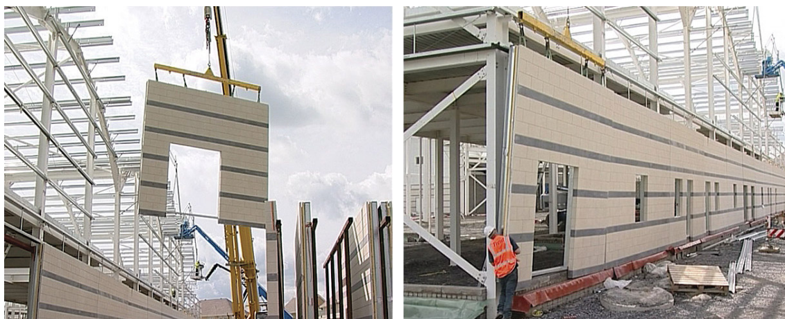
Figura 5.1 - Instalação de painel de LSF com acabamento cerâmico pré-executado. Centro Comercial, Carlow, Irlanda
