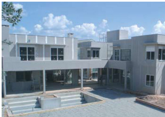
Figura 5.19 - Execução de fechamento externo em placa cimentícia
