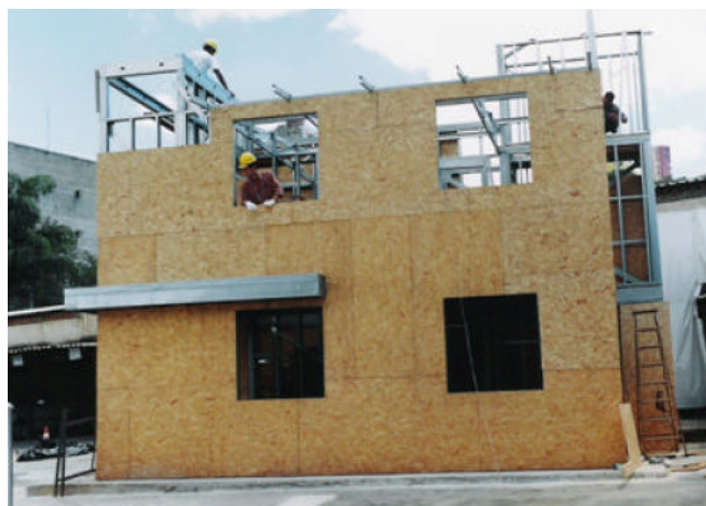
Figura 5.2 - Instalação de placas de OSB na fachada
