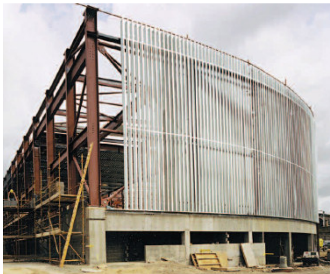
Figura 4.18 - Montagem de painel contínuo de fachada. Centro de vivência, New Castle, Inglaterra.
