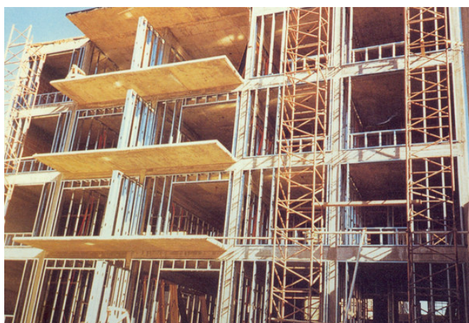
Figura 4.3 - Fechamento em LSF, método embutido, em estrutura de concreto armado. Edifício residencial, San Nicolás, Argentina
