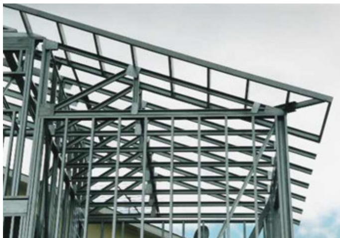
FIGURA 3.10 – Estrutura do telhado de uma residência em LSF. Fonte: CRASTO, 2005, p. 15.
