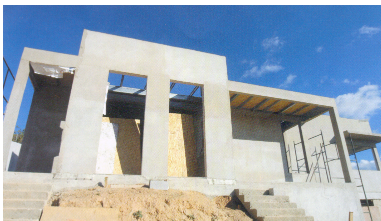
FIGURA 3.23 –. Revestimento externo em EIFS. Fonte: BONITESE, 2006, p. 10.
