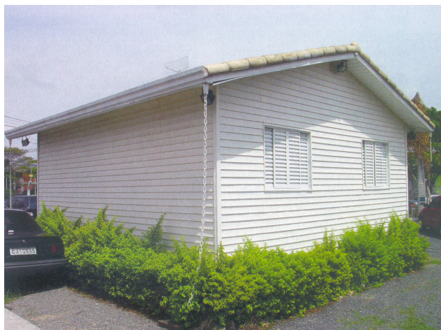
FIGURA 3.15 – Acabamento em Siding vinílico. Fonte: CASTRO, 2006, p. 77.
