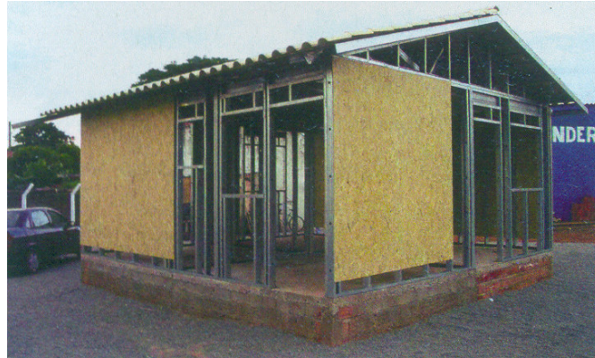
FIGURA 4.7 – Aplicação de chapa de OSB.
