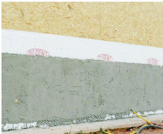
FIGURA 3.16 – Restimento das placas de OSB com argamassa aplicada sobre tela de galinheiro. Fonte: CRASSTO, 2005, p. 135.
