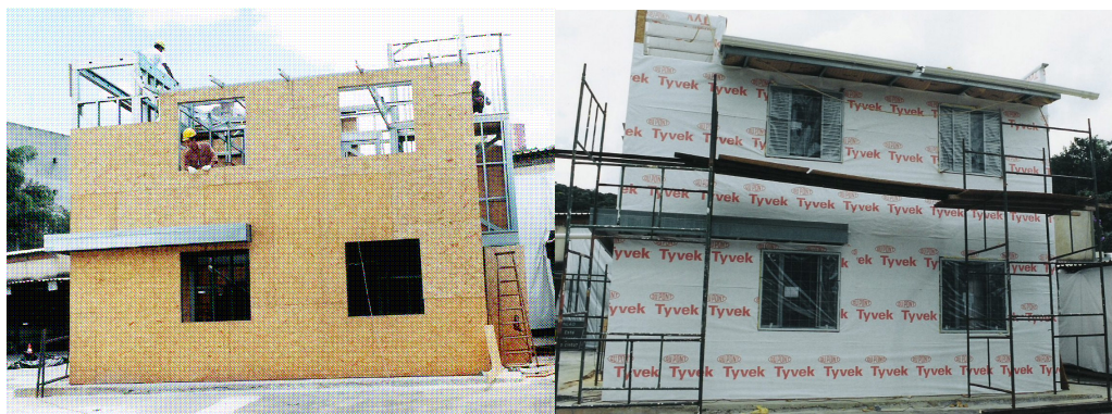
FIGURA 3.13 – Fachada com fechamento externo em OSB e placas de OSB impermeabilizadas. Fonte: CRASTO, 2005, p. 127 e 128.
