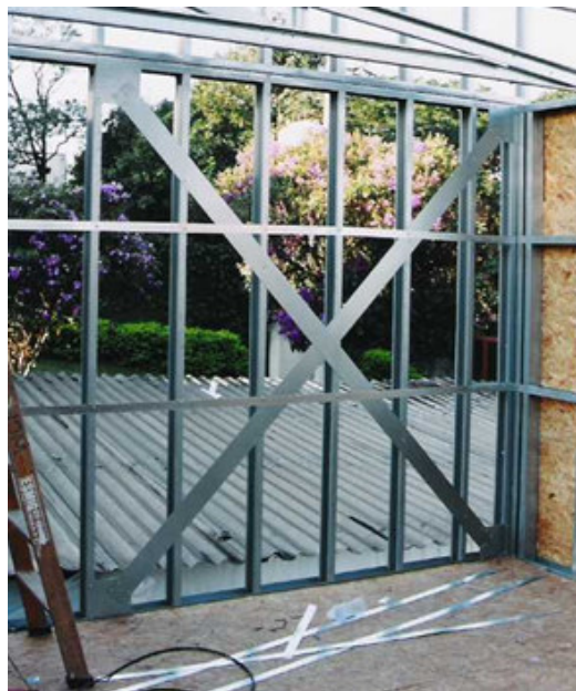
FIGURA 3.6 – Pannel com contraventamento em “X”. Fonte: CRASTO, 2005, p. 49.
